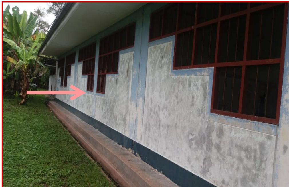
la I.E Milagros, se observa la infraestructura en mal estado por las intensas lluvias y mal funcionamiento de los drenajes.
