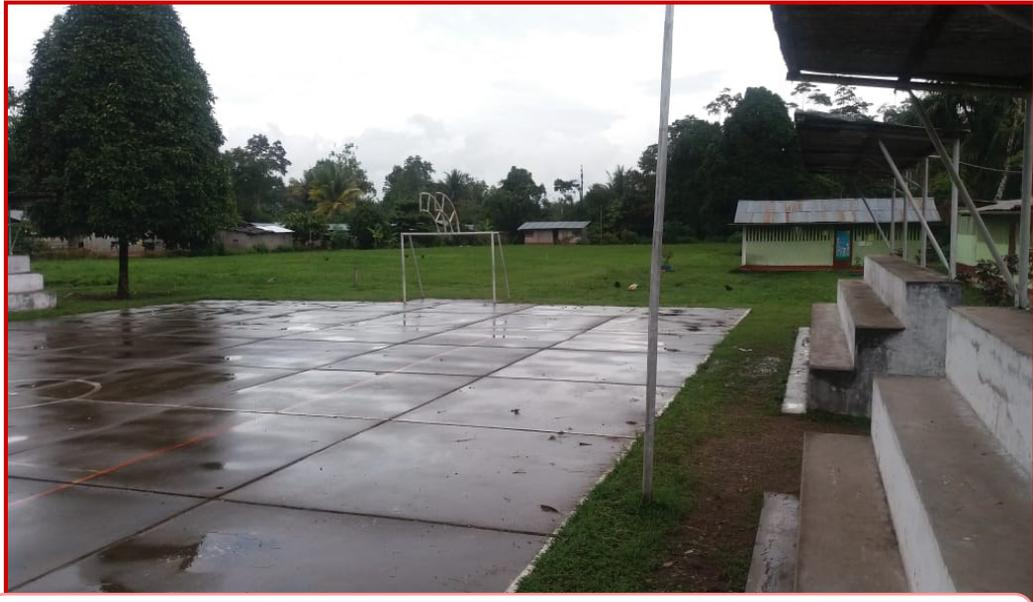
En la I.E Milagros, La losa deportiva fue construido sin criterio técnico requerido, porque tiene 7 cm de espesor.
