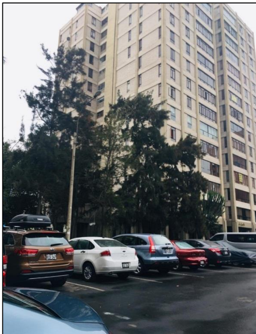
Edificio Los olivos
