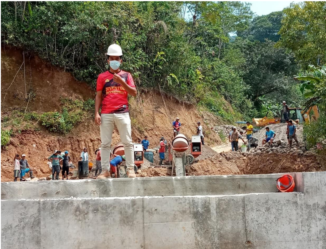
Inspección de llenado de concreto en solado para estribo izquierdo de puente Varela
