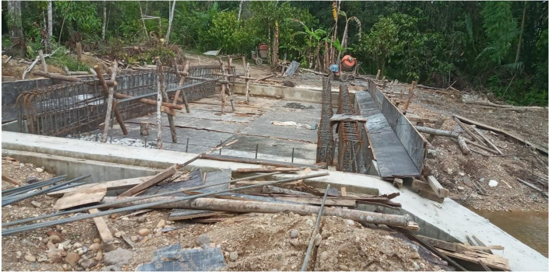
Encofrado de plataforma de pontón Villa Rica
