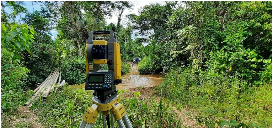
Figura 20 Realizando la toma de puntos en el caserío de Villa Rica
