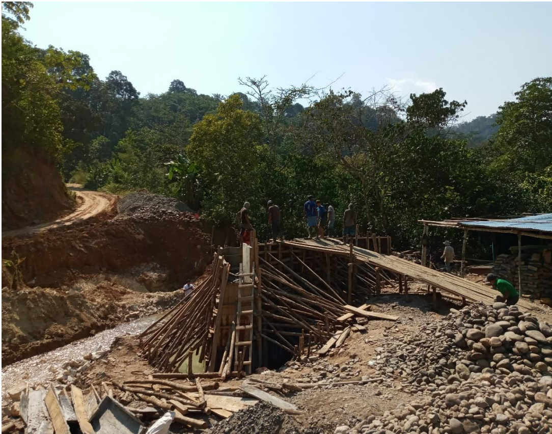
Encofrado de estribo derecho puente Enrique Varela L=13 m
