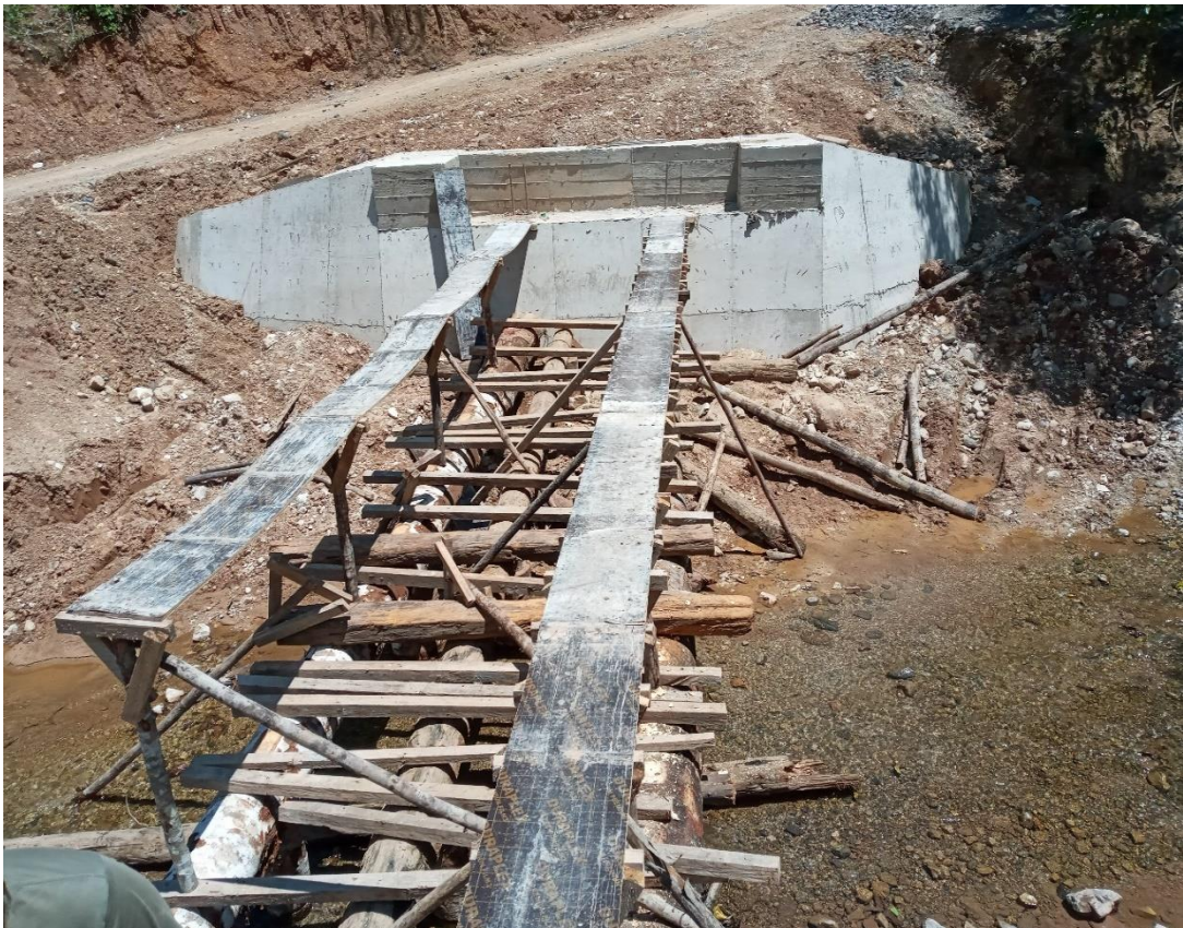
Inspección de encofrado de vigas principales sobre falso puente - puente Varela
