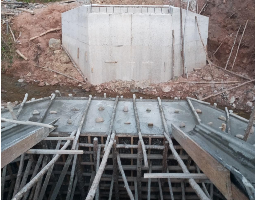
Verificación de llenado de concreto en estribos puente Pacae
