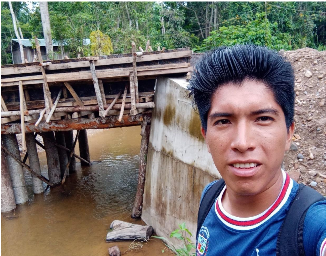
Verificación de encofrado de plataforma de pontón Villa Rica
