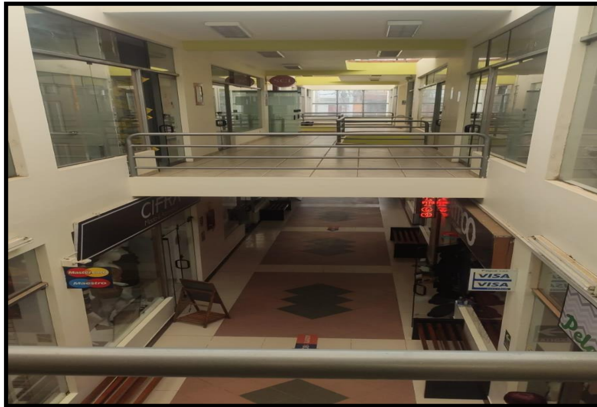
Figura 17 Detalle De Interior De La Galería
