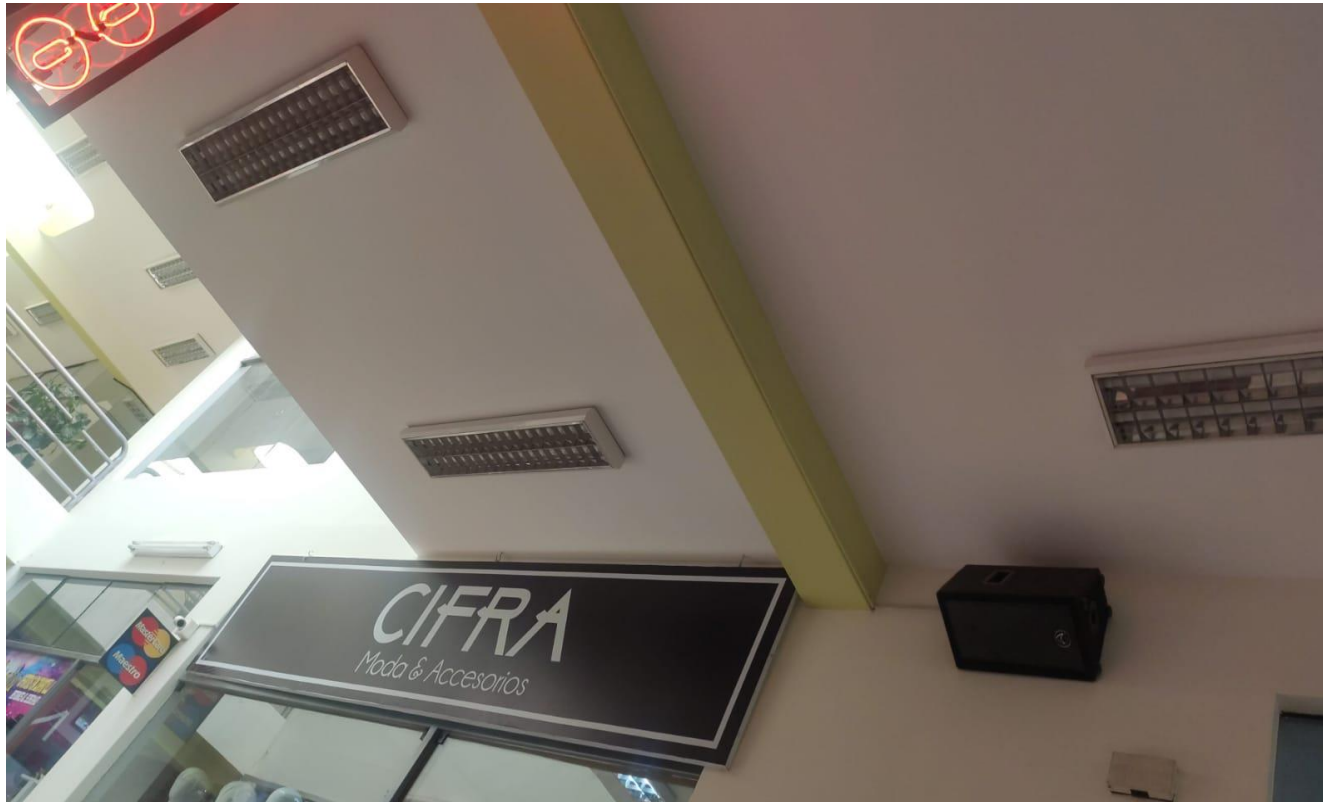
Figura 20 Detalle De Interiores De La Galería Comercial
