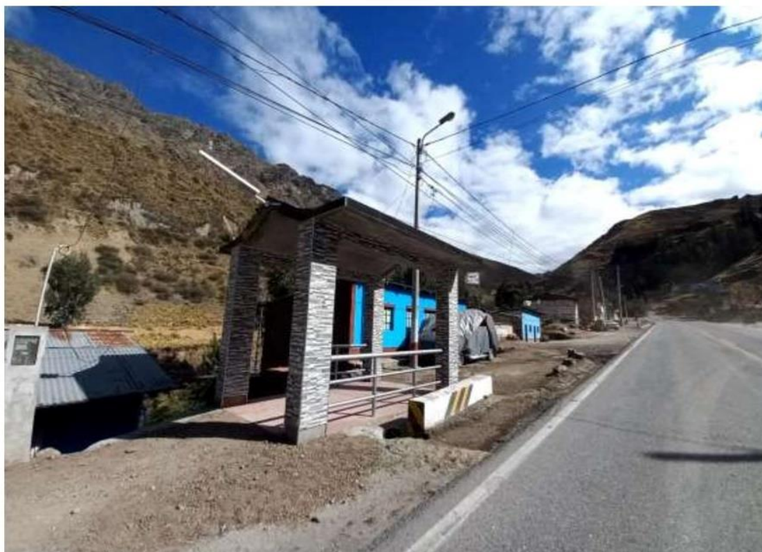
En la fotografía se observa el puente peatonal N° 03 casi acabado.
