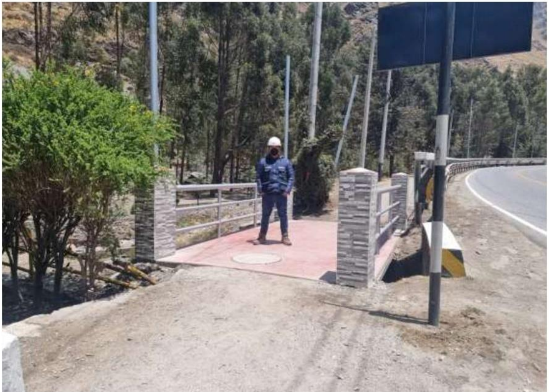
En la fotografía se observa el puente peatonal N° 06 culminado.
