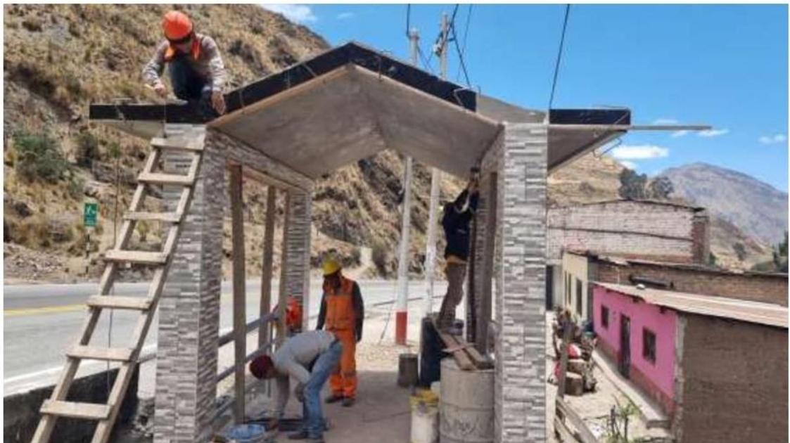
En la fotografía se observa el enchapado de friso de losa maciza en el puente peatonal N° 01.
