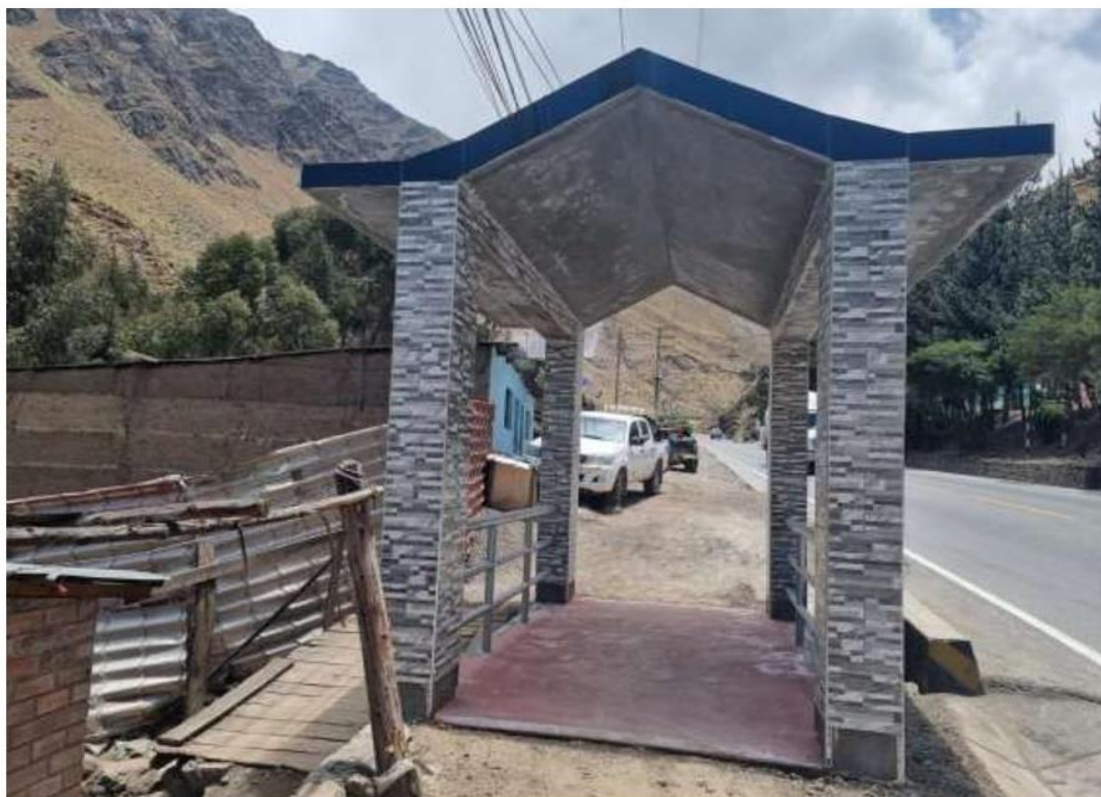
En la fotografía se observa el puente peatonal N° 02 casi acabado.
