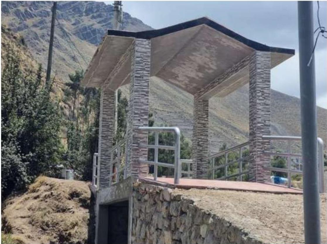
En la fotografía se observa los trabajos de soldadura en el puente peatonal N° 04.
