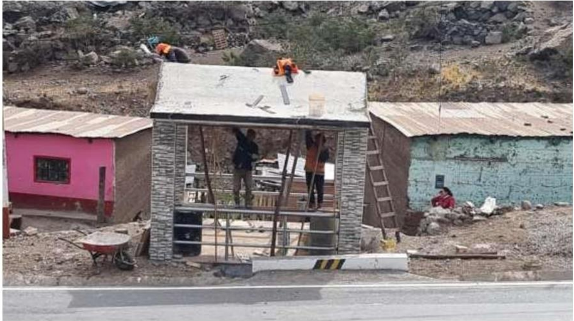
Se observa el enchapado de columnas, vigas y friso de losa maciza de puente peatonal N° 01
