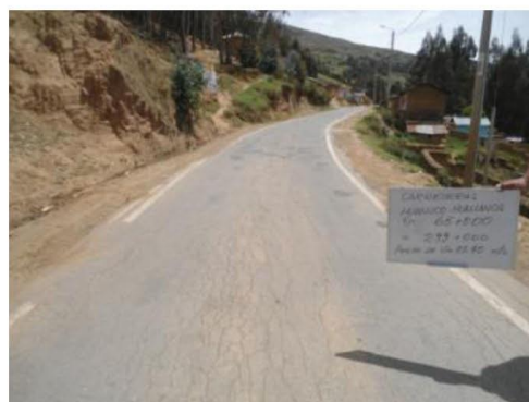
Figura14Tramo Km 65+000 - Km 66+000
