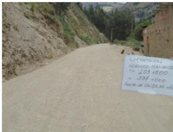
Figura52Tramo Km 103+000 - Km 104+000
