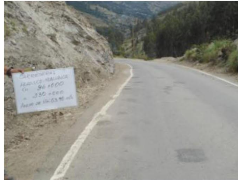
Figura45 Tramo Km 96+000 - Km 97+000
