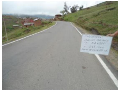
Figura 3 Tramo Km 54+000 - Km 55+000
