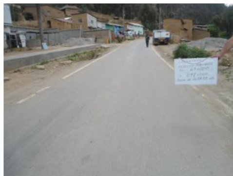
Figura12Tramo Km 63+000 - Km 64+000
