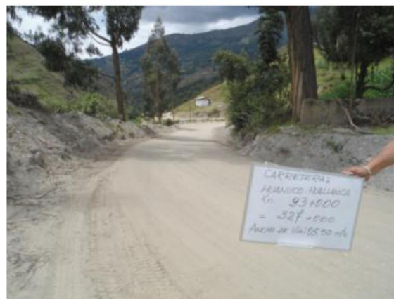
Figura42Tramo Km 93+000 - Km 94+000
