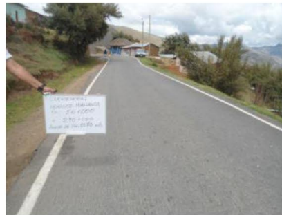
Figura 5 Tramo Km 56+000 - Km 57+000
