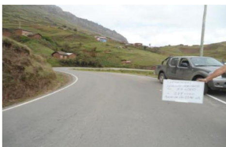
Figura 2: Tramo Km 52+350 - Km 54+000
