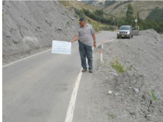
Figura49 Tramo Km 100+000 - Km 101+000
