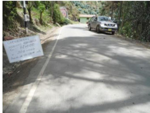
Figura21Tramo Km 72+000 - Km 73+000
