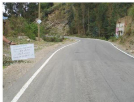
Figura44Tramo Km 95+000 - Km 96+000
