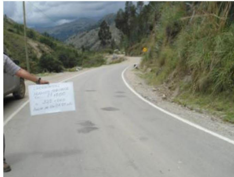
Figura37Tramo Km 88+000 - Km 89+000
