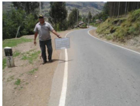
Figura26Tramo Km 77+000 - Km 78+000
