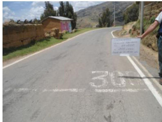
Figura15Tramo Km 66+000 - Km 67+000
