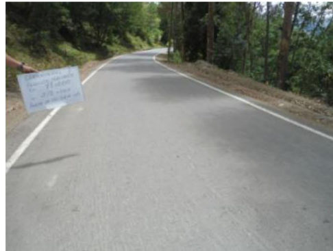
Figura27Tramo Km 78+000 - Km 79+000
