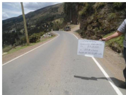
Figura24Tramo Km 75+000 - Km 76+000
