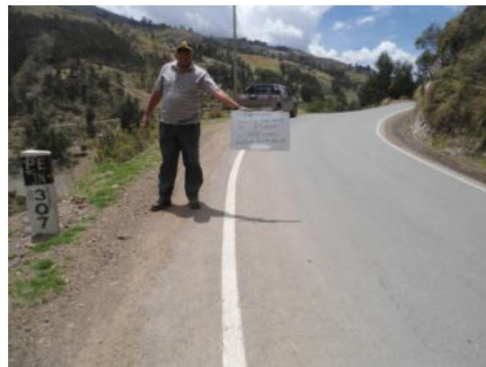
Figura22Tramo Km 73+000 - Km 74+000
