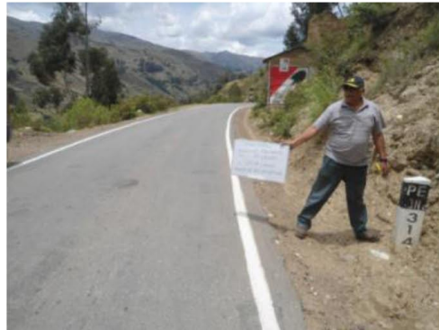
Figura29 Tramo Km 80+000 - Km 81+000
