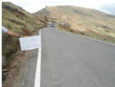
Figura 6 Tramo Km 57+000 - Km 58+000
