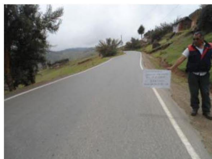
Figura4Tramo Km 55+000 - Km 56+000
