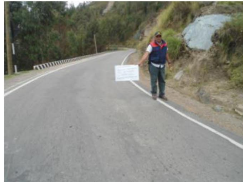
Figura17Tramo Km 68+000 - Km 69+000
