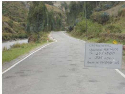
Figura50 Tramo Km 101+000 - Km 102+000
