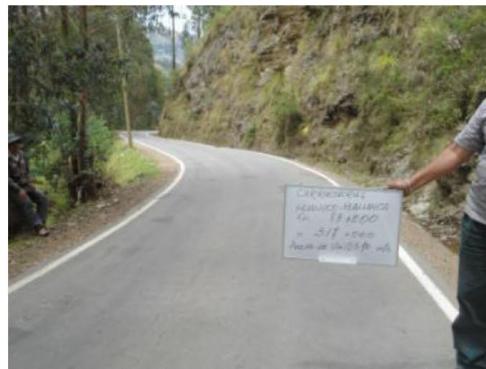
Figura32Tramo Km 83+000 - Km 84+000
