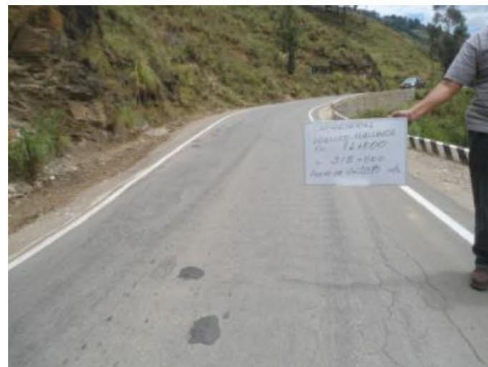
Figura30 Tramo Km 81+000 - Km 82+000
