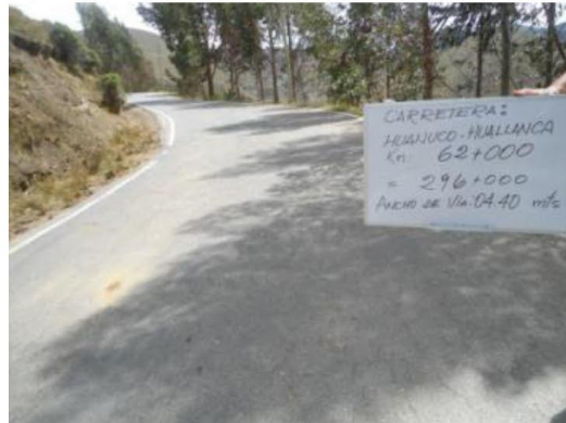
Figura11Tramo Km 62+000 - Km 63+000
