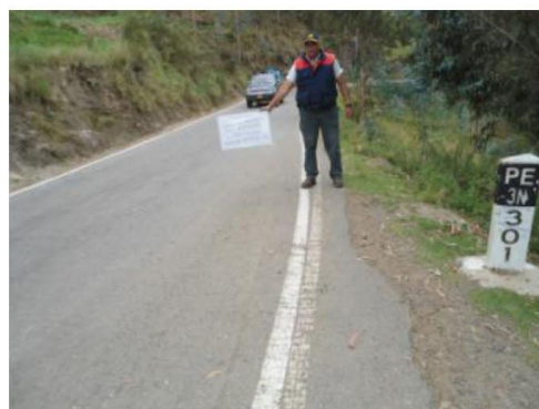
Figura16Tramo Km 67+000 - Km 68+000
