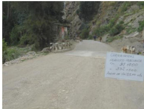
Figura47 Tramo Km 98+000 - Km 99+000
