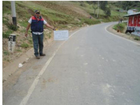
Figura19Tramo Km 70+000 - Km 71+000
