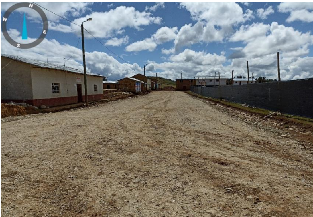
En la fotografía de observa el compactado de la base de afirmado
