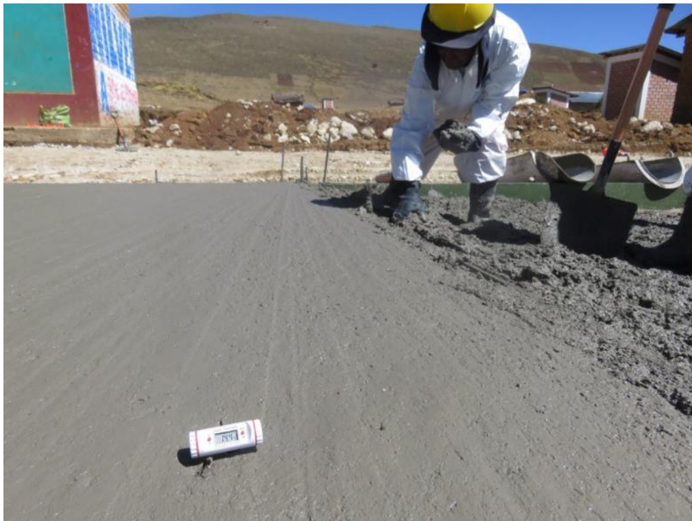
Se verifica el grado de temperatura del concreto.
