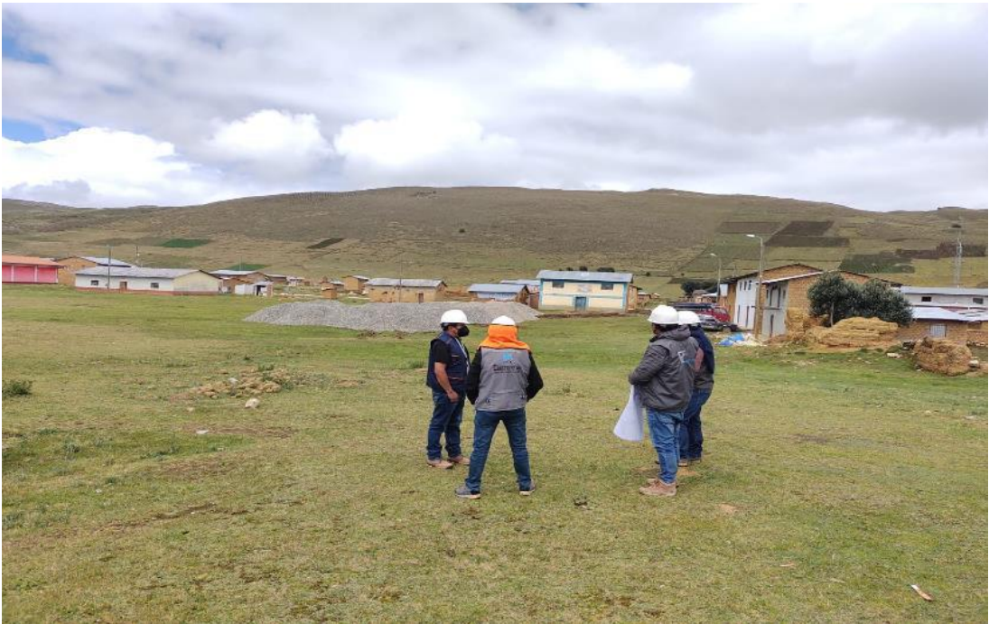
En la imagen se realiza las coordinaciones con la supervisión y residencia para el inicio de obra
