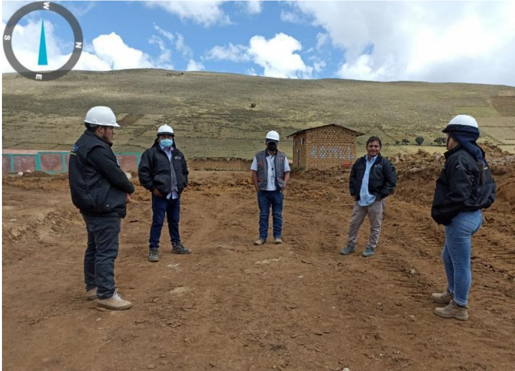
Se observa las recomendaciones realizada por parte de la supervisión.
