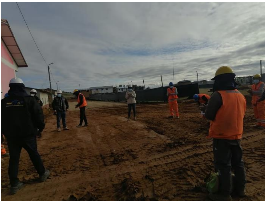
En la fotografía se observa la charla diaria realizada por el personal de ssoma y equipo técnico.
