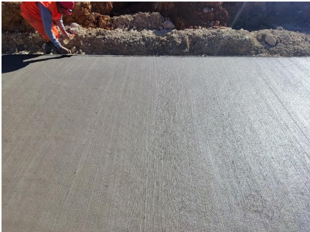
Se realizan los trabajos de acabado de la losa de concreto haciendo que sea una superficie rugosa
