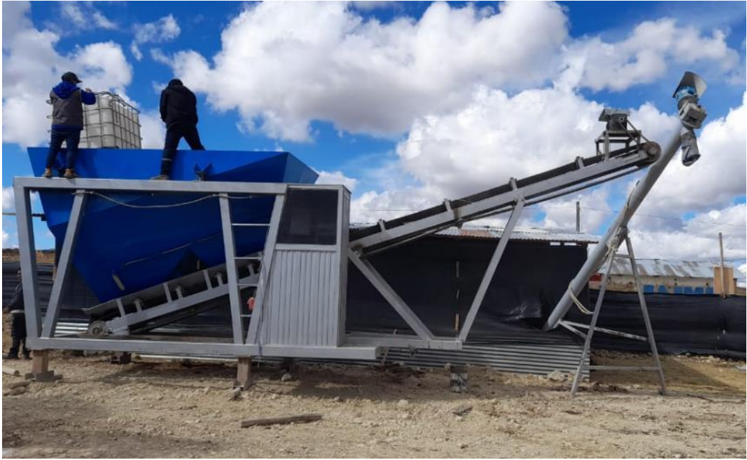
Se observa la planta concretara instalada en obra para un mayor avance en la ejecución de trabajos de vaciado
