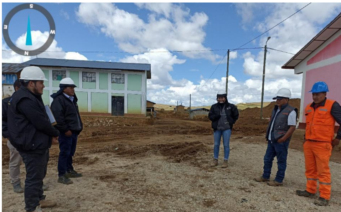
Se observa las recomendaciones realizada por parte de la supervisión.
