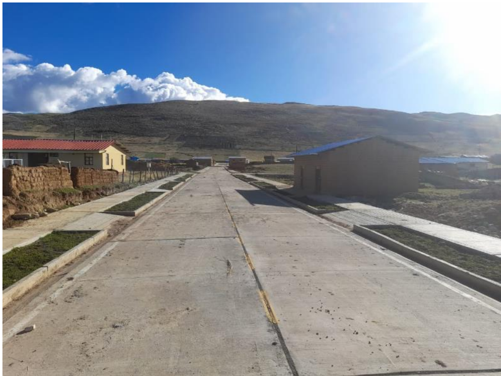
Se observan las calles con los trabajos ya culminados de la construcción de pavimentación
