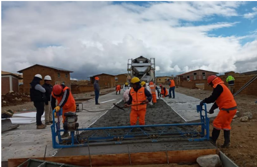
Se realiza los trabajos de vibrado y nivelado con el uso de la regla vibratoria
