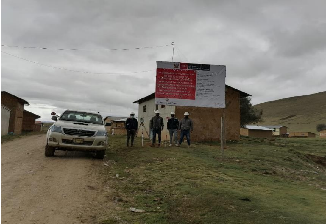
En la imagen se observa la colocación del cartel de obra
