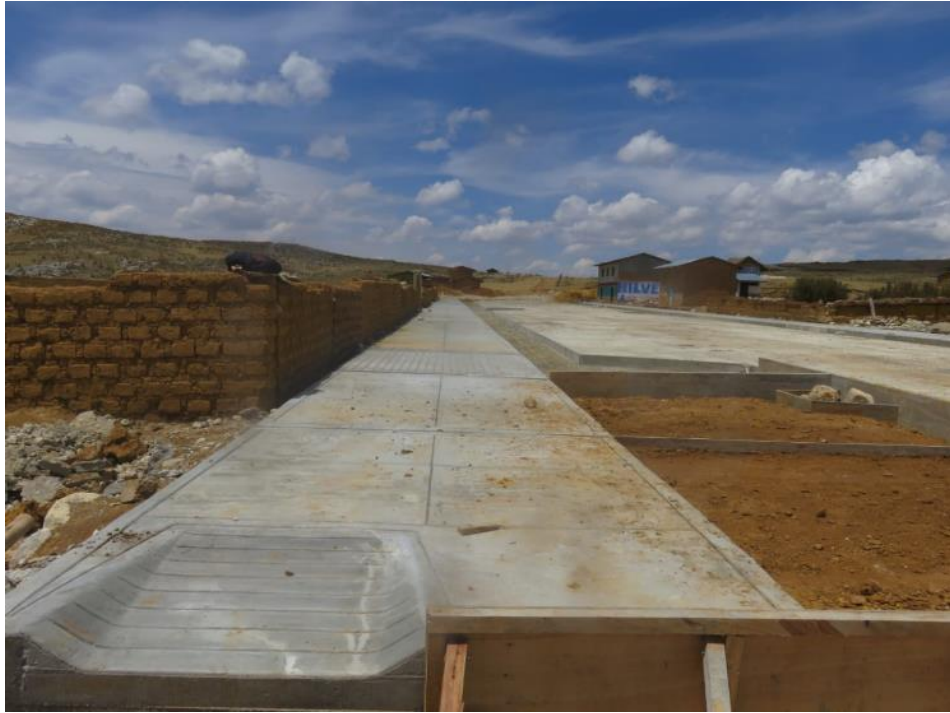
Se observa del acabado de la vereda y rampas con su bruñido y juntas según los planos
