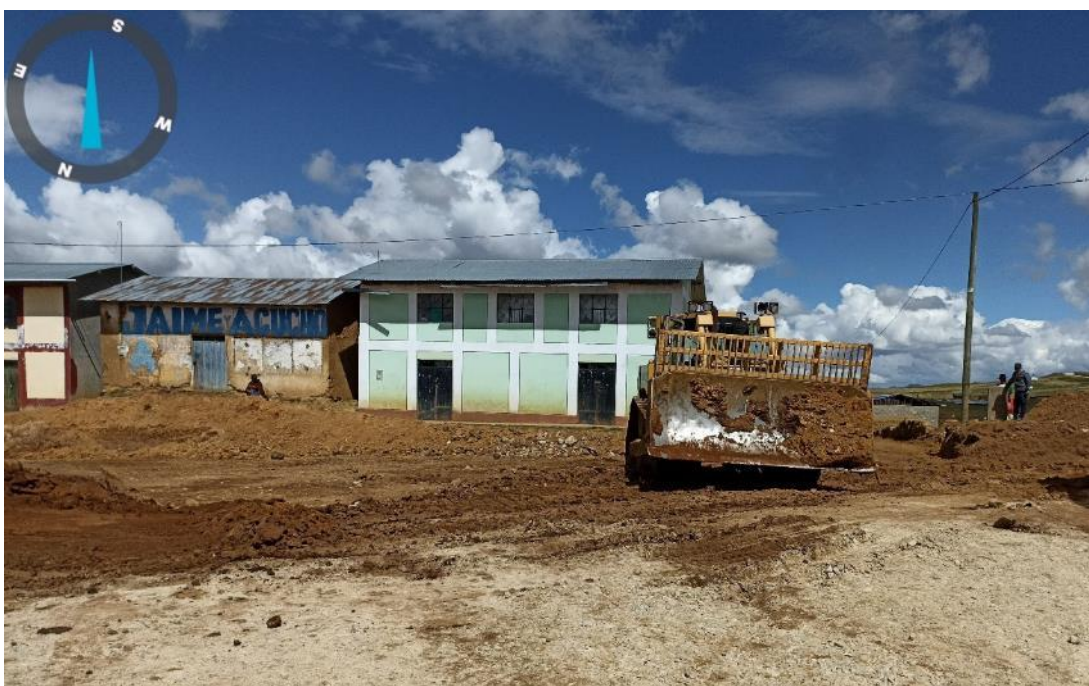
En la fotografía se observa a la maquinaria realizar los trabajos de corte de terreno a nivel de rasante
