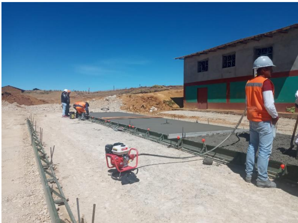
Se realiza el proceso de regleado y vibrado del concreto fresco
