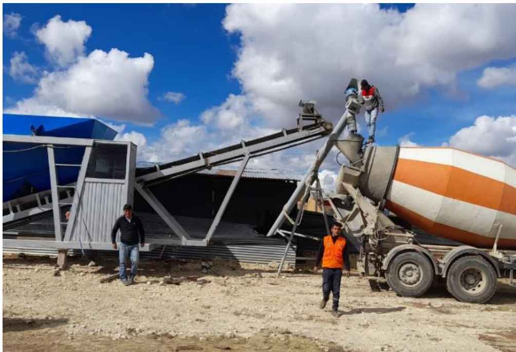
Se observa la planta concretara instalada en obra para un mayor avance en la ejecución de trabajos de vaciado
