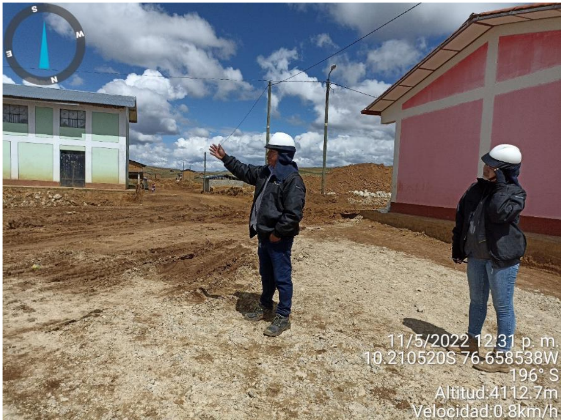
Se observa las recomendaciones realizada por parte de la supervisión.
