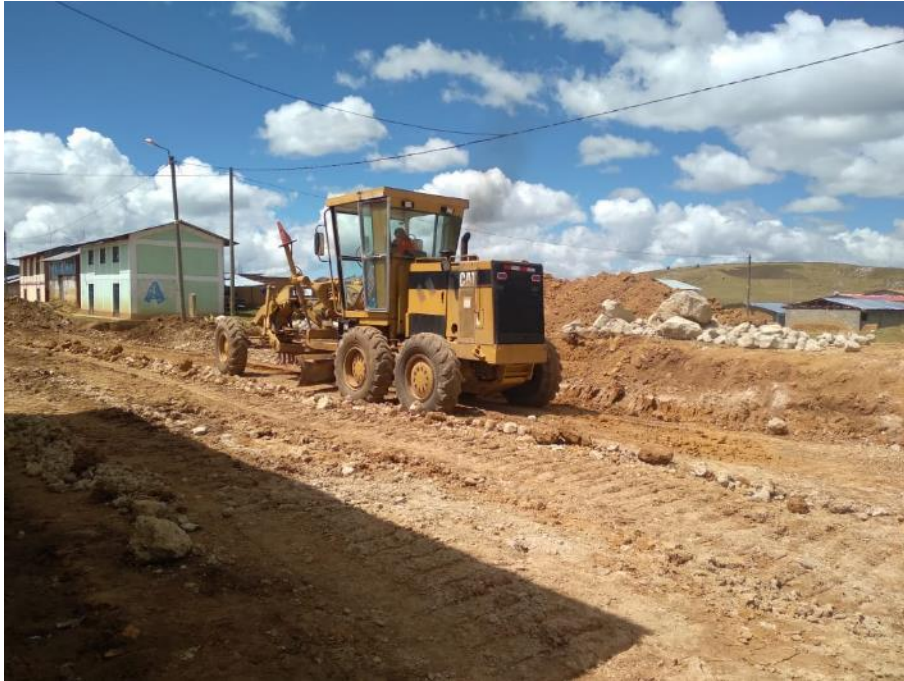
En la fotografía se observa la maquinaria realizando los trabajos de tendido de material afirmado
