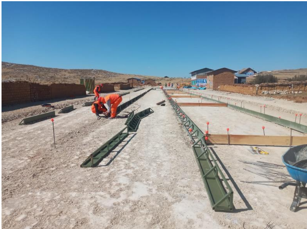
Se realizan los trabajos de encofrado de la losa
