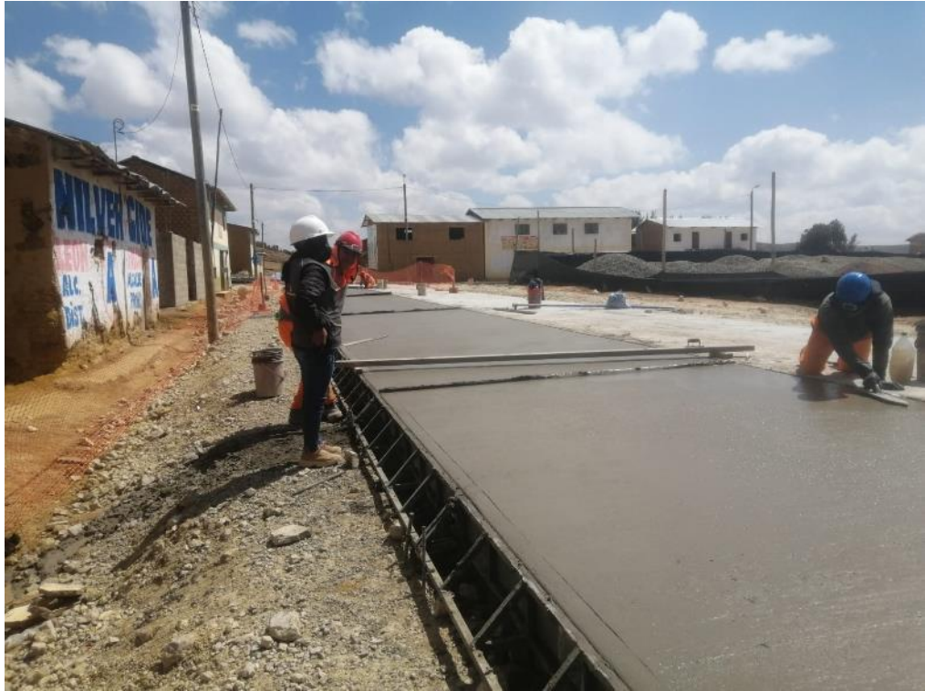
Se realizan los trabajos de acabado de la losa de concreto
