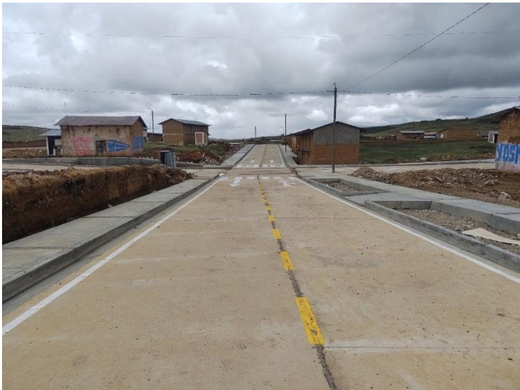
Se observan las calles con los trabajos ya culminados de la construcción de pavimentación
