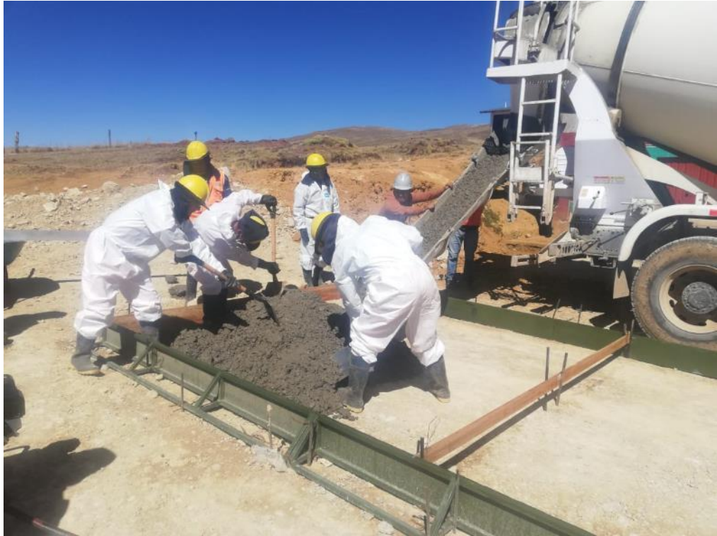
Se realizan los trabajos de vaciado de concreto en la superficie del terreno ya encofrado.
