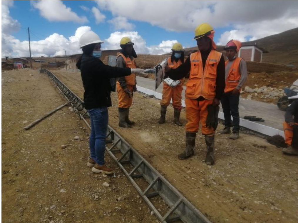
Se observa la entrega de guantes para la manipulación del concreto.
