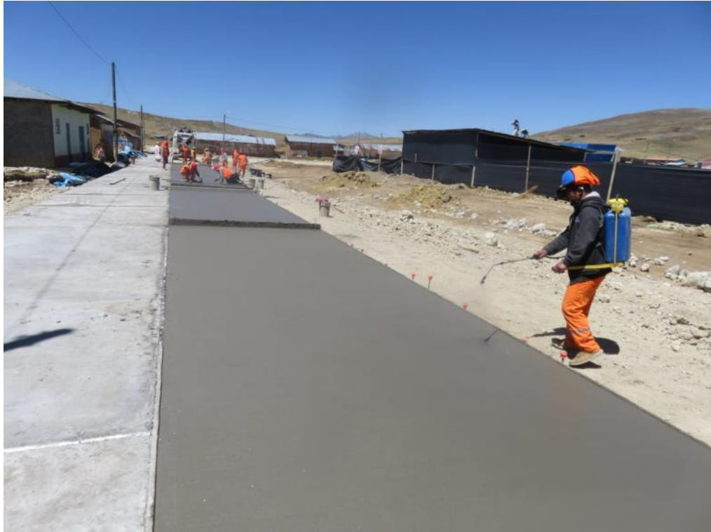
Se realiza el curado de la losa con aditivos.
