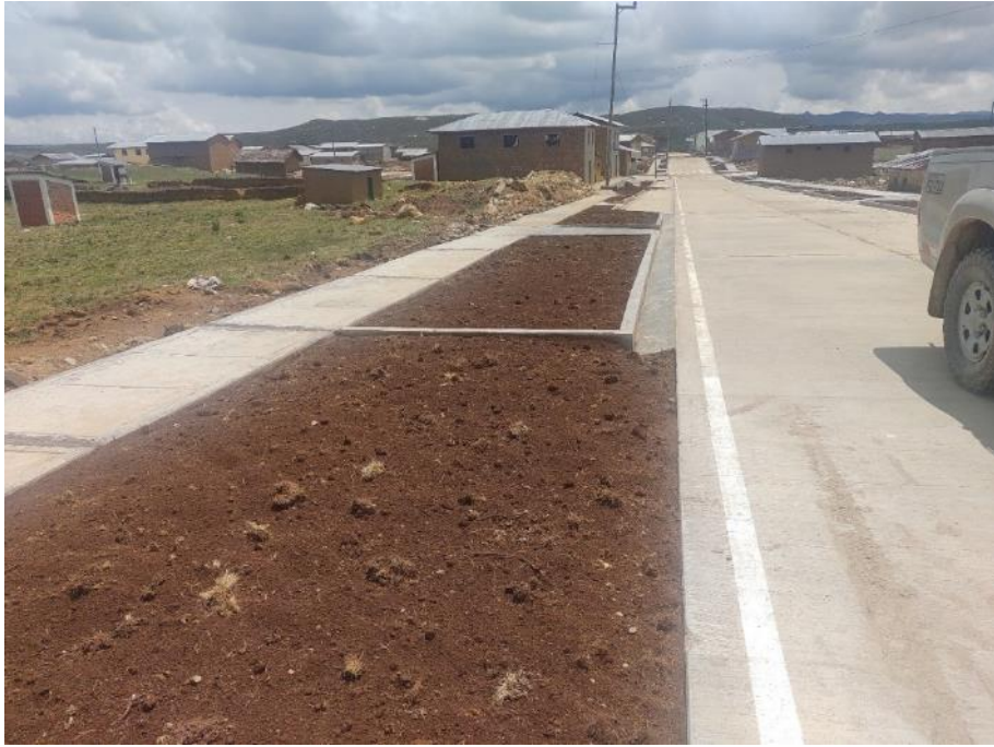
Se observan las calles con los trabajos ya culminados de la construcción de pavimentación
