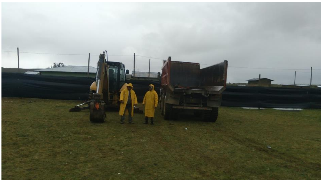
En la fotografía se visualiza la maquinaria quesera empleado en la ejecución de la obra
