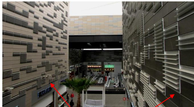
Figura 22 sistema de fachada ventilada
