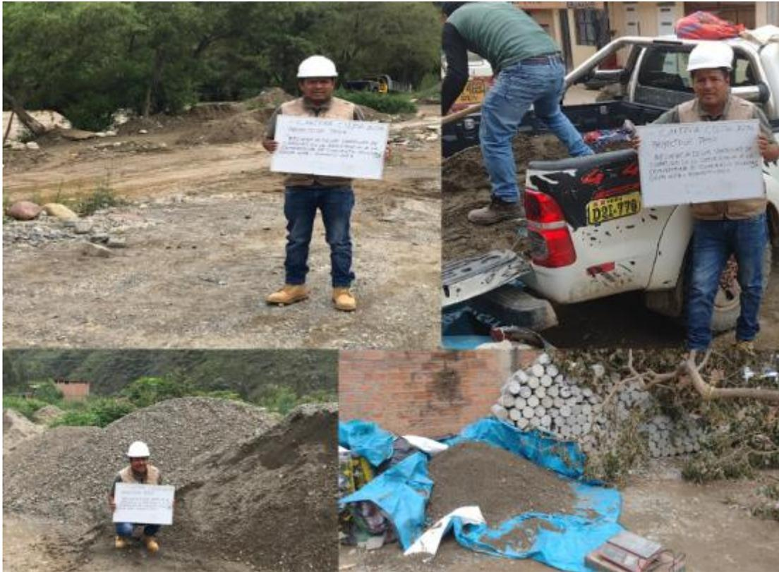
Peso de los agregados y selección de probetas para la elaboración de la dosificación del concreto patrón  $f'c=210 \text{ kg/cm}^2$ .
