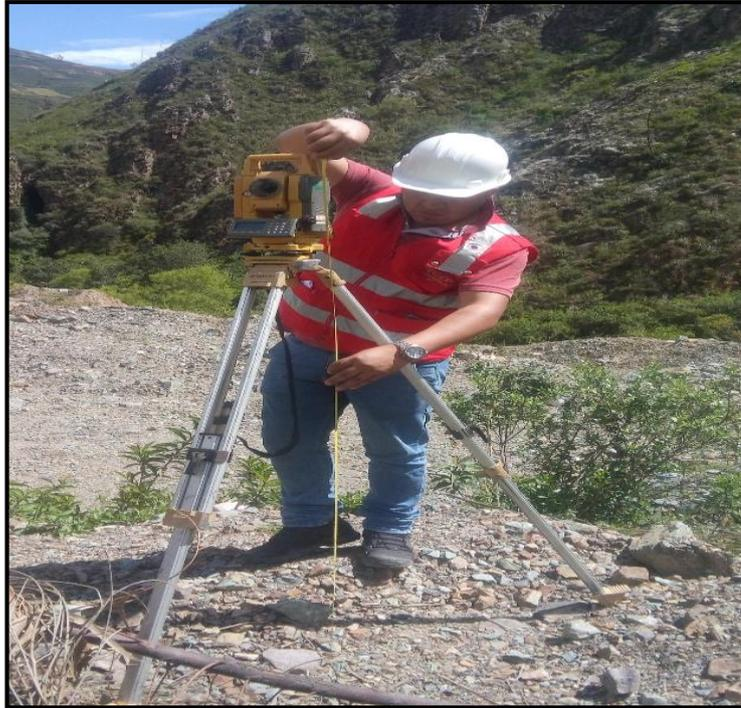
*Nota.* La figura muestra el proceso del levantamiento topográfico.
