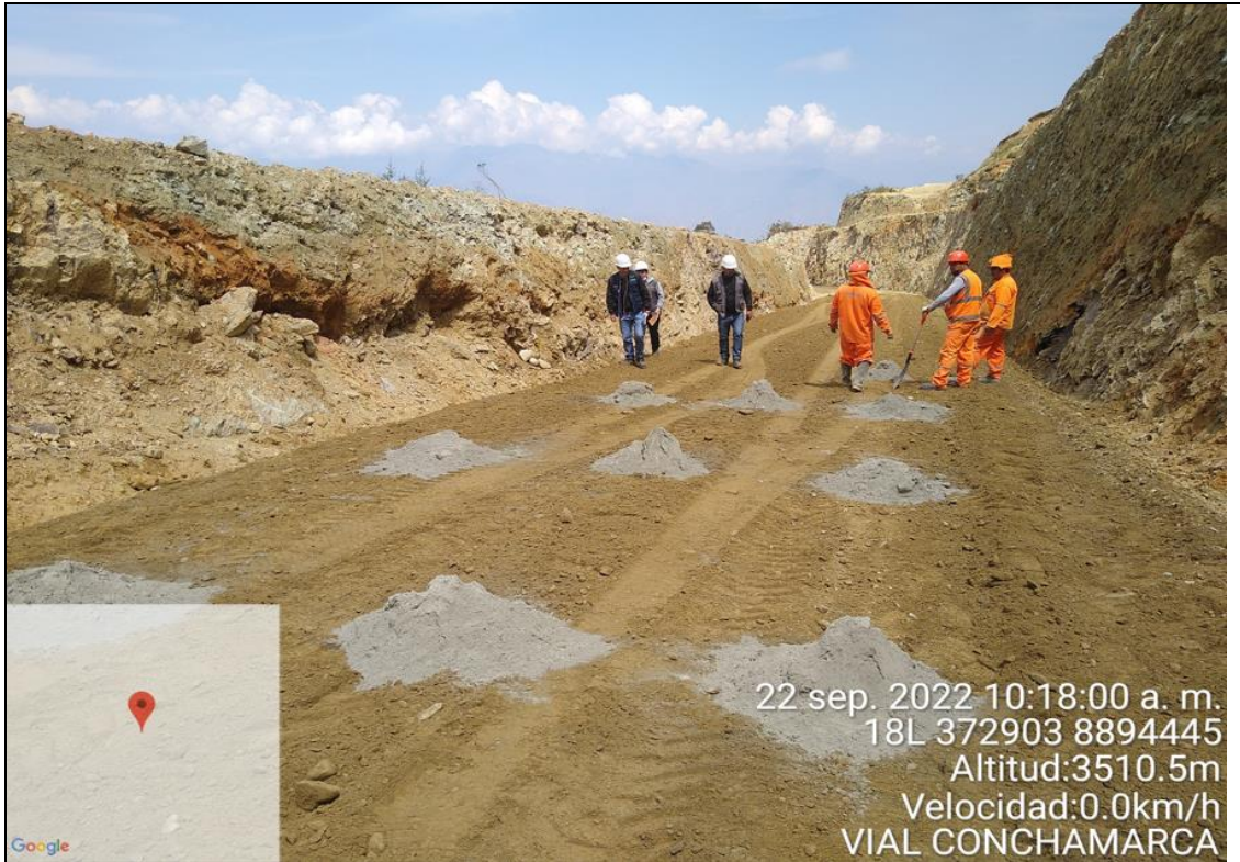
Verificando el vertido del cemento al material para la dosificación in situ del tramo de prueba.
