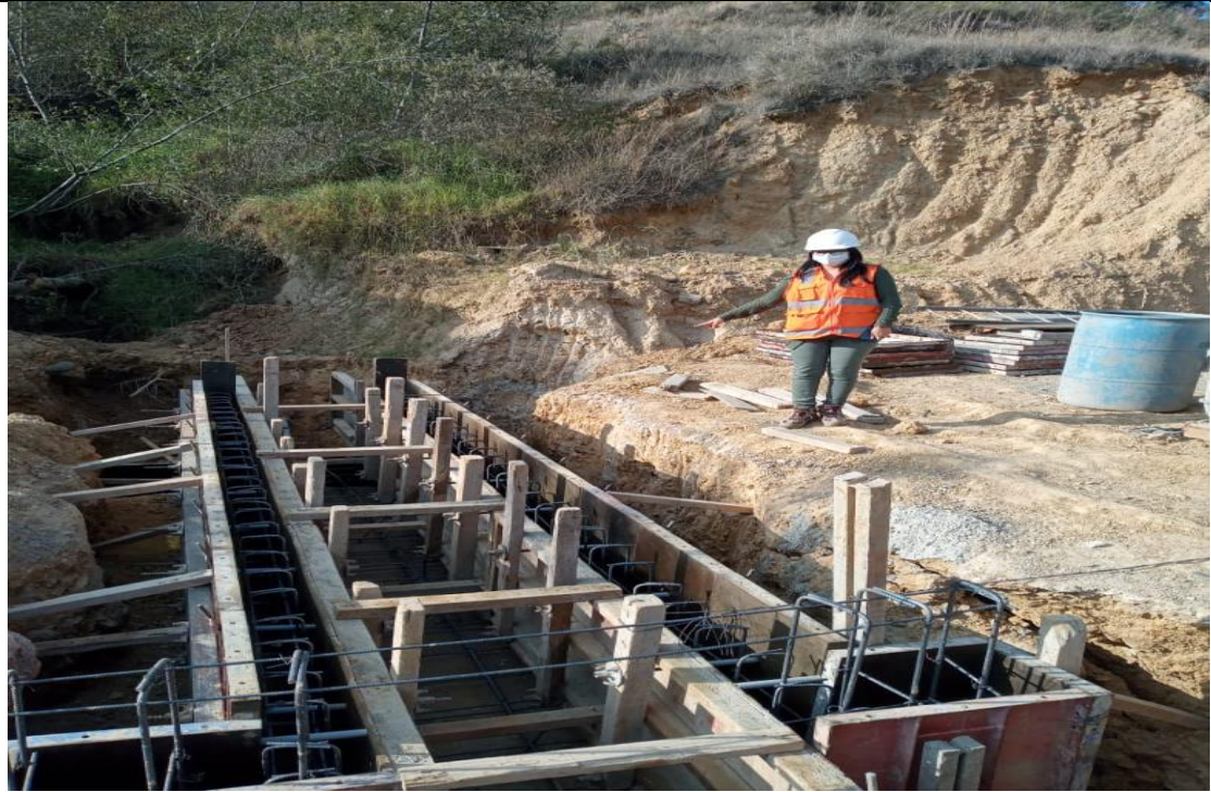
Control de calidad de acero, encofrado y dosificación del concreto
