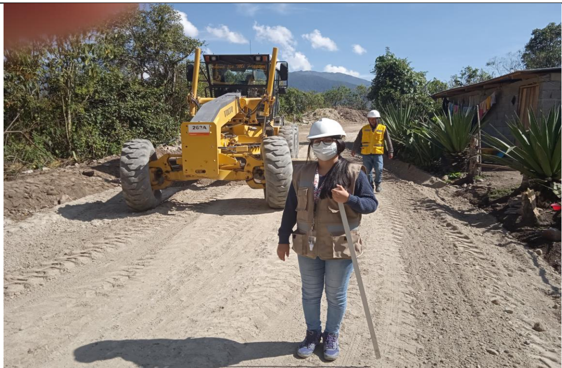
Verificación por supervisión el espesor del pavimento
