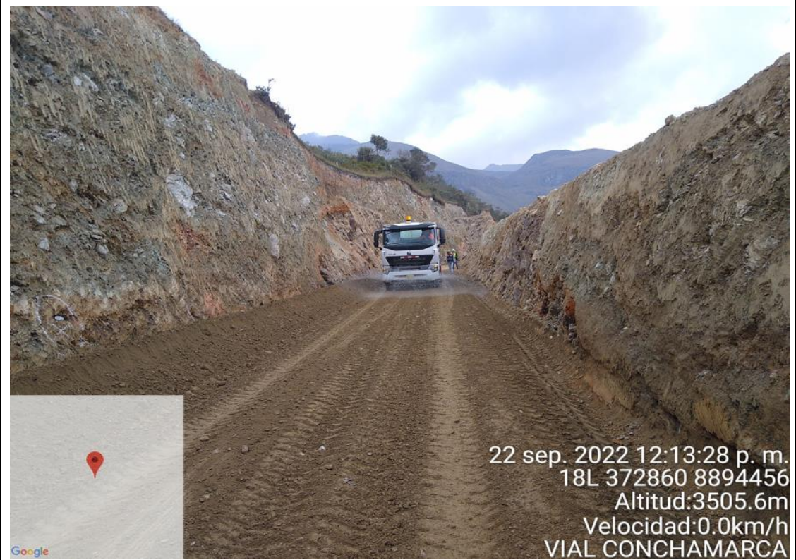
Verificando el vertido del agua + ACEITE SULFONADO al material de cantera para su correcta dosificación
