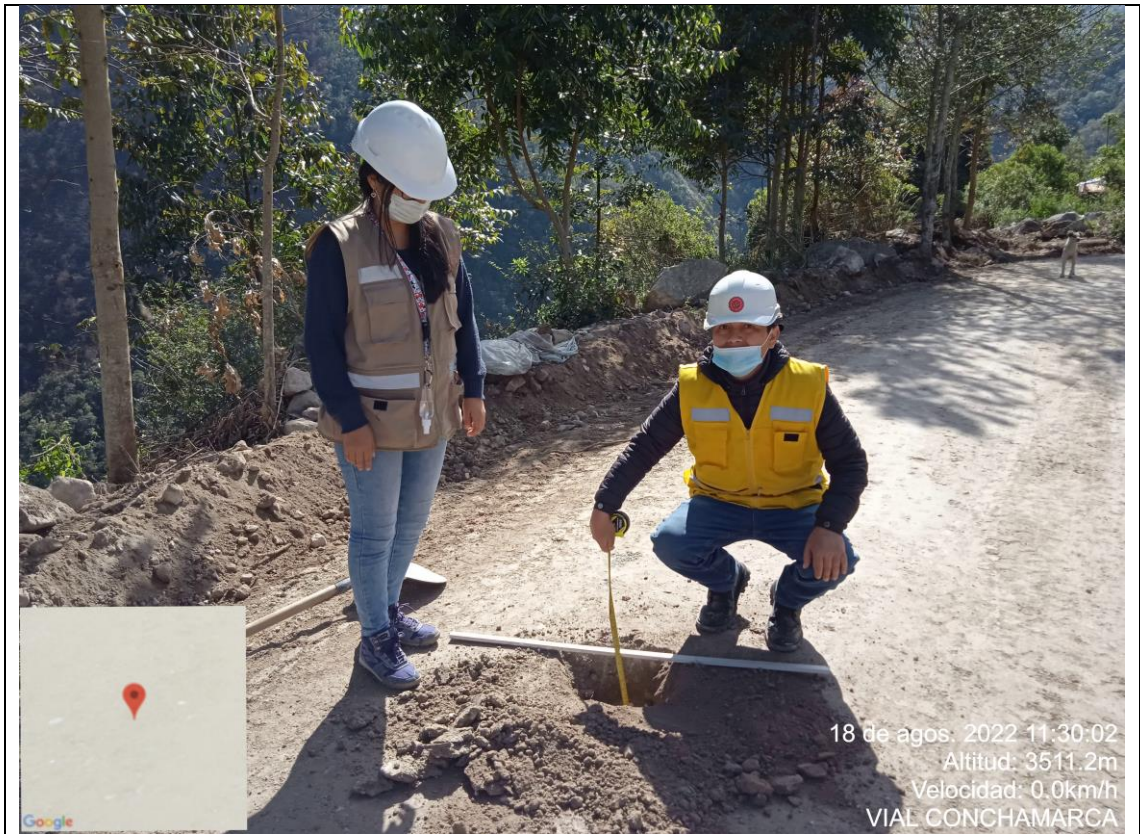
Verificación por supervisión el espesor del pavimento
