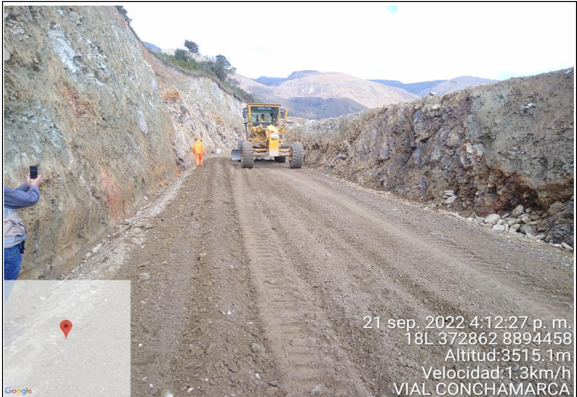
Verificando la mezcla con los insumos vertidos con el material de cantera, para ser conformada y compactada
