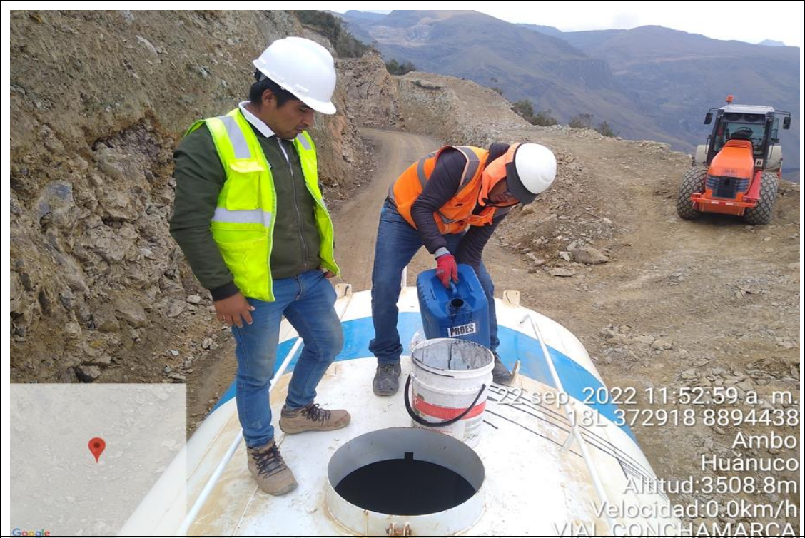
Verificando el vertido del ACEITE SULFONADO BLEU RED con agua, para realizar la dosificación correcta in situ
