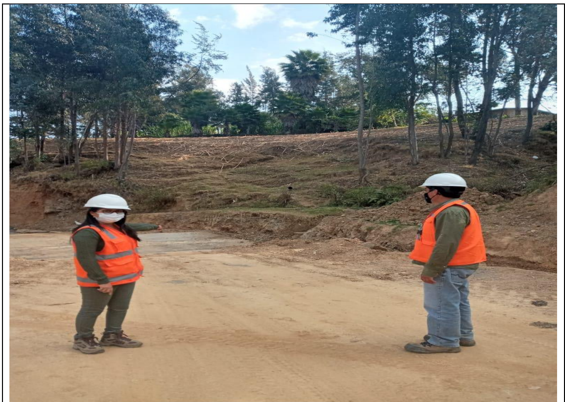
Verificando de la ubicación de las obras de arte. (baden)
