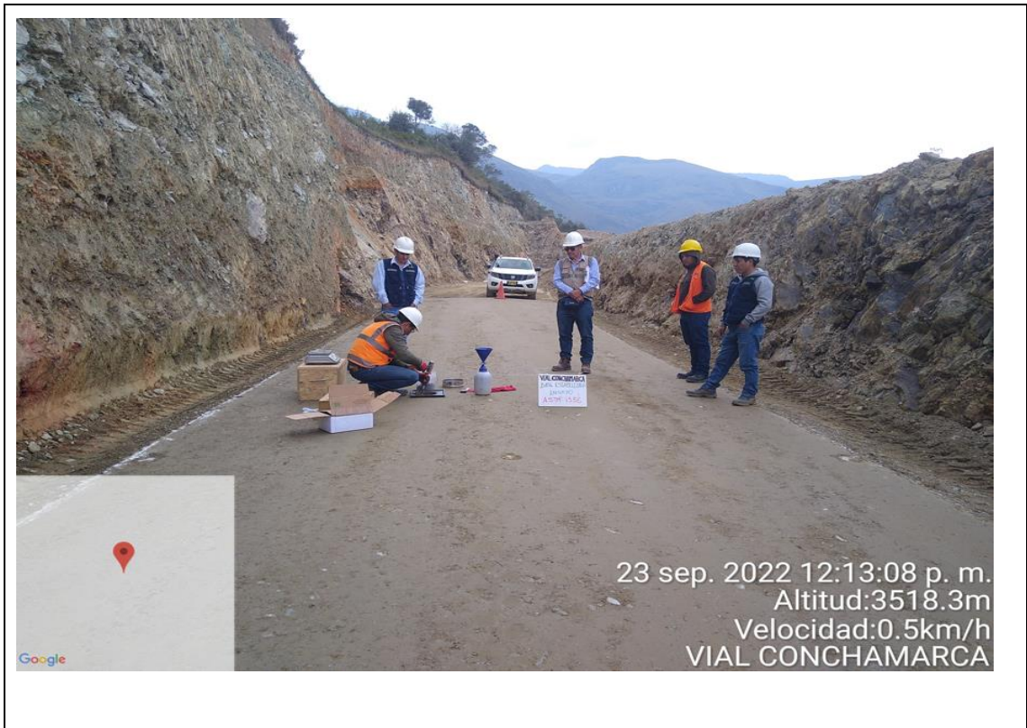
Verificando el control de compactación del tramo de prueba mediante el ensayo del cono de arena, verificado por la supervisión
