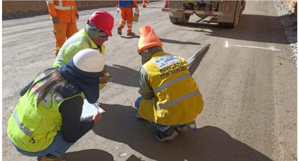
Control de deflexiones al momento de la realización del ensayo deflectométrico.
