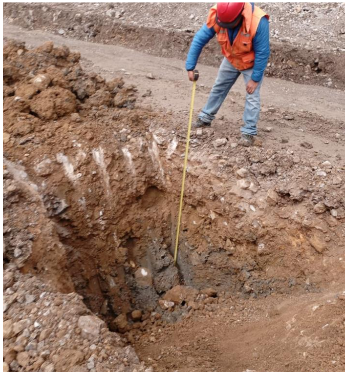
Profundidad de calicata realizada
