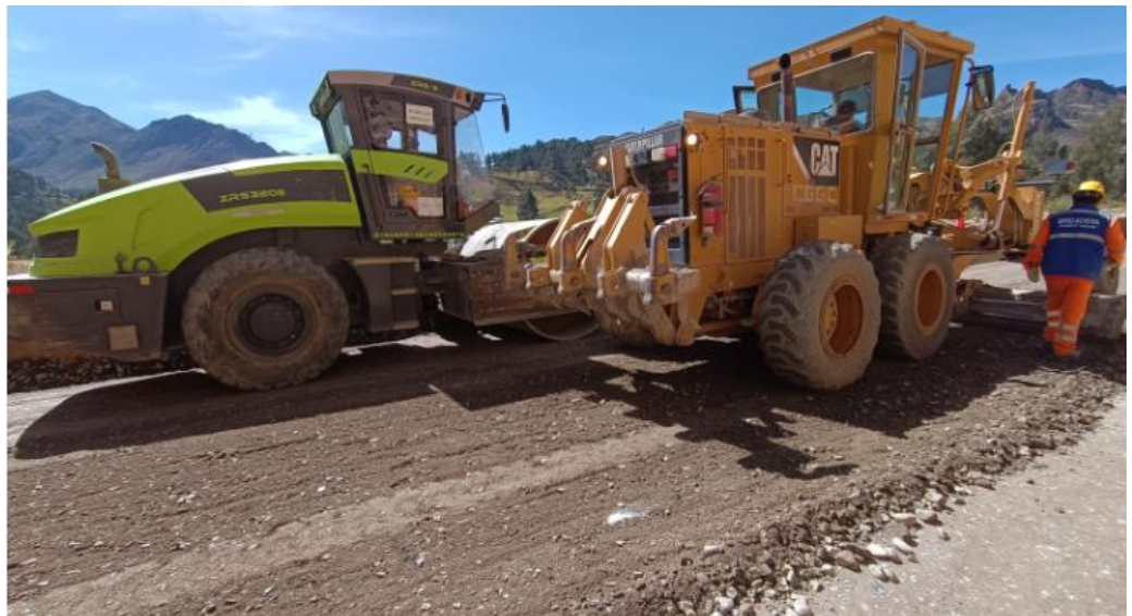
Conformación y compactación de sub base granular al nivel indicado por la topografía.
