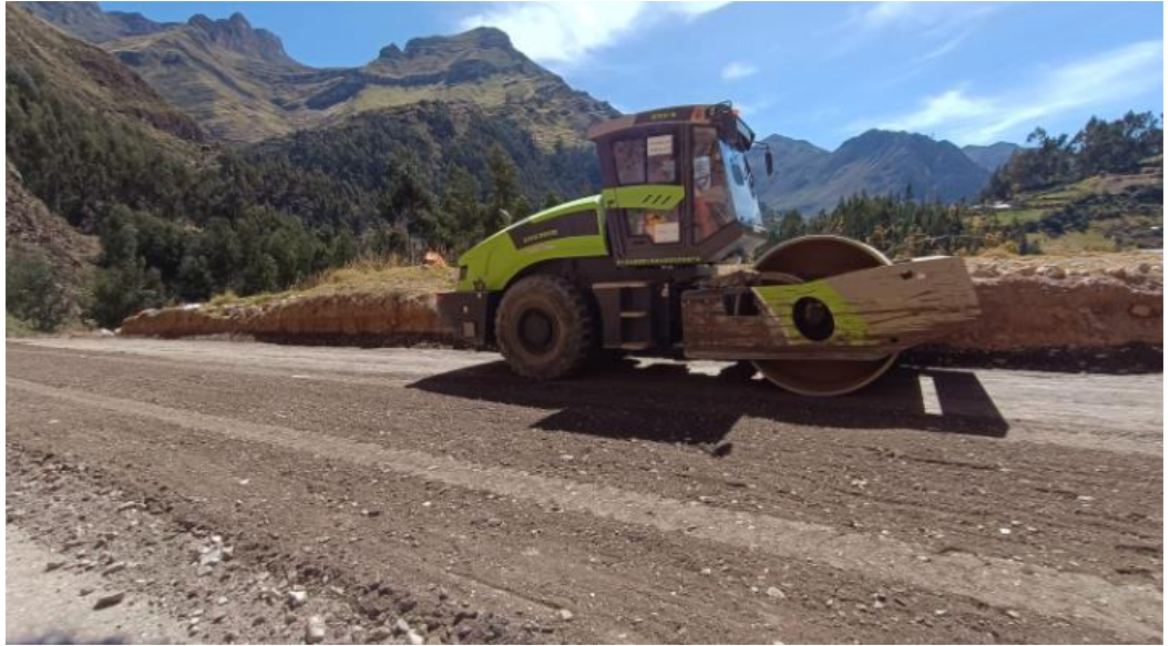
Compactación de la sub base granular con rodillo de 20Tn.
