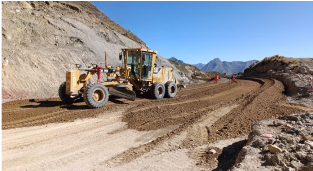
Batido del material de subrasante para su homogenización con la motoniveladora.
