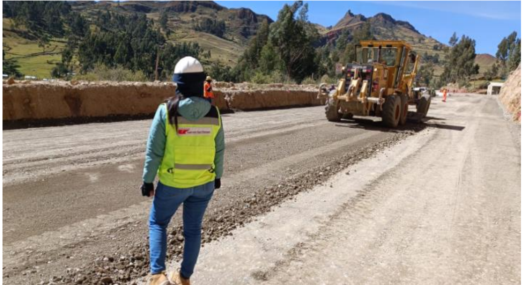
Conformación de la capa de sub base granular con el material aprobado.
