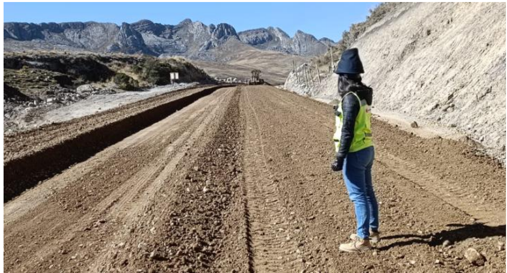
Conformación de la primera capa de subrasante con el material aprobado, cumpliendo con lo requerido por el manual EG - 2013.
