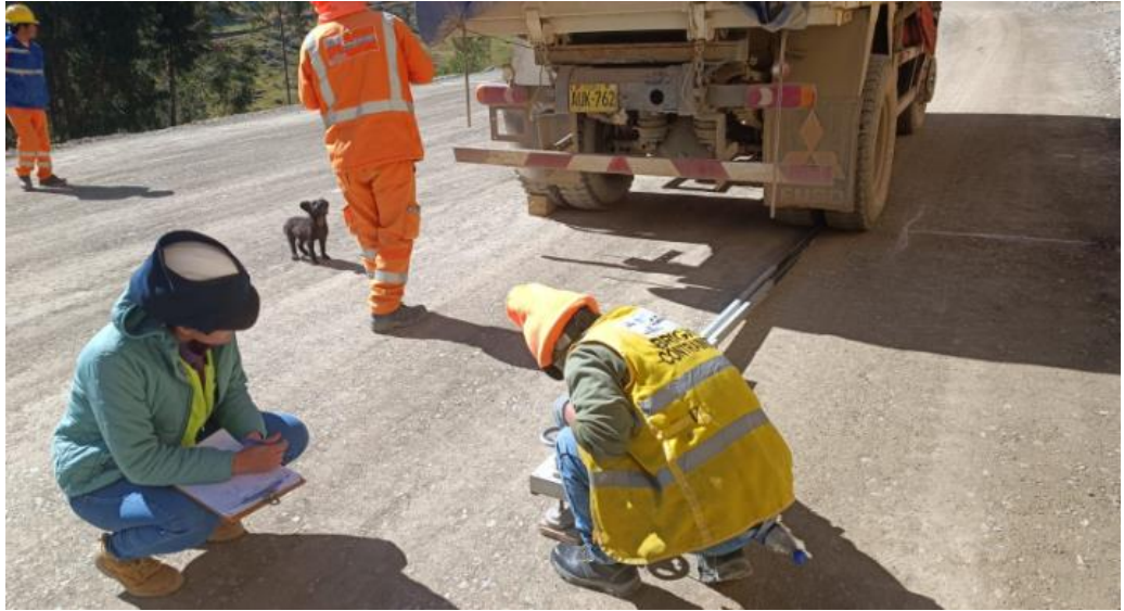
Análisis deflectométrico en la subrasante.
