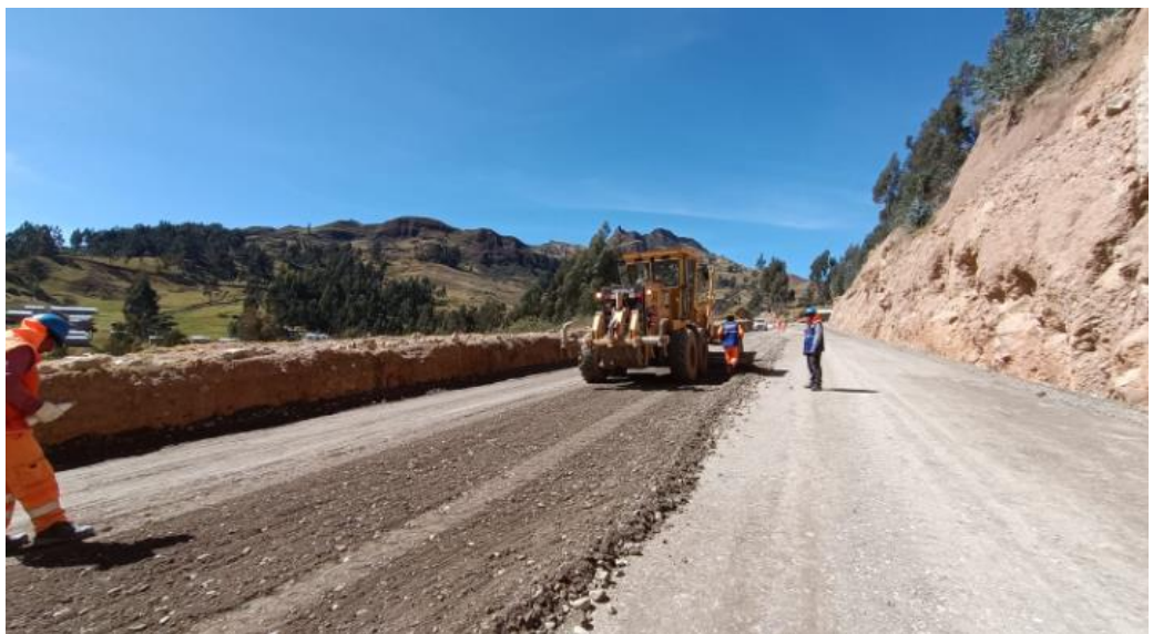
Batido del material de sub base granular para su homogenización con motoniveladora.
