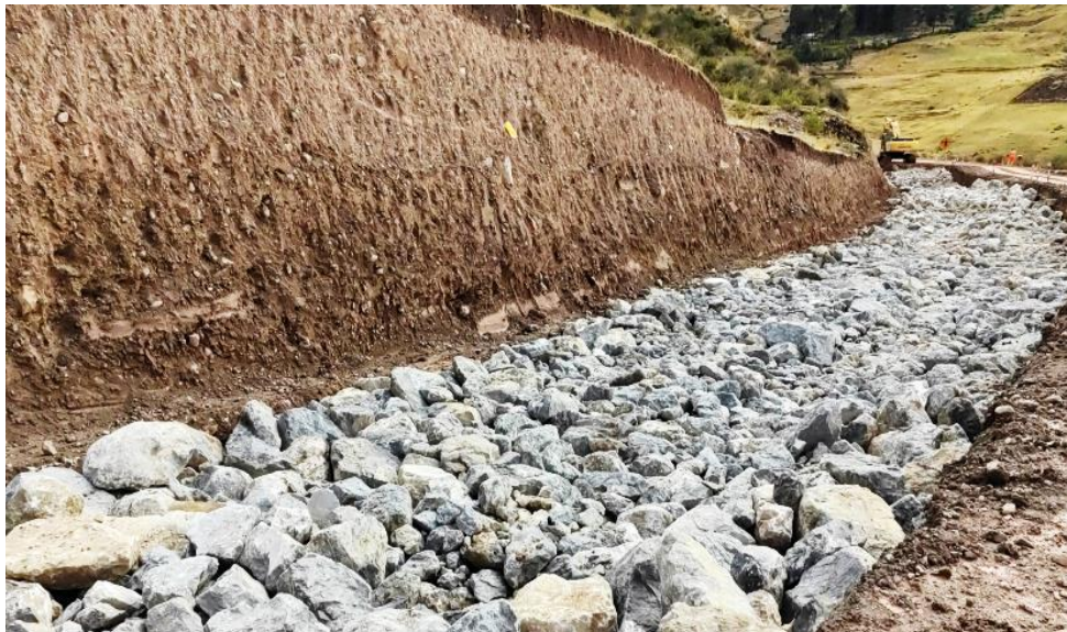
Colocación de enrocado, luego de realizar la excavación para el mejoramiento de suelos, ayudando a la estabilización de las capas superiores.
