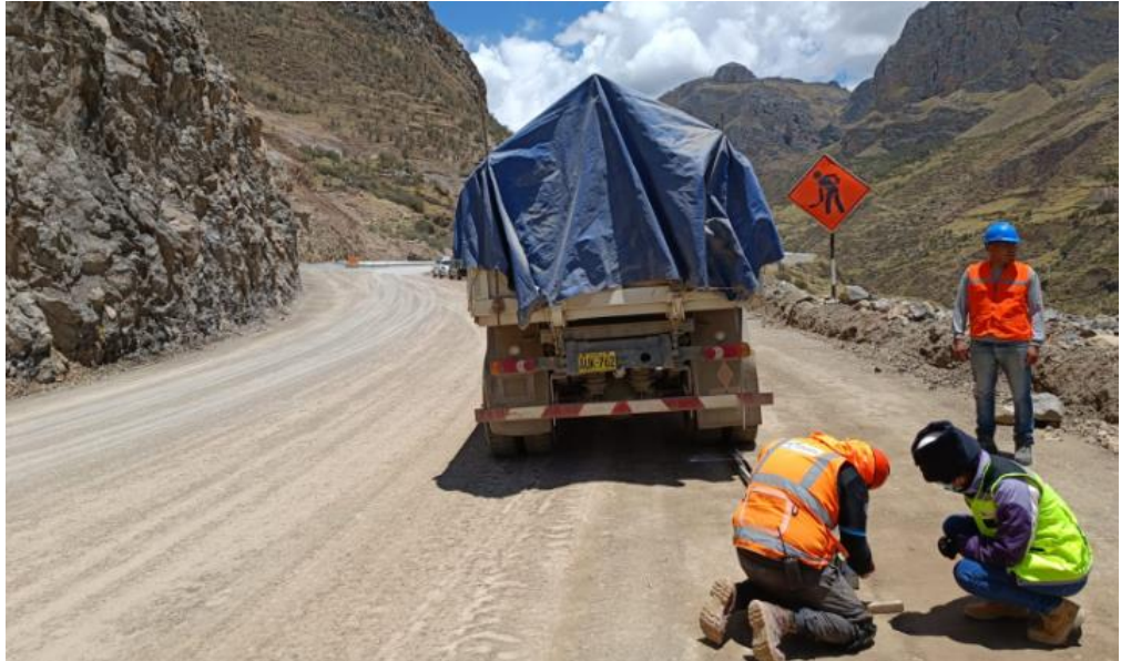
Ensayo Deflectométrico en subrasante mediante el uso de Viga Benkelman.
