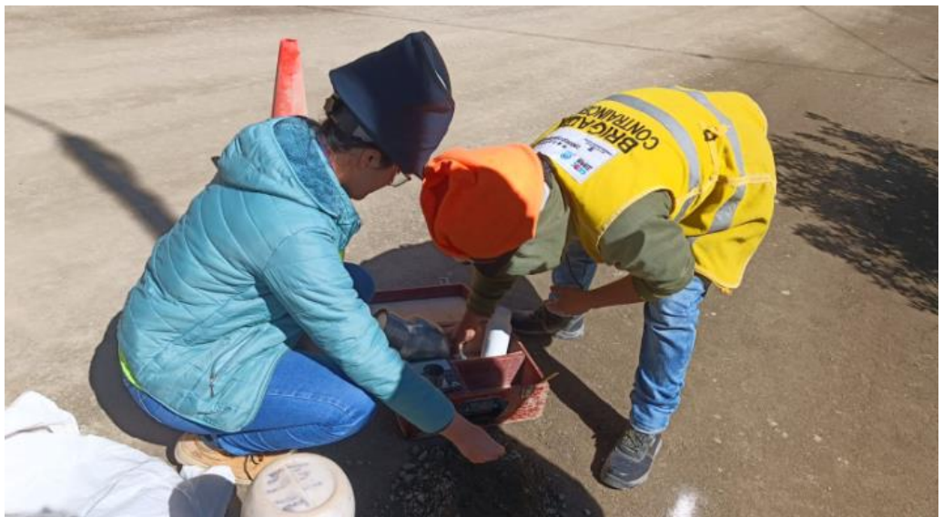
Realización del ensayo Speedy para conocer la humedad de la plataforma.
