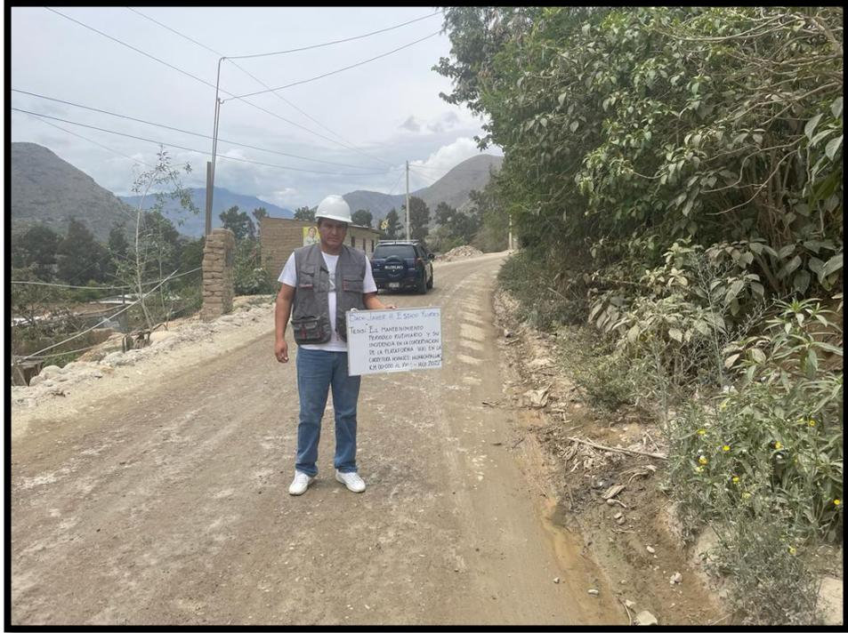
**SE OBSERVA AL TESISTA Y EN LA CARRETERA DEFORMACIONES, HUNDIMIENTO Y BACHES**
