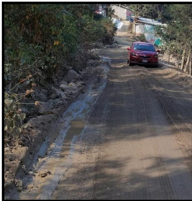
**Deformaciones y hundimientos en el tramo 3 y 4.**
