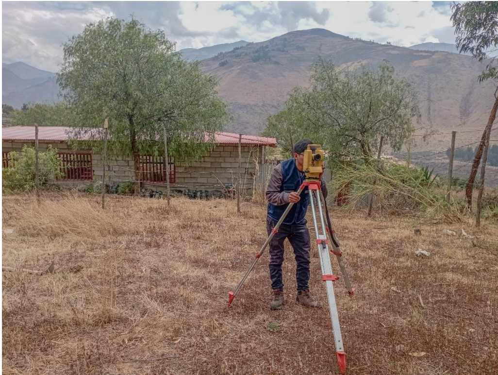
Vista fotográfica del levantamiento topográfico in situ.
