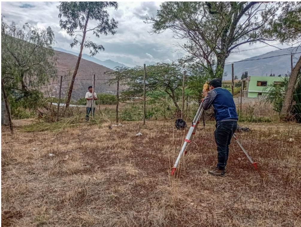
Vista fotográfica del levantamiento topográfico in situ.
