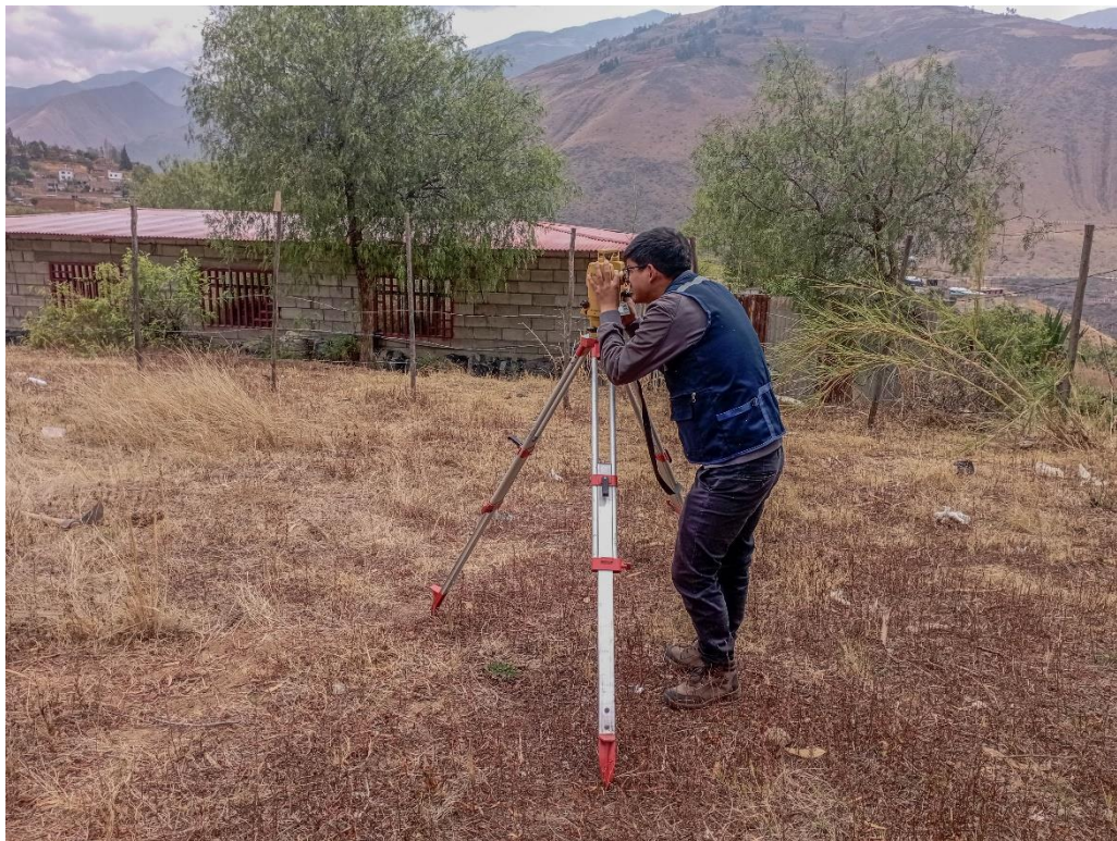
Vista fotográfica del levantamiento topográfico in situ.
