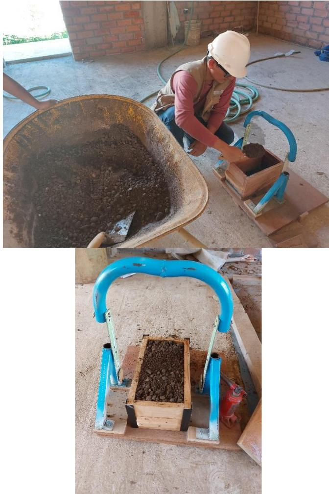
*Nota.* En la imagen se aprecia el proceso de llenado de mezcla al molde de adobe.
