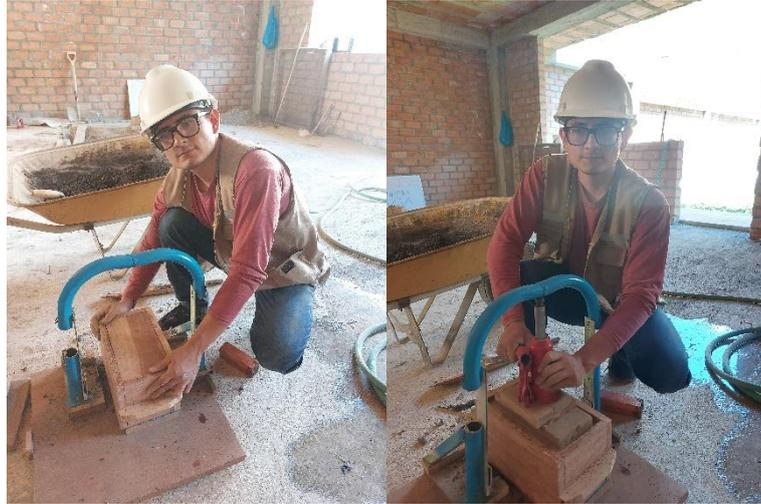
*Nota.* En las imágenes se aprecia el proceso de compactación del adobe, verificando que la compactación sea uniforme en todos sus lados.
