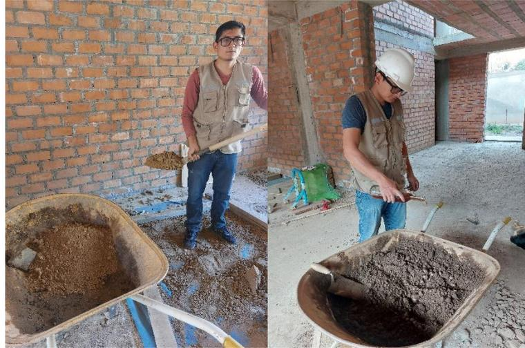
*Nota.* En las imágenes se observa el proceso de dosificación de la tierra y la mezcla de tierra con la resina de plátano.
