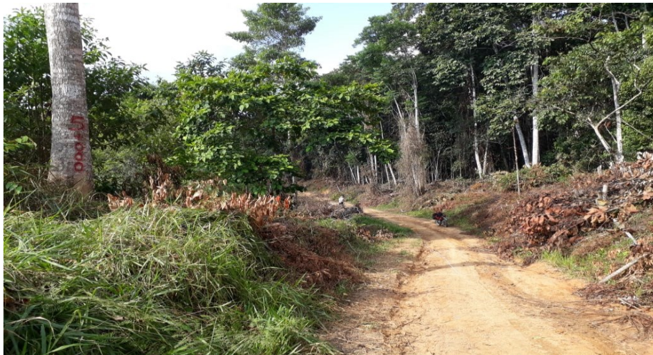
Figura 8 Vistas del Camino en estudio, KM. 5+000
