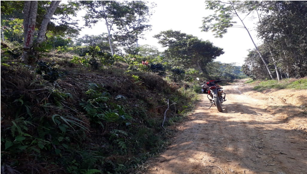
Figura 7 Vistas del Camino en estudio, KM. 4+000
