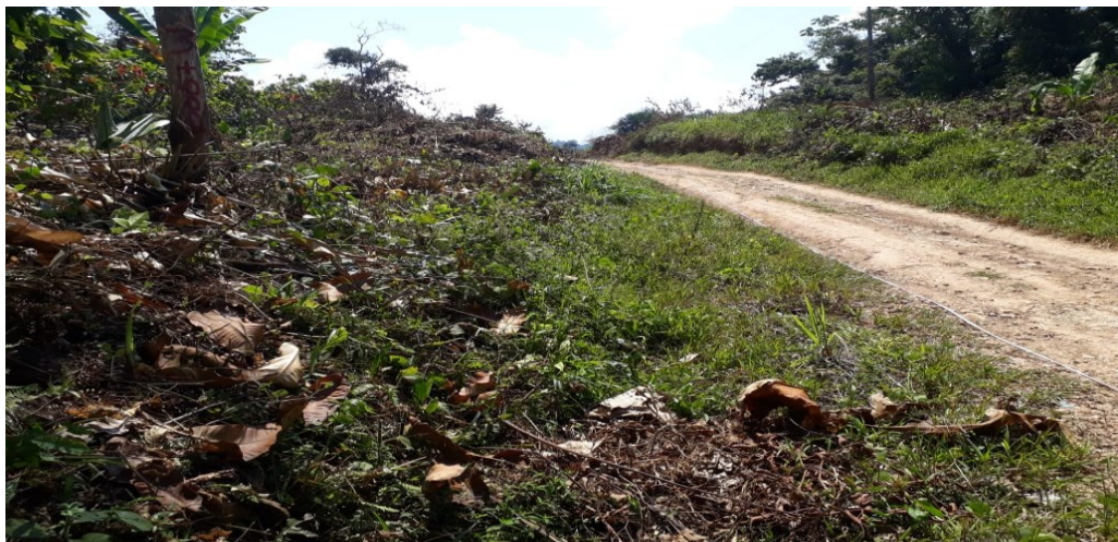
Figura 6 Vistas del Camino en estudio, KM. 3+000
