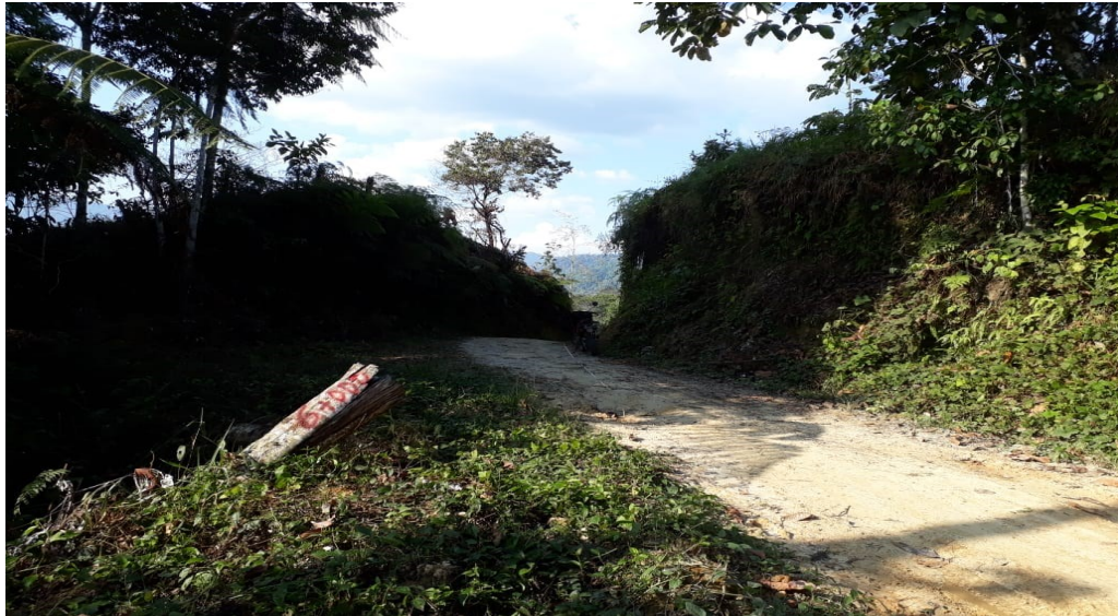
Figura 9 Vistas del Camino en estudio, KM. 6+000
