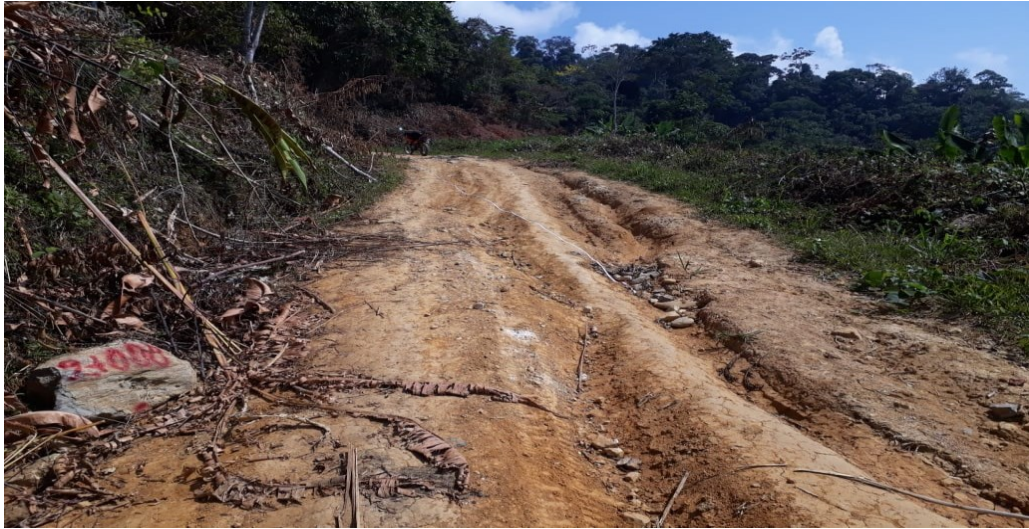
Figura 5 Vistas del Camino en estudio, KM. 2+000
