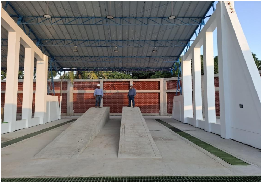
Área de lavados – Hangar
