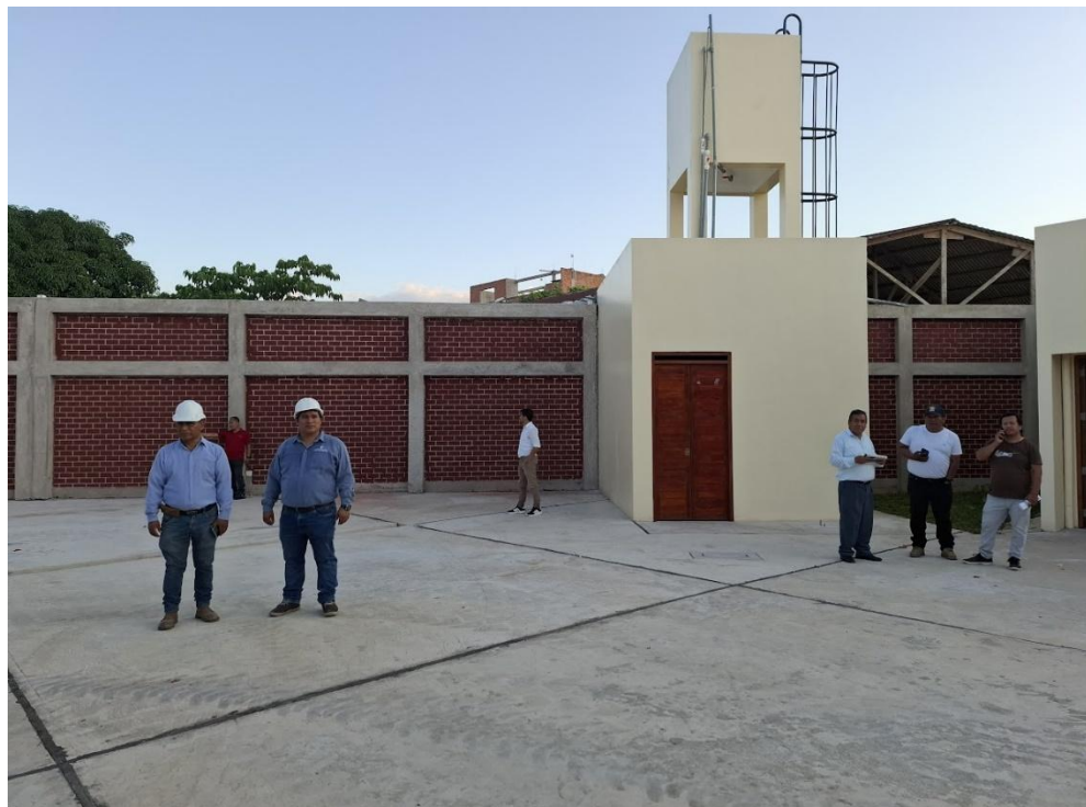
Tanque elevado y cuarto de bombas – Hangar
