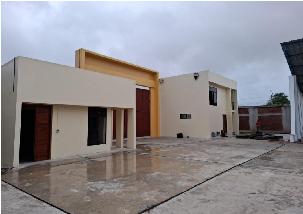
Módulo 01 y módulo 02 – Hangar
