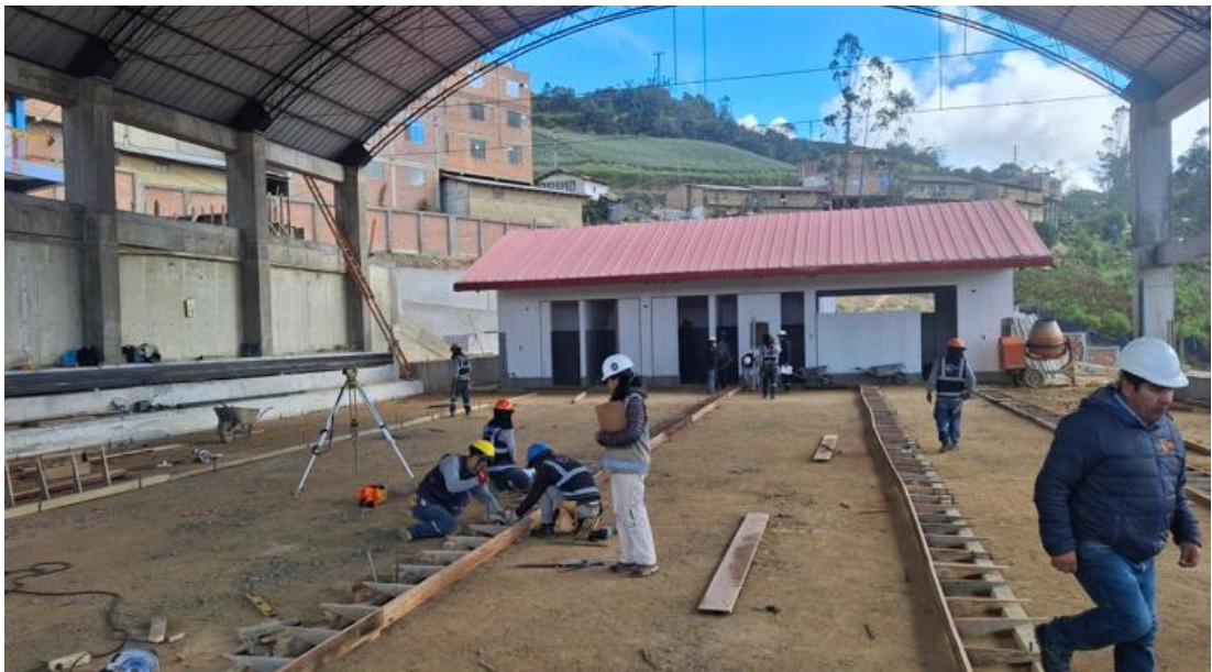
Supervisión y control del rendimiento del personal durante la ejecución de encofrados y habilitación de acero, asegurando el cumplimiento de los estándares de calidad y seguridad
