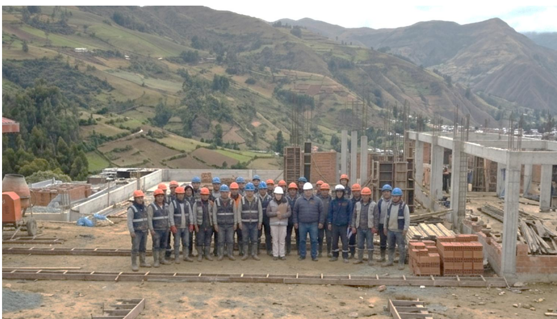
Registro fotográfico del personal evaluado en las actividades constructivas del proyecto de infraestructura educativa
