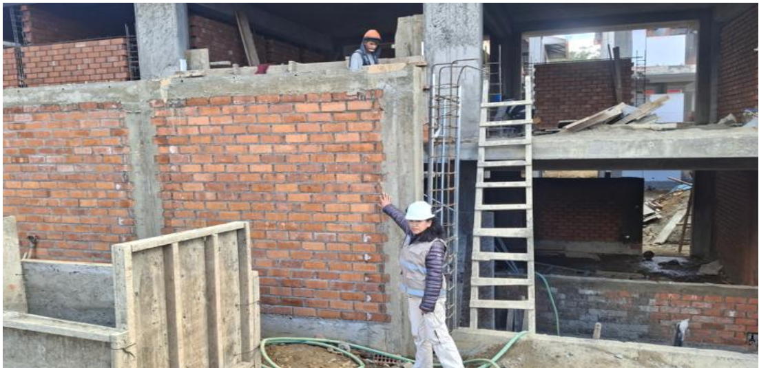
Verificación del avance físico en muros tras la aplicación de la metodología, logrando un incremento significativo en el porcentaje de trabajo productivo frente al método tradicional
