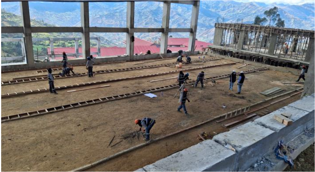
Toma de datos final (Postest) en la partida de Aislamiento y acabados interiores (asentado de ladrillos), evidenciando una mayor eficiencia y proactividad de los peones intervenidos
