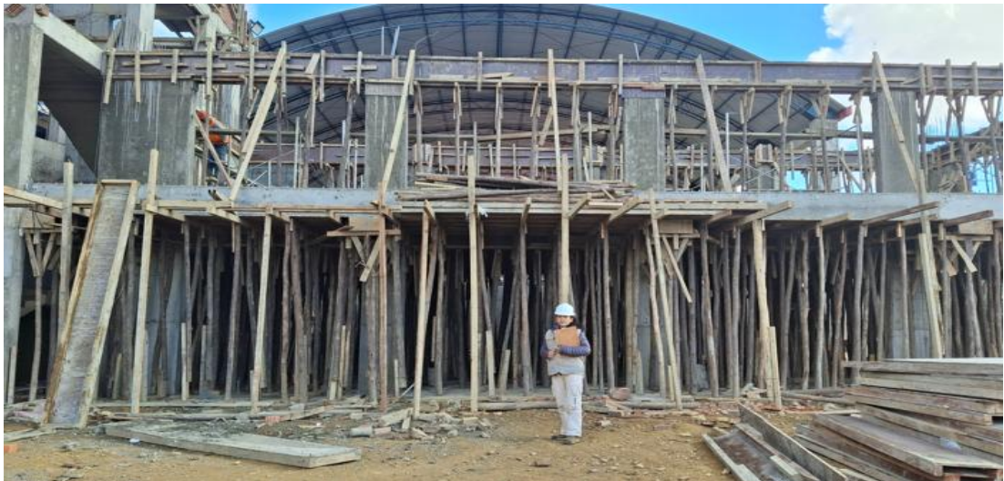
Sesión de planificación colaborativa con la mano de obra no calificada para optimizar las tareas de movimiento de tierras y la correcta habilitación de materiales en el área de trabajo
