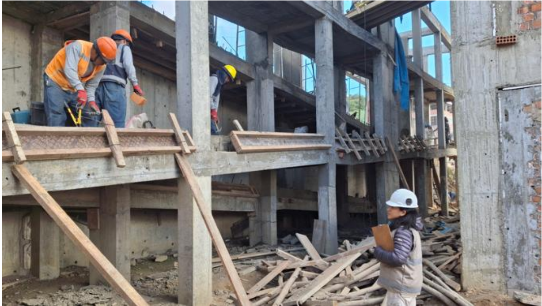
Implementación de la conducta Lean Construction en el grupo experimental, orientada a la eliminación de tiempos muertos en actividades operativas de cimentación y falso piso
