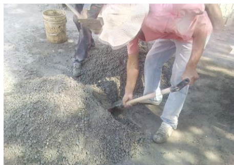
Figura 22. Mezclado en seco de agregados
