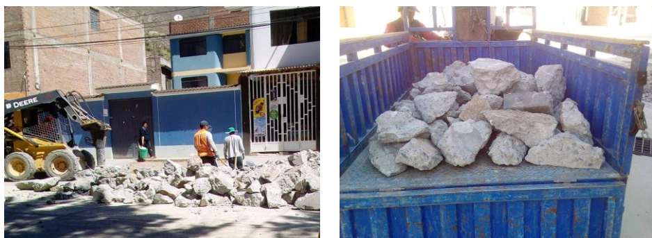
Figura 8. Acopio del pavimento rígido reciclado demolido
