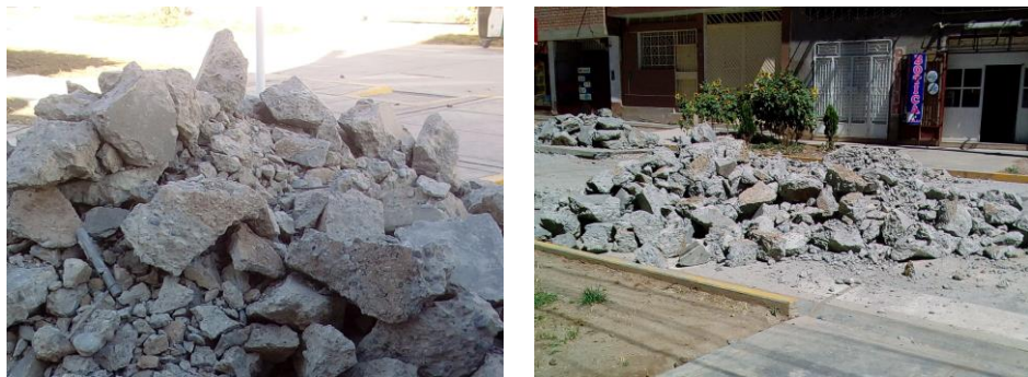
Figura 6. Pavimento rígido demolido
