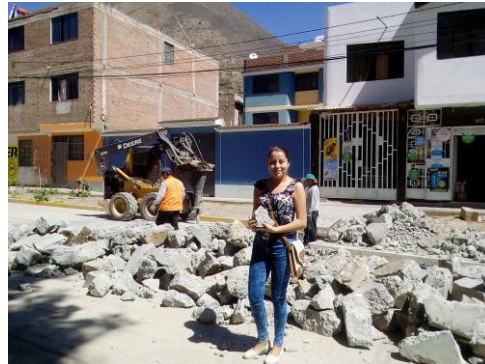
Figura 7. Proceso de reciclaje del pavimento rígido demolido
