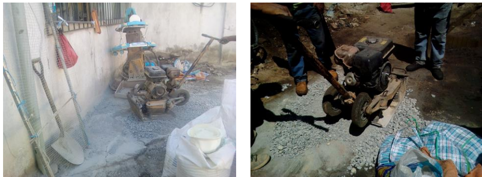
Figura 11. Proceso de trituración secundario con plancha compactadora
