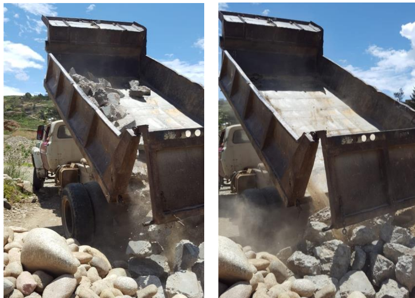
Figura 9. Descarga del pavimento rígido demolido reciclado en la planta chancadora “San Andrés”
