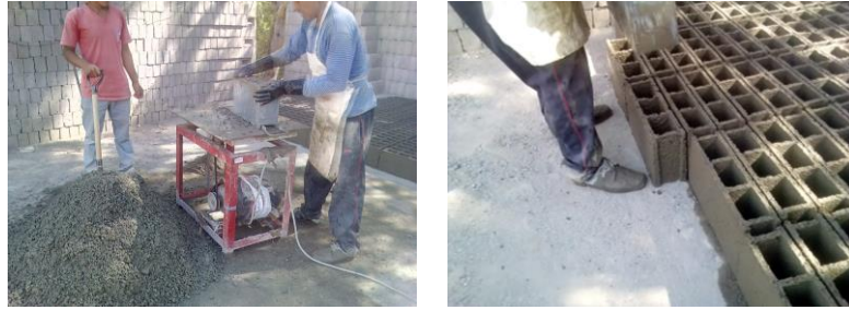
Figura 21. Elaboración de bloques de concreto para muros no portantes con agregados de pavimento rígido triturado
