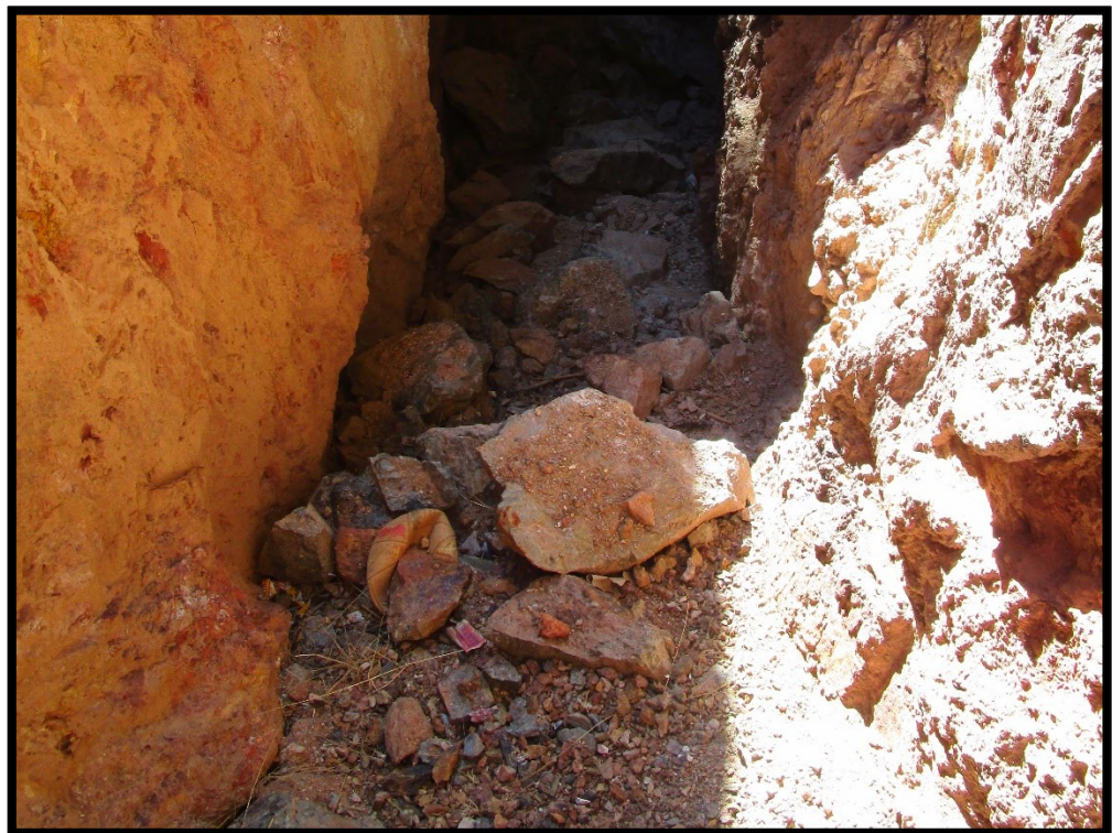
Anexo 13. Derrumbes al interior de la bocamina
