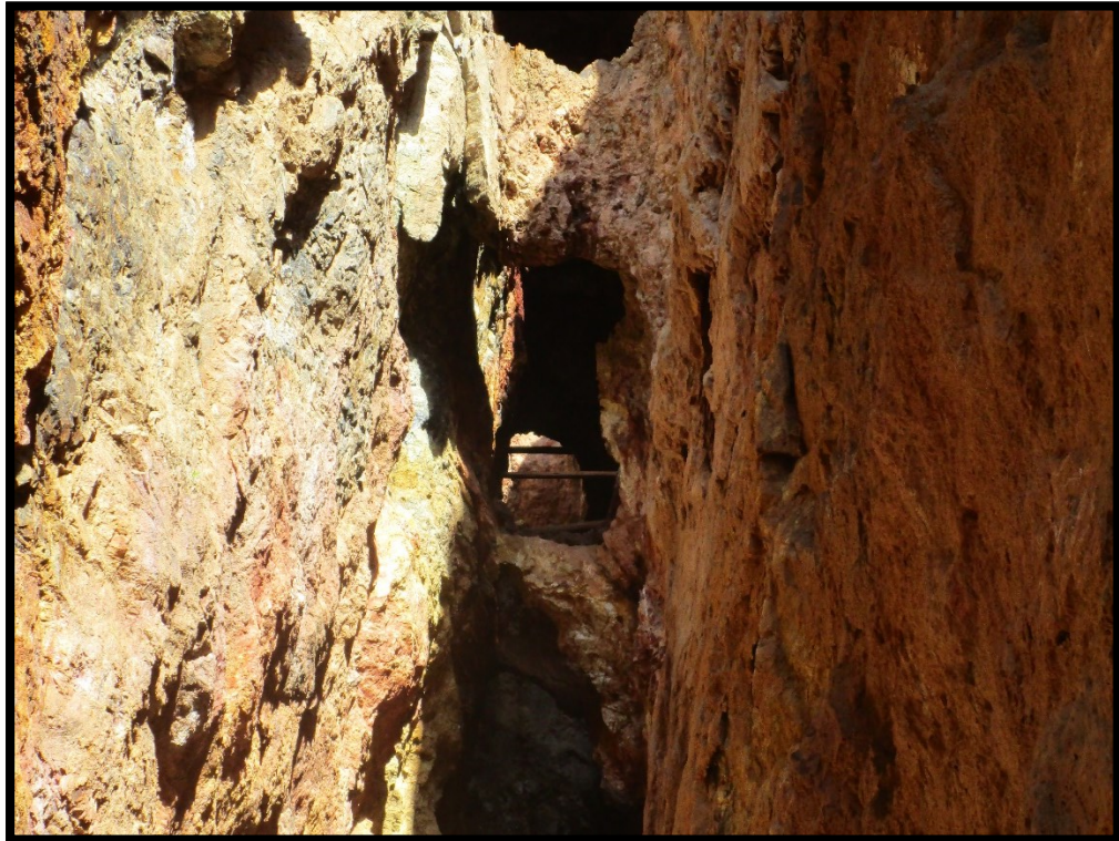
Anexo 12. Estructuras de madera para soporte de la bocamina
