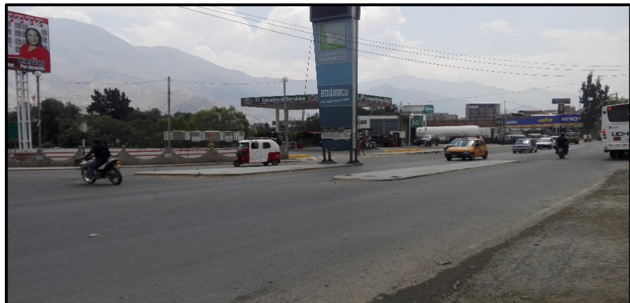
Figura 2. Vía Nacional PE-18A - Vía Arterial
