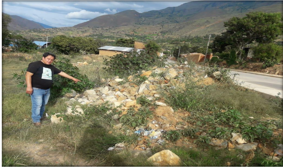
Fotografía 7 Residuos de construcción y demolición de la obra de construcción de las pistas y veredas, en el Jr. Javier Heraud cuadra 8 en la zona urbana del distrito de Santa María del Valle.
