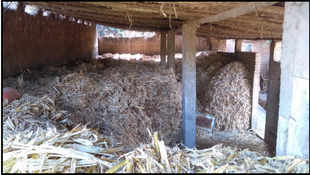
Cuarto de almacenamiento de bagazo de caña de azúcar
