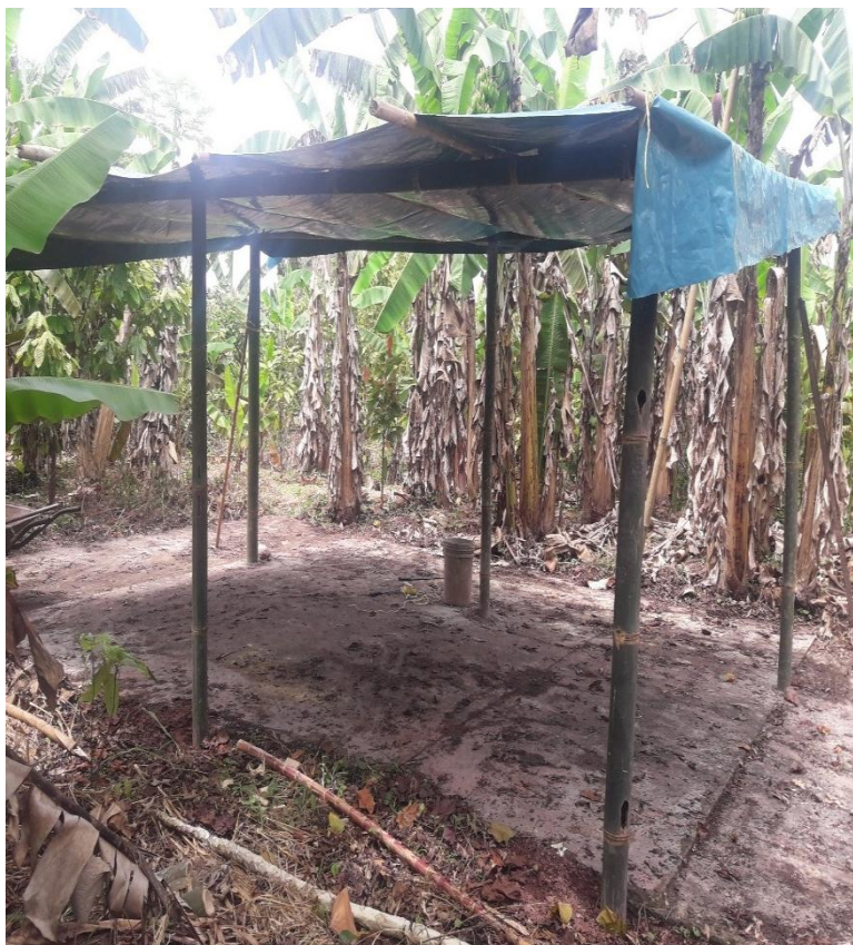
FOTOGRAFÍA 14: Planta de Tratamiento de Compost de Hojas de cacao de la Localidad de Puerto Nuevo
