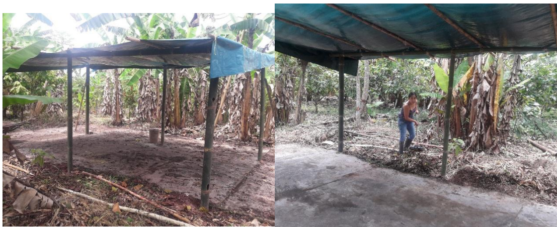
Planta de compostaje – Puerto Nuevo
