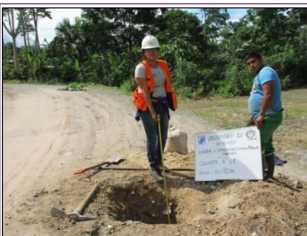
FOTOGRAFÍA N° 2: Se observa la calicata N° 01 de la carretera Bella-Inti.
