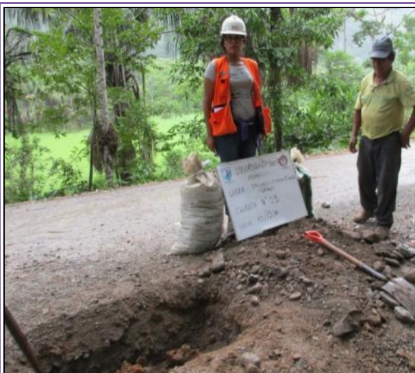
FOTOGRAFÍA N° 10: Se observar la calicata N° 03 de la carretera Bella-Inti.
