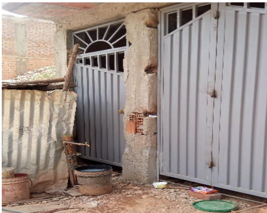
FOTOGRAFIA N° 18: Se puede apreciar columna rellena con ladrillos y mala conexión entre columna y viga. También se observó el picado de la columna en seis zonas.
