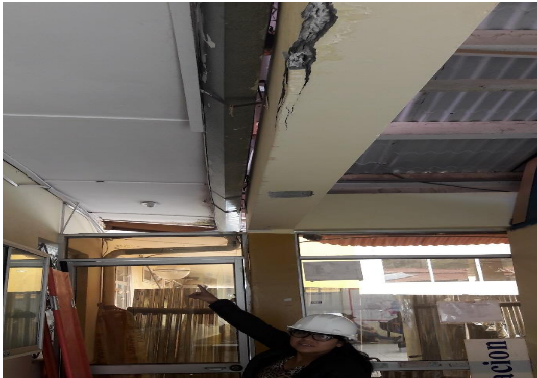
FOTO 08: En la toma se puede apreciar la presencia de humedad en el cielorraso y la viga principal presenta fisuras.
