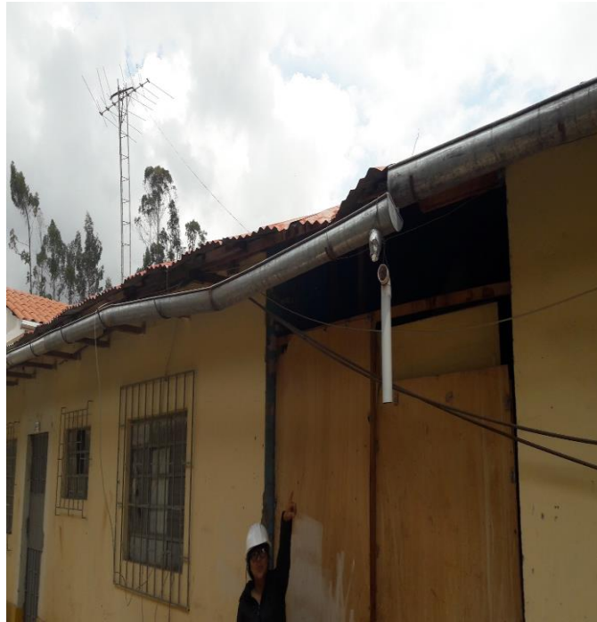
FOTO 04: En la foto se observa que La recolección y la evacuación de aguas pluviales es por medio de canaletas y descargadas al piso.
