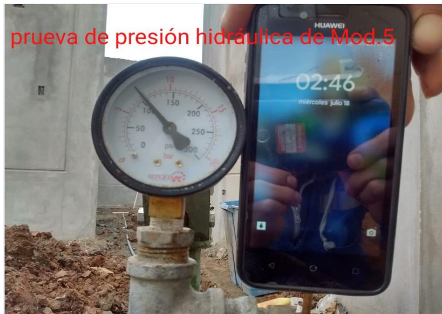
FOTO 10: Se realizo la prueba de la presión Hidráulica de Mod.5.
