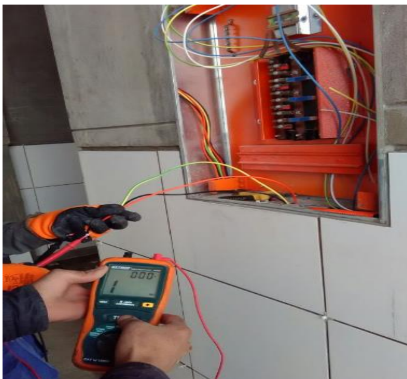
FOTO 17: Se realiza el megado de los cables Instalados en el modulo V.
