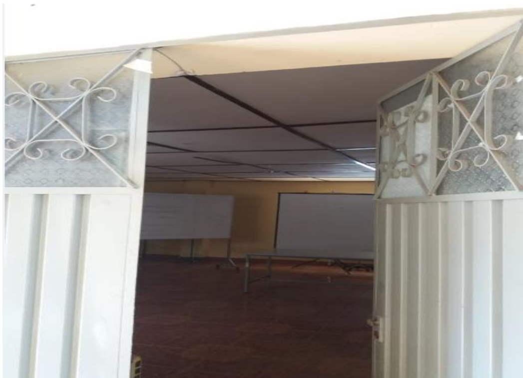
FOTO 24: en la toma se observa l Puerta interior metálica
