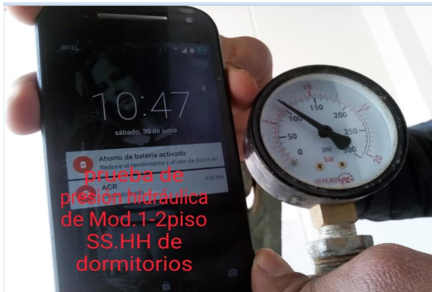
FOTO 08: Se realizó la prueba de la presión Hidráulica de Mod.1-2 del segundo piso (SS.HH Y Dormitorio)
