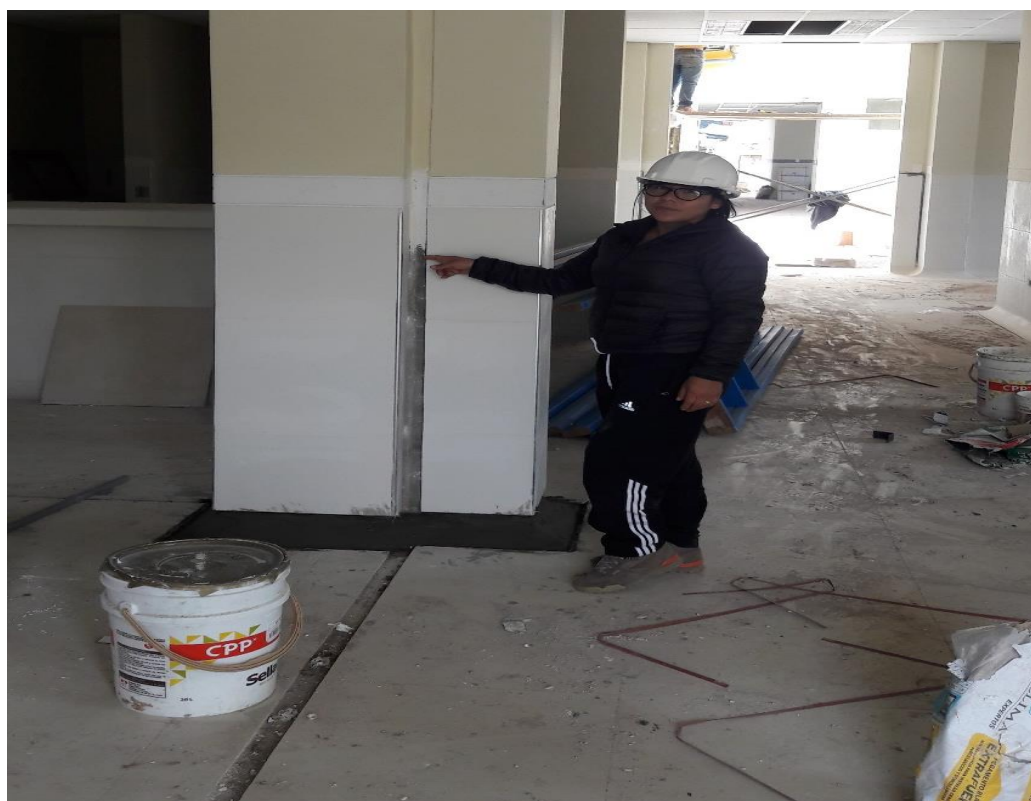
FOTO 01: En la fotografía se puede observar las juntas sísmicas.
