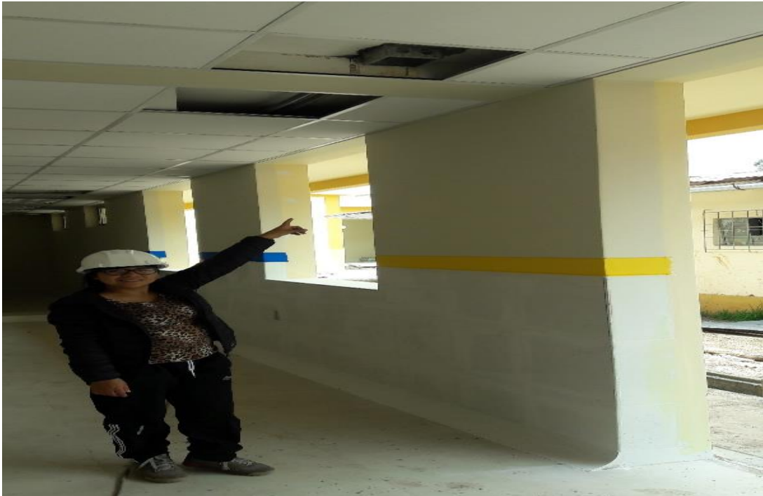
FOTO01: En la toma se puede observar el cielo raso suspendido.
