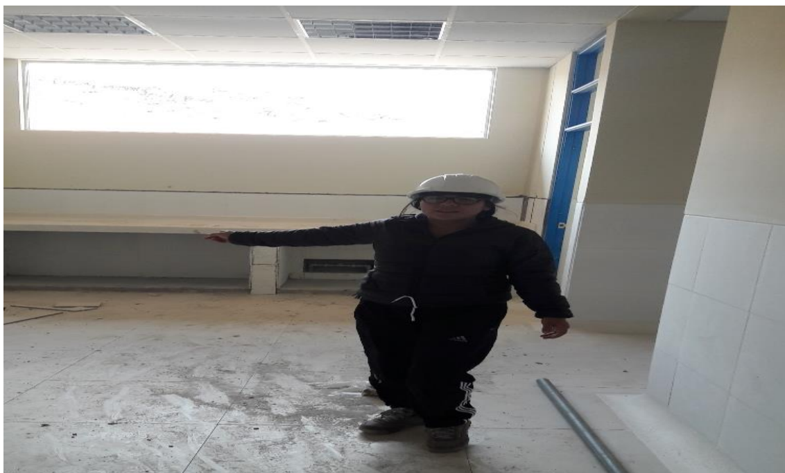
FOTO 07: Se aprecia ventanas en uno de los ambientes del modulo IV.
