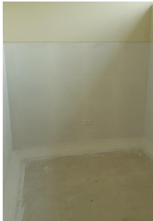
FOTO 04: En la foto se aprecia los muros terminados con cerámica de color blanco, también se visualiza contrazocalo sanitario de terrazo pulido hecho en obra.
