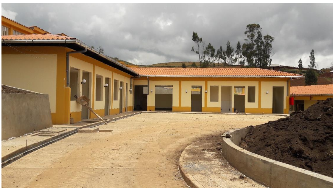
FOTO 05: En la toma se aprecia el piso de cemento pulido bruñado en veredas, también se observa la cobertura de teja andina.
