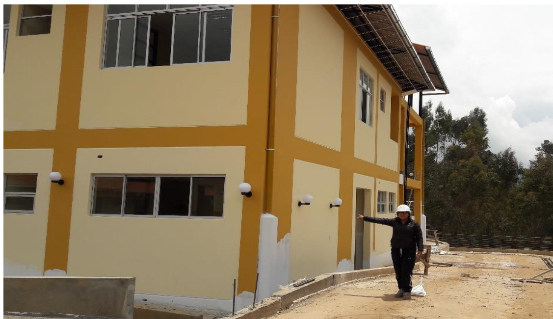
FOTO 06: En la foto se observa Todas las ventanas diseñadas para el hospital corresponden a un prototipo típico, siendo distintas por el tamaño. son perfiles de aluminio considerados la función, las hojas serán batientes con eje de giro horizontal y bisagras como parte del marco.
