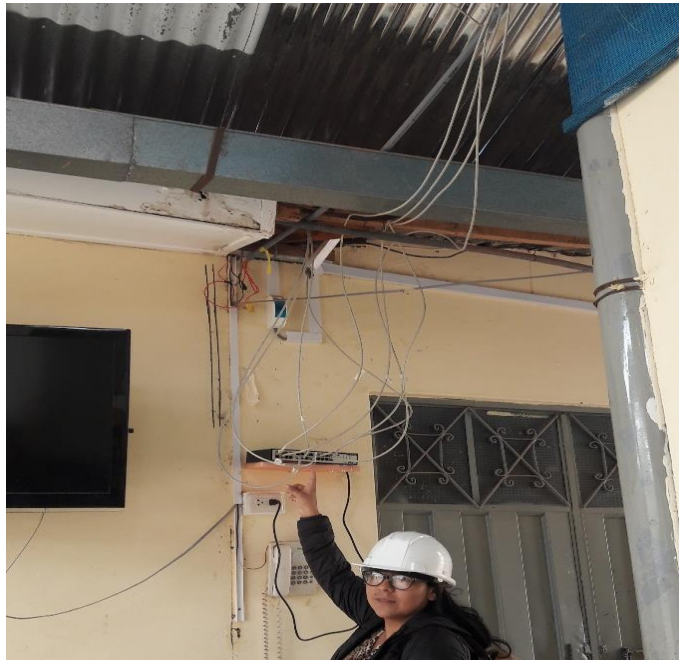
FOTO 09: En la foto se aprecia la inadecuada instalación eléctrica en el módulo de contingencia.
