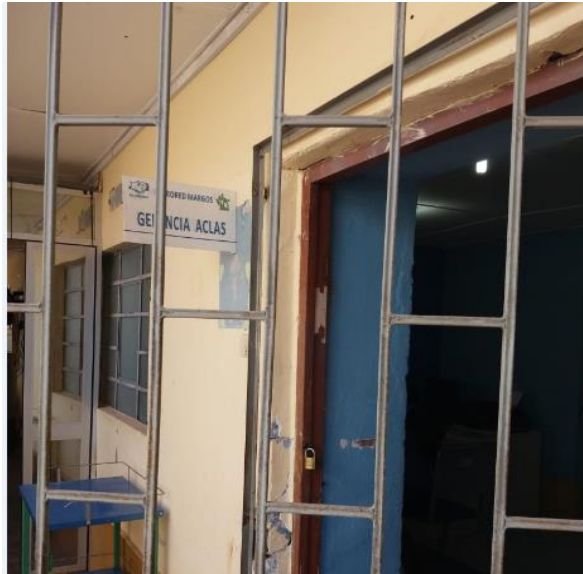
Muro de adobe
