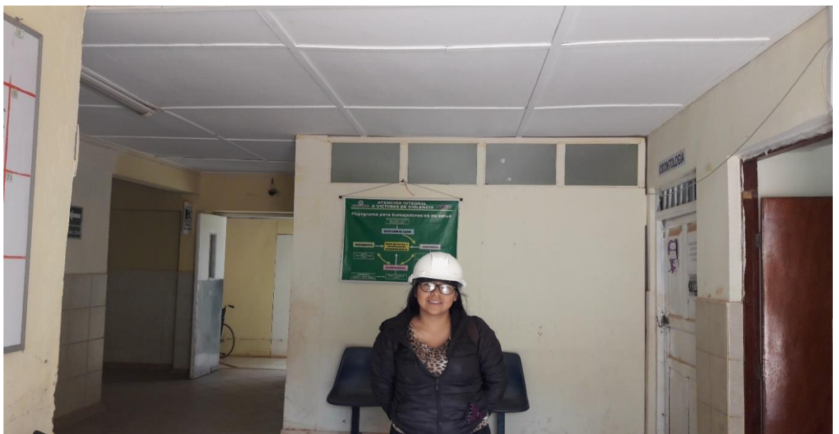
FOTO 10: En la foto se aprecia muros de adobe y cielo raso de triplay.
