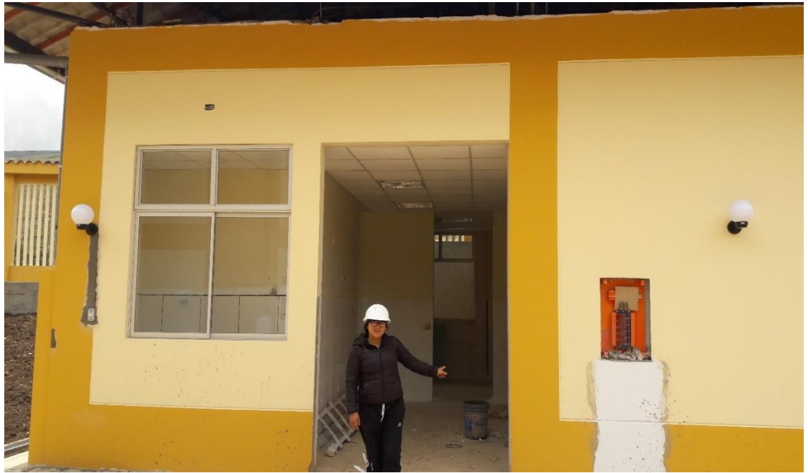
FOTO 05: En la toma se aprecia el tablero eléctrico metálicos de dimensiones apropiadas para instalar los interruptores automáticos y/o termomagnéticos requeridos.
