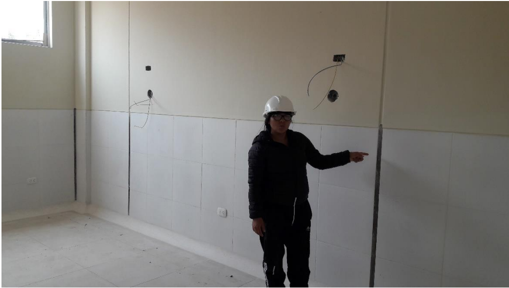
FOTO 01: En la fotografía se puede observar las juntas sísmicas.
