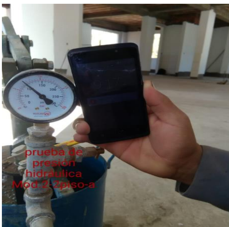
FOTO 09: Se realizó la prueba de la presión Hidráulica de Mod.2 del segundo piso.
