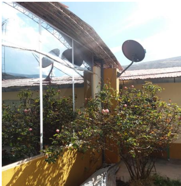
Vista de cobertura del modulo y patio central
