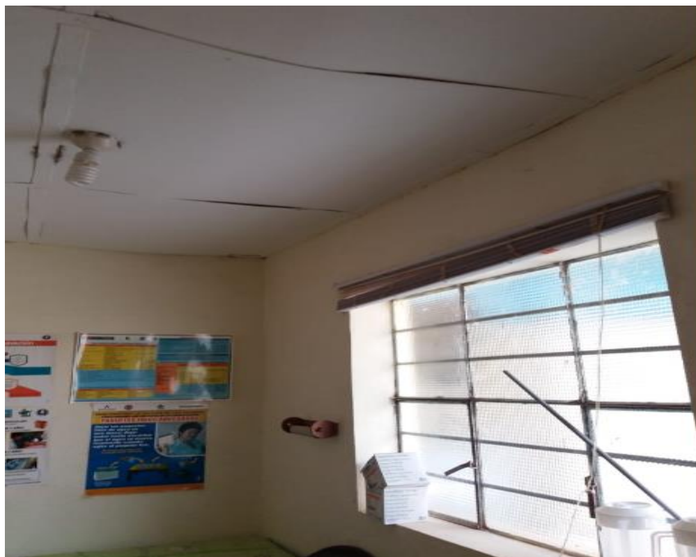
FOTO 22: Ventana con marco de metales interiores
