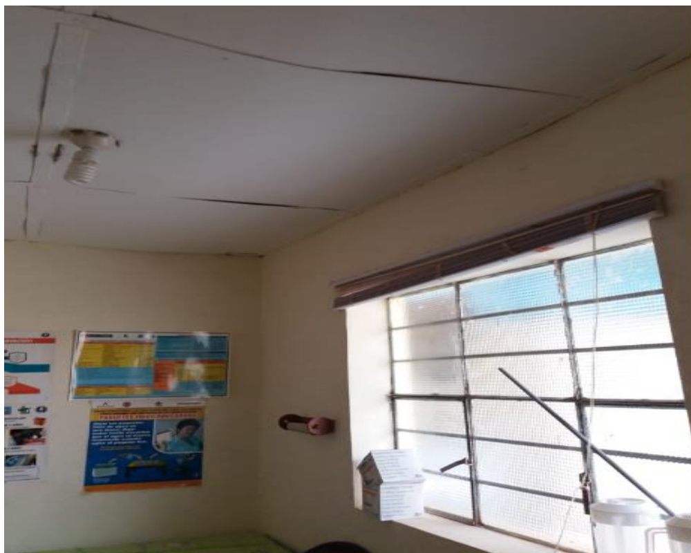
FOTO 22: Ventana con marco de metales interiores
