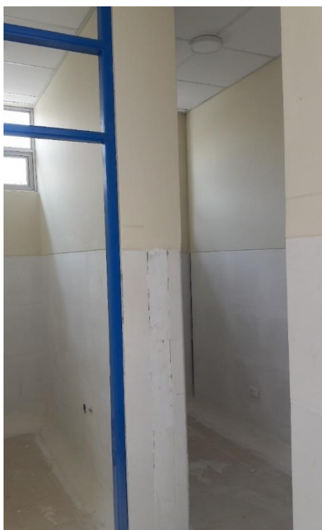
FOTO 04: En la foto se aprecia los muros terminados con cerámica de color blanco, también se visualiza contrazocalo sanitario de terrazo pulido hecho en obra.
