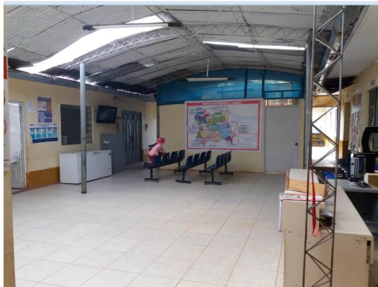
Cobertura de sala de espera con vigas metálicas tipo arco
