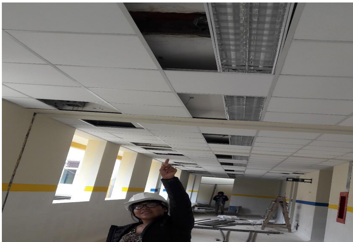
FOTO 02: En la toma se aprecia la instalación de las luminaires interiores empotrados en el falso cielo raso de 60x20x10 cm.
