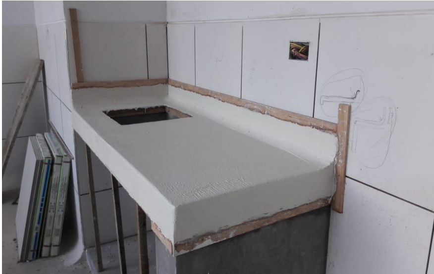
FOTO 02: En la toma se aprecia el tarrajeo del lavadero de concreto con materia marmolina y granito.
