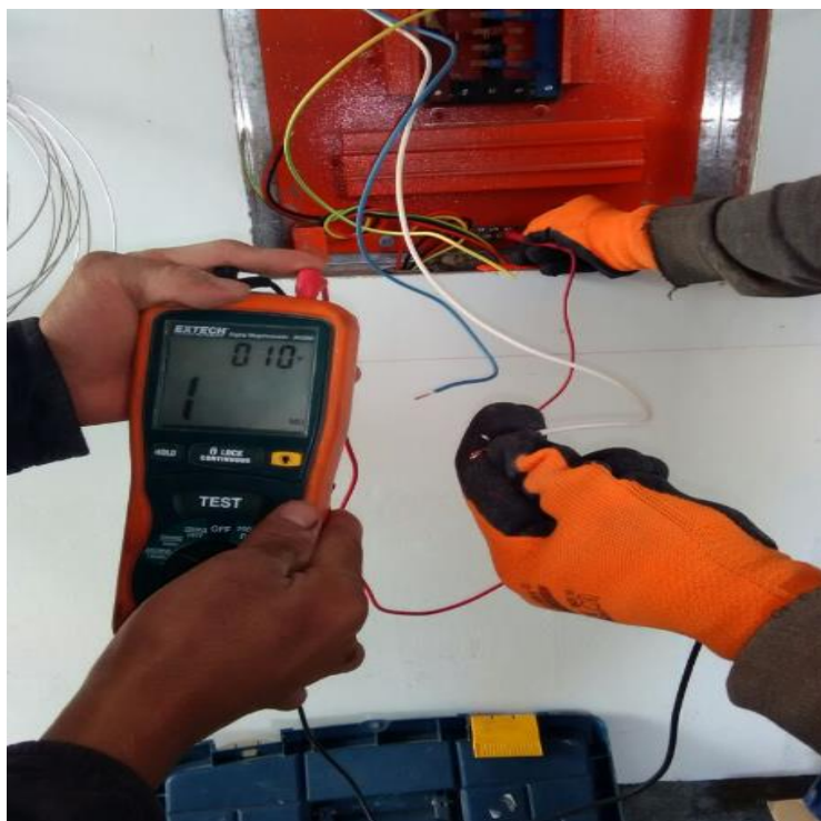
FOTO 15: Se realiza el megado de los cables Instalados en el módulo III.
