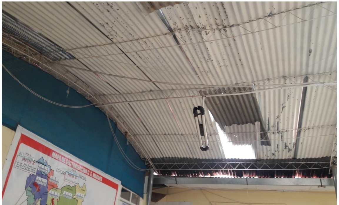
FOTO 10: En esta toma se observa las las estructuras metálicas (viguetas) pandeados, la cobertura de calaminon se encuentra en precarias condiciones (calaminones sin anclaje).
