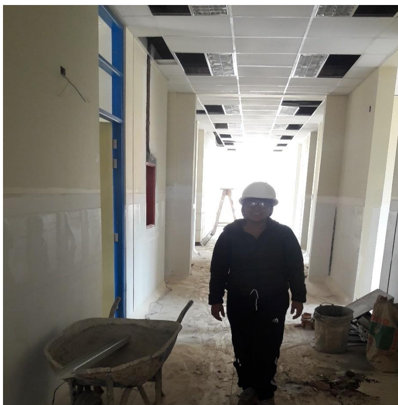
FOTO 04: En la toma se aprecia la instalación de los luminaires interiores en la zona de circulación empotrados en el falso cielo raso de 60x20x10 cm.
