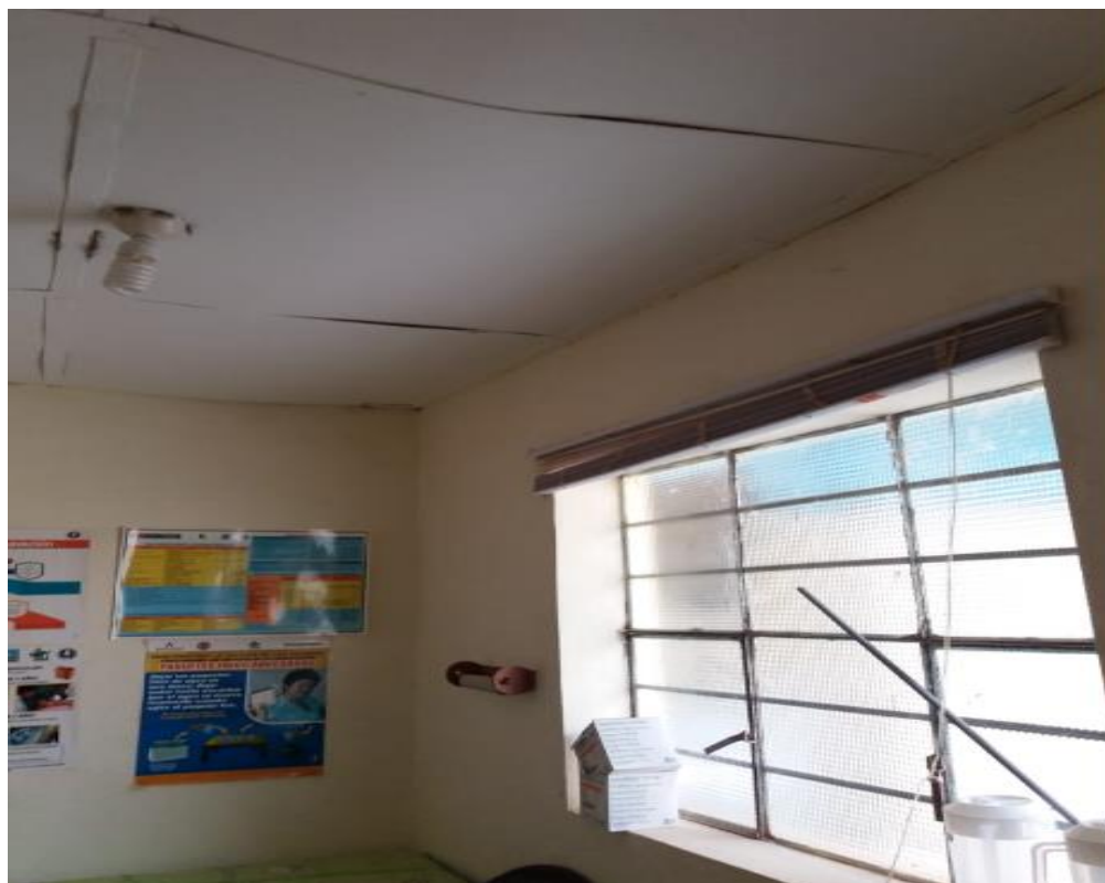
FOTO 22: Ventana con marco de metales interiores
