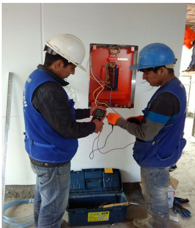
OTO 16: Se realiza el megado de los cables Instalados en el módulo IV.
