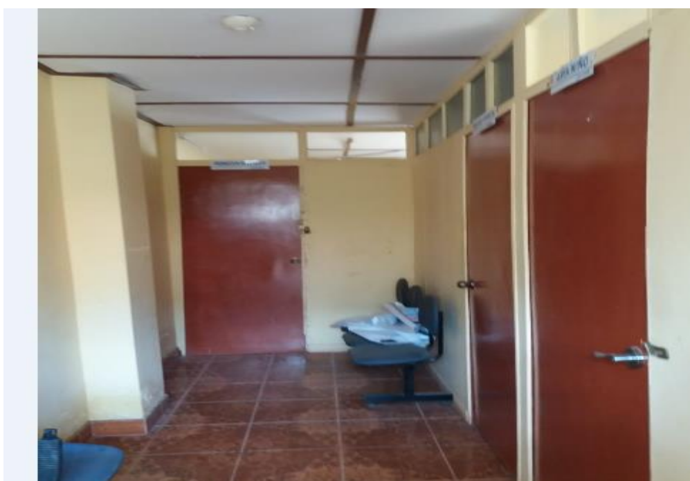
FOTO 23: en la toma se observa las Puertas interiores contraplacadas.
