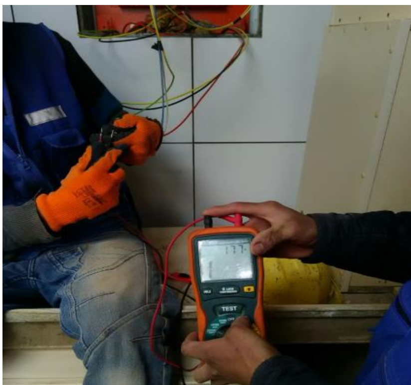
FOTO 18: Se realiza el megado de los cables Instalados en el modulo IV.
