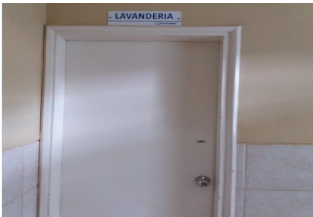
FOTO 25: en esta toma se puede observar la Puerta contra placada en el área de lavandería
