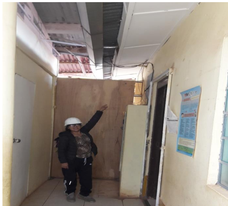
FOTO 09: En la foto se aprecia la inadecuada instalación eléctrica en el módulo de contingencia.
