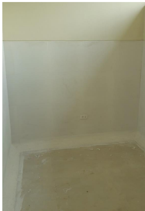
FOTO 04: En la foto se aprecia los muros terminados con cerámica de color blanco, también se visualiza contrazocalo sanitario de terrazo pulido hecho en obra.
