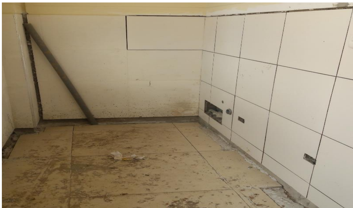
FOTO 03: En la foto podemos observar el terminado del piso porcelanato antideslizante.
