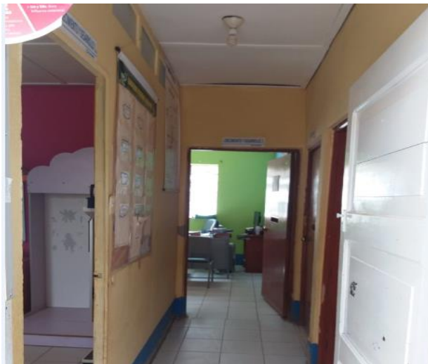
Muro provisional de triplay
