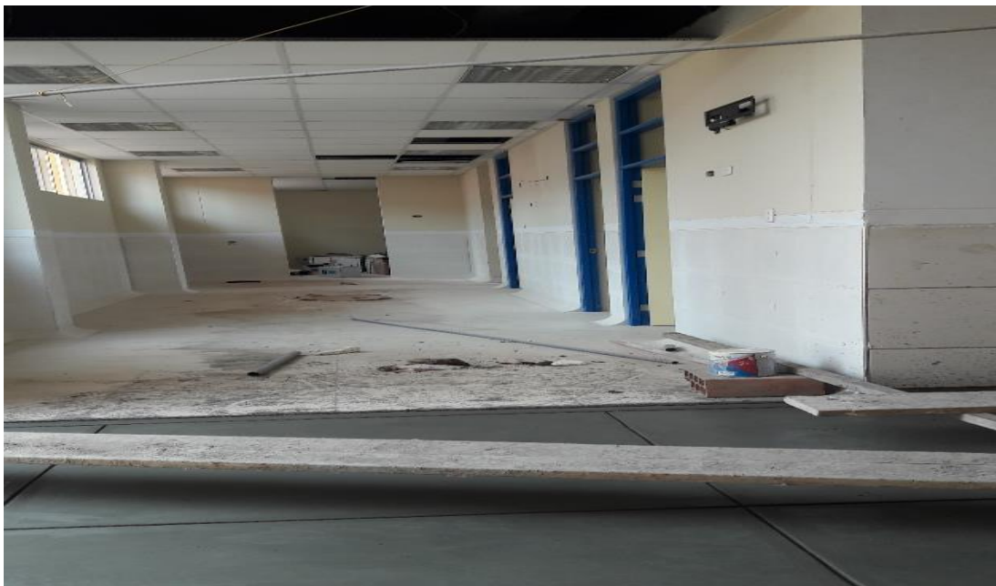
FOTO 02: En la foto se observa el acabado final de una superficie destinada especialmente al tránsito de personas-piso-contra piso.
