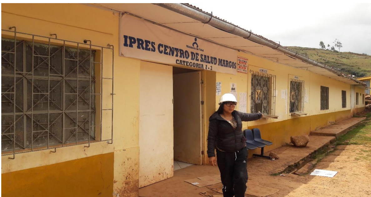
FOTO 12: en la foto se aprecia que las veredas y sistema de drenaje se encuentran en pésimas condiciones.
