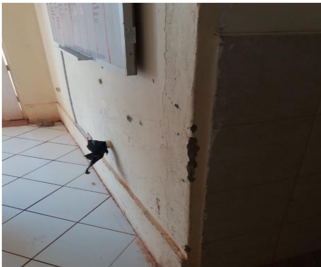
FOTO 26: se puede apreciar la Pintura en interior está deteriorado.
