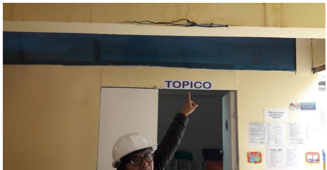
FOTO 08: En la toma se puede apreciar la presencia de humedad en el cielorraso y la viga principal presenta fisuras.
