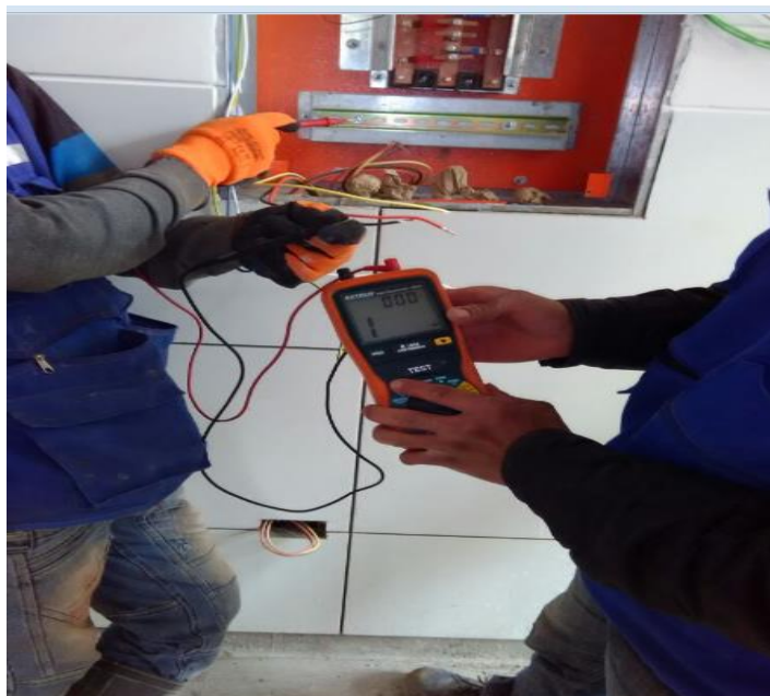
FOTO 14: En la foto se aprecia que se está realizando el megado de los cables Instalados en el modulo II.
