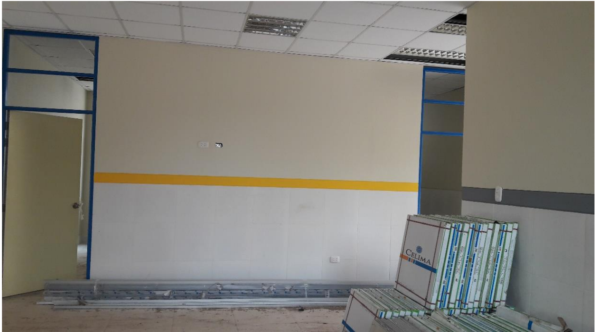
FOTO 09: Iniciando con la partida de pintura en los muros interiores del modulo III.
