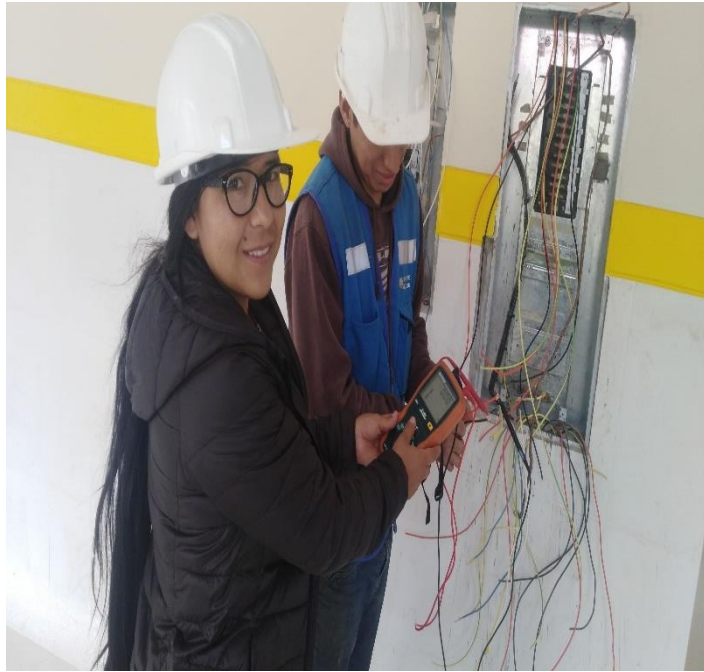
FOTO 13: En la foto se aprecia que se está realizando el megado de los cables Instalados en el módulo I.
