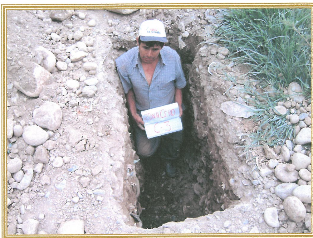
VISTA FOTOGRÁFICA DE LA CALICATA N° 03
