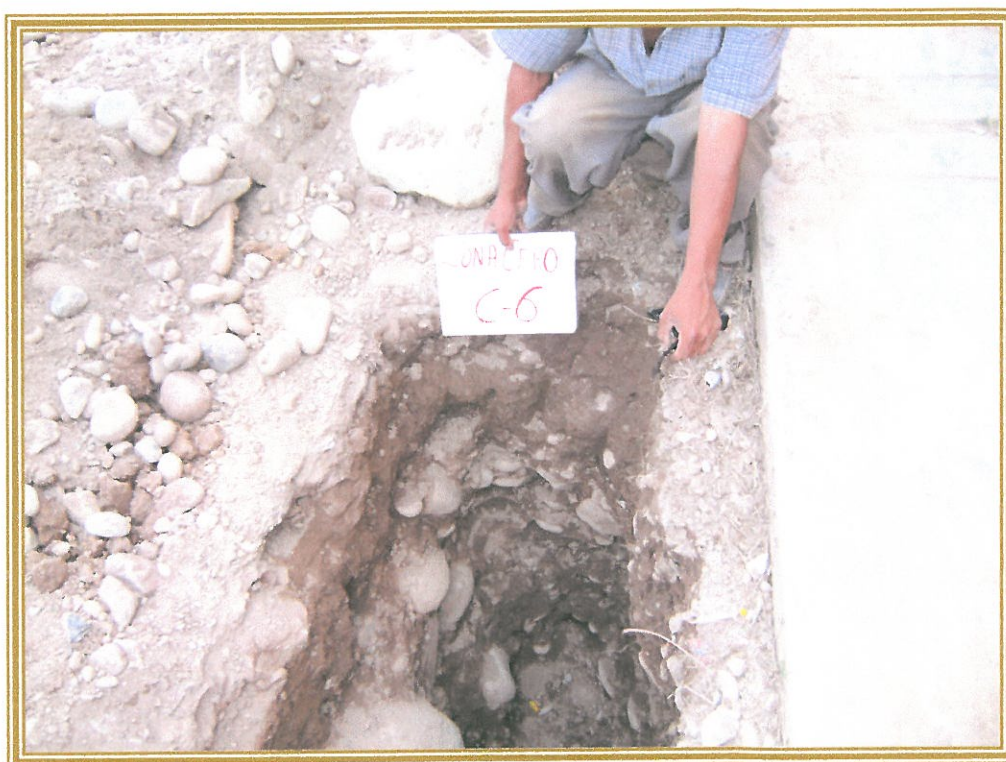
VISTA FOTOGRÁFICA DE LA CALICATA N° 06
