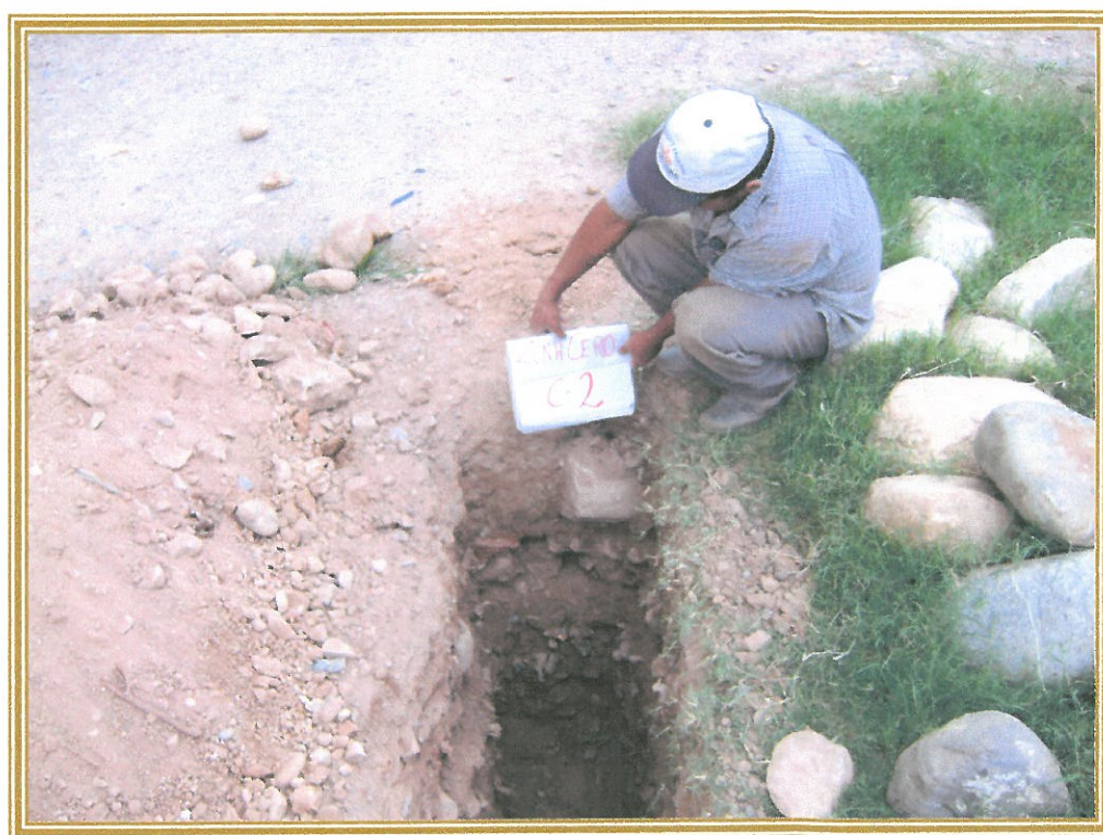
VISTA FOTOGRÁFICA DE LA CALICATA N° 02
