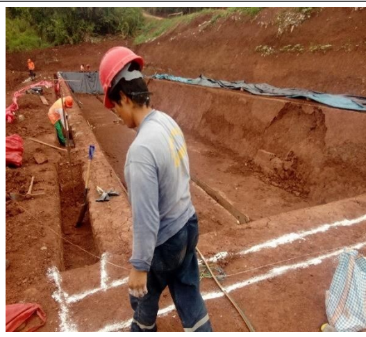
Se aprecia la instalacion y nivelacion de la tuberia de 6" alcantarillados que conecta los lixiviados proveniente de la trinchera N° 1 y 2 a los pozos de lixiviados.
