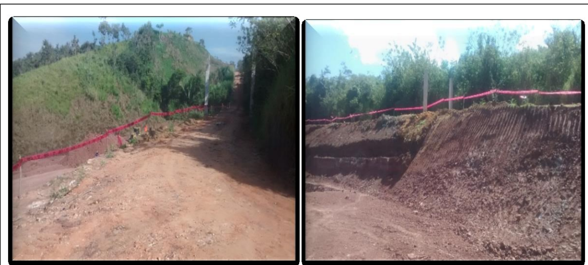
Se aprecia la señalizacion con cinta de seguridad a lo largo de todo el area de trabajo del relleno sanitario.
