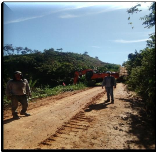
IMAGEN N°03: Se aprecia los inicios de los trabajos de corte con maquinaria pesada. Por otro lado apreciamos el corte y peinado del talud en la primera plataforma, eliminacion de material organico y basura acumulada.
