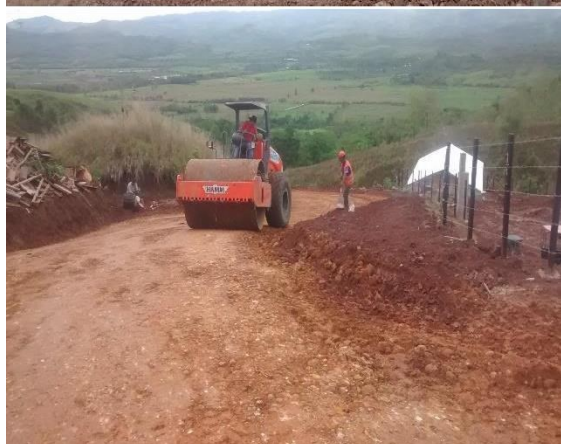
Se aprecia la conformacion de la rasante a traves del proceso de ripiado, se ve a la maquina esparciendo el material y a la otra compactandola en capas para tener la cota adecuada.
