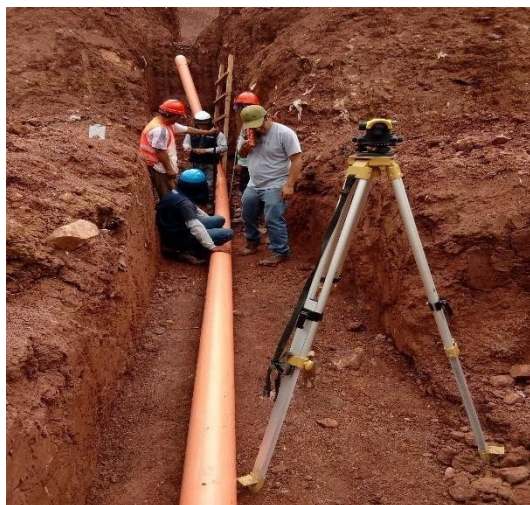
Se aprecia la instalacion y nivelacion de la tuberia de 6" alcantarillados que conecta los lixiviados proveniente de la trinchera N° 1 y 2 a los pozos de lixiviados.
