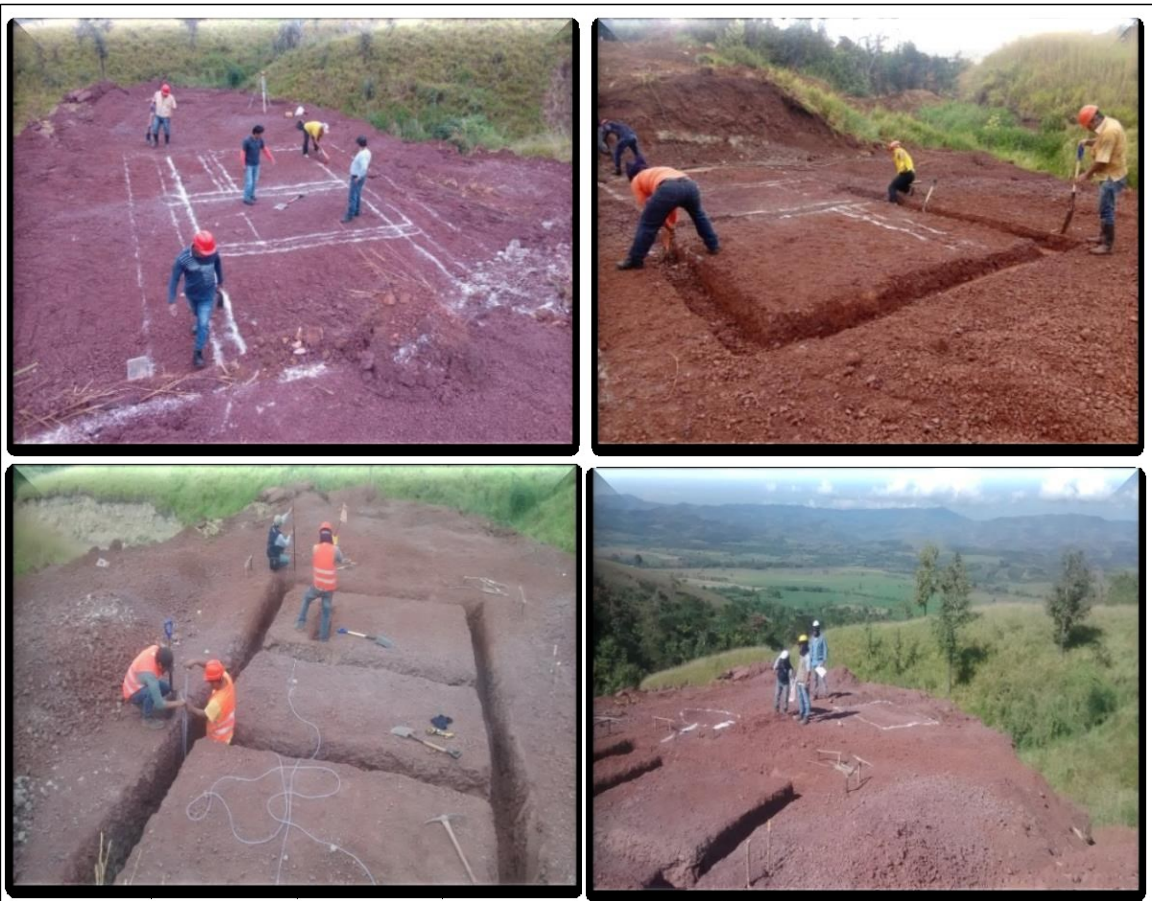
Se ve el trazado de los ejes del cimiento corrido de la caseta administrativa y tambien el trazado del diametro del pozo percolador, posteriormente se realiza la excavacion manual con una profundidad de 0.60m
