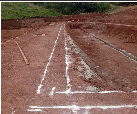
Se aprecia la instalacion y nivelacion de la tuberia de 6" alcantarillados que conecta los lixiviados proveniente de la trinchera N° 1 y 2 a los pozos de lixiviados.
