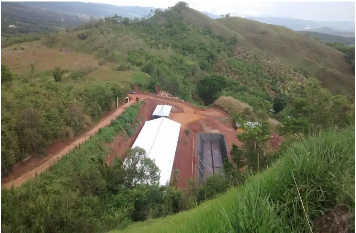
Se aprecia una vista completa de la obra concluida y de todas las componentes del relleno sanitario manual.
