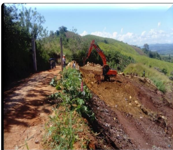
IMAGEN N°03: Se aprecia los inicios de los trabajos de corte con maquinaria pesada. Por otro lado apreciamos el corte y peinado del talud en la primera plataforma, eliminacion de material organico y basura acumulada.
