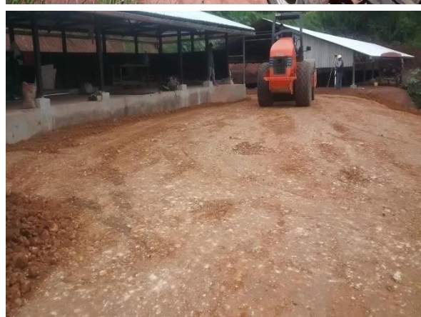
Se aprecia la conformacion de la rasante a traves del proceso de ripiado, se ve a la maquina esparciendo el material y a la otra compactandola en capas para tener la cota adecuada.
