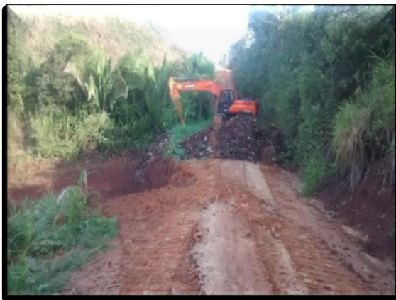
IMAGEN N°03: Se aprecia los inicios de los trabajos de corte con maquinaria pesada. Por otro lado apreciamos el corte y peinado del talud en la primera plataforma, eliminacion de material organico y basura acumulada.
