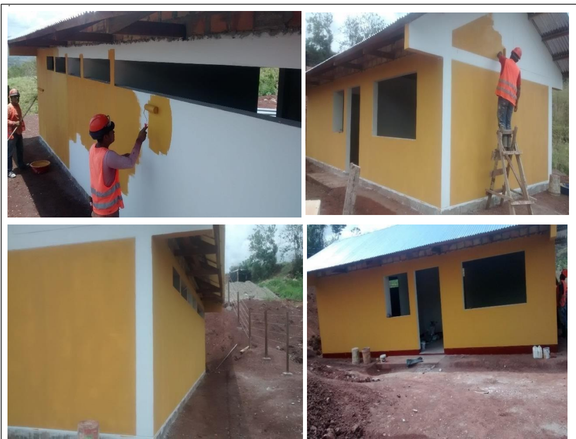
Se aprecia luego de alicada la pintura base, se proce a pintar la caseta administrativa de acuerdo a los colores indicados en los planos.
