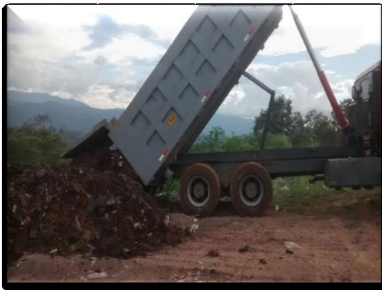
IMAGEN N°03: Se aprecia los inicios de los trabajos de corte con maquinaria pesada. Por otro lado apreciamos el corte y peinado del talud en la primera plataforma, eliminacion de material organico y basura acumulada.
