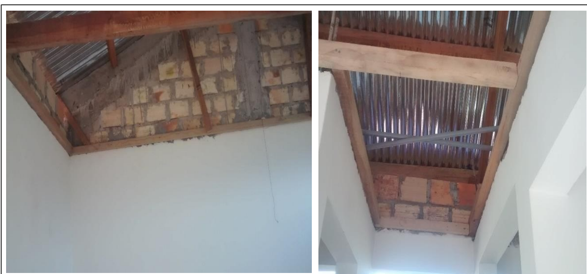
Se aprecia el marco para la colocacion del cielo raso en la caseta administrativa.
