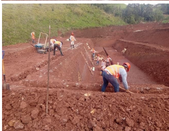
Se aprecia el trazo y excavacion de la zanja de anclaje de la geomenbrana, cuyos medidas eran de 40cm x70 de profundidad
