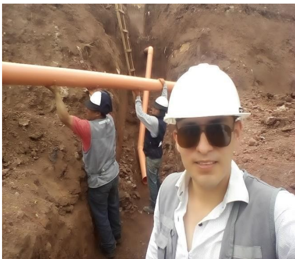
Se aprecia la instalacion y nivelacion de la tuberia de 6" alcantarillados que conecta los lixiviados proveniente de la trinchera N° 1 y 2 a los pozos de lixiviados.
