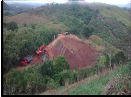
Se muestra el carguio de la basura almacenada y material excedente en el lugar destinada para el proyecto.
