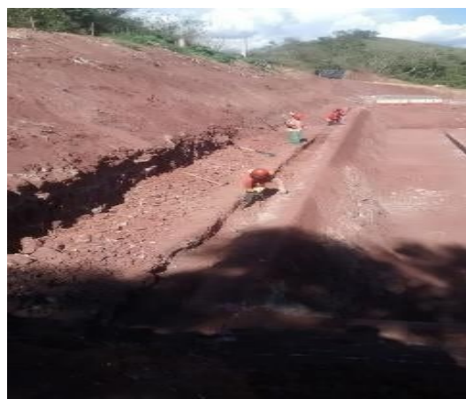
Se aprecia el trazo y excavacion de la zanja de anclaje de la geomenbrana, cuyos medidas eran de 40cm x70 de profundidad
