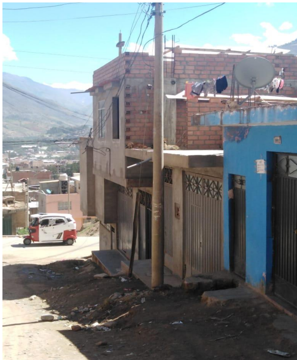
Foto 04: En esta imagen se aprecia viviendas de albañilería confinada en el sector 4.
