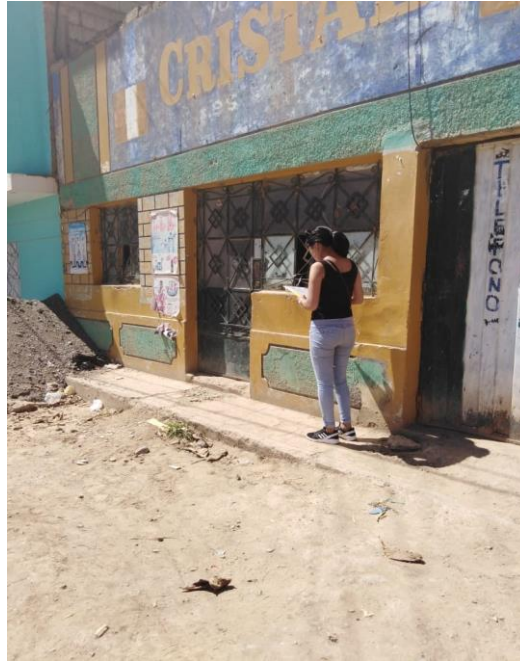
Foto 05: En esta imagen se aprecia viviendas de albañilería confinada en el sector 4.
