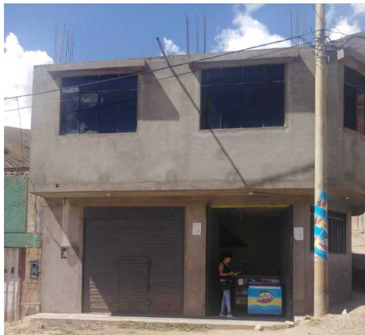
Foto 02: En esta imagen se aprecia una de las viviendas de albañilería confinada de dos pisos.
