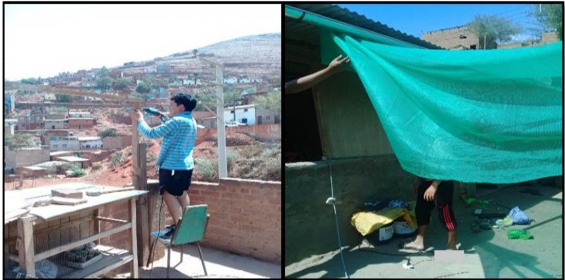
Fotografía 4: Construcción de la estructura para la sombra.
