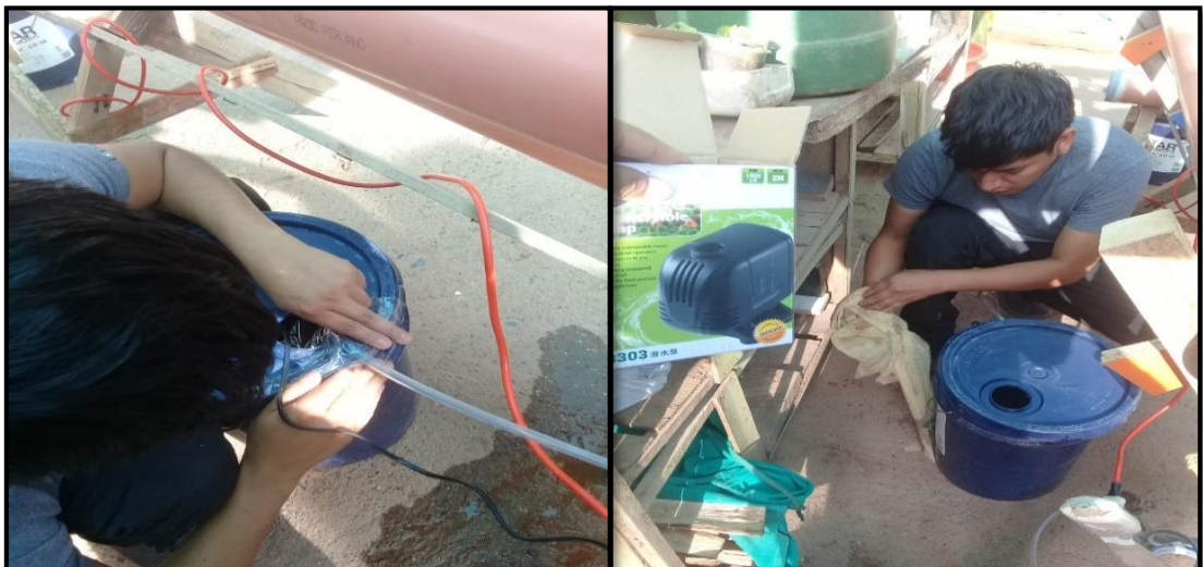
Fotografía 7: Instalación de las bombas de agua.
