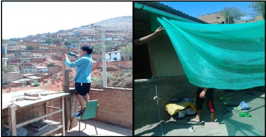
Figura 3: Construcción de la estructura de sombra.
