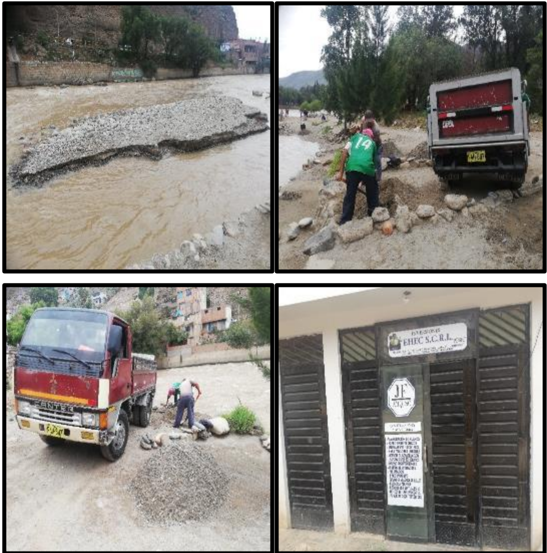
FOTO 42: PRIMERO OBTENEMOS EL MATERIAL COLMATADO Y LUEGO LO TRASLADAMOS AL LABORATORIO DONDE SE REALIZARÁ LA SELECCIÓN DE LOS MATERIALES.
