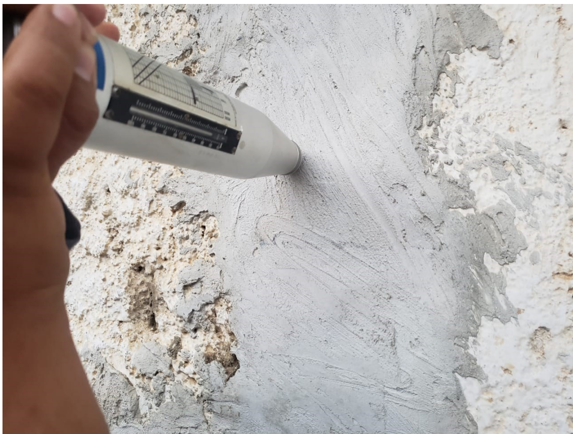
FOTO N°06- EVALUACION DE LA COMPRESION DE LA MAMPOSTERIA DE LADRILLOS CON ESCLEROMETRO.
