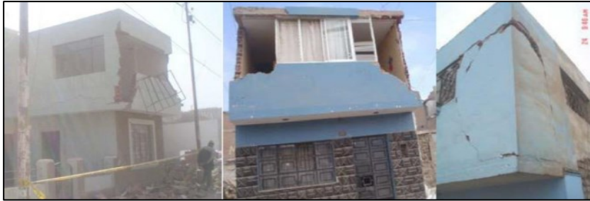
Figura N° 19. Tabiques sobre voladizos.
