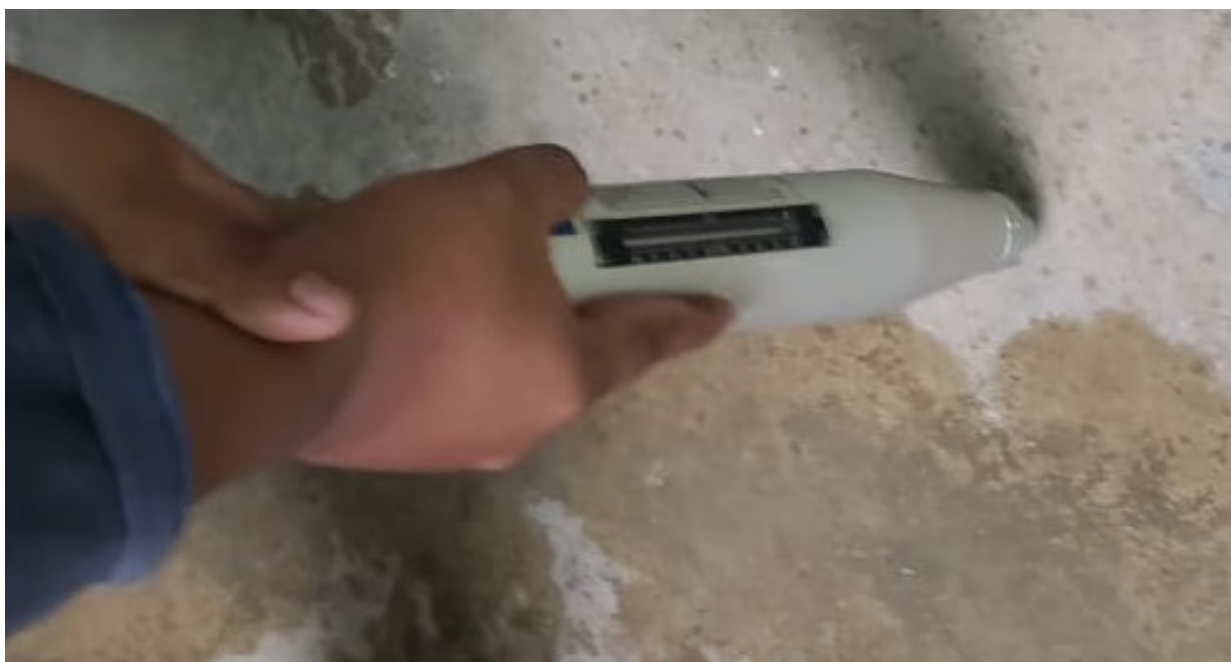
FOTO N°09- EVALUACION DE LA COMPRESION DE LA COLUMNA CON ESCLEROMETRO MERCADO ANTIGUO.
