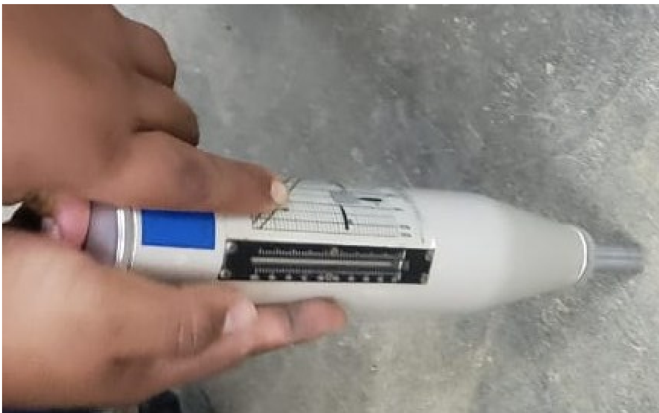
FOTO N°08- EVALUACION DE LA COMPRESION DE LA COLUMNA CENTRAL CON ESCLEROMETRO MERCADO MODELO.
