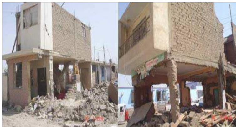
Figura N° 20. Primer piso de adobe, segundo piso de albañilería.
