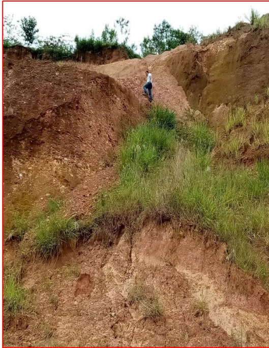
Imagen 6. Cuatro muestreos de suelos en cara del talud en tramo Las Vegas.
