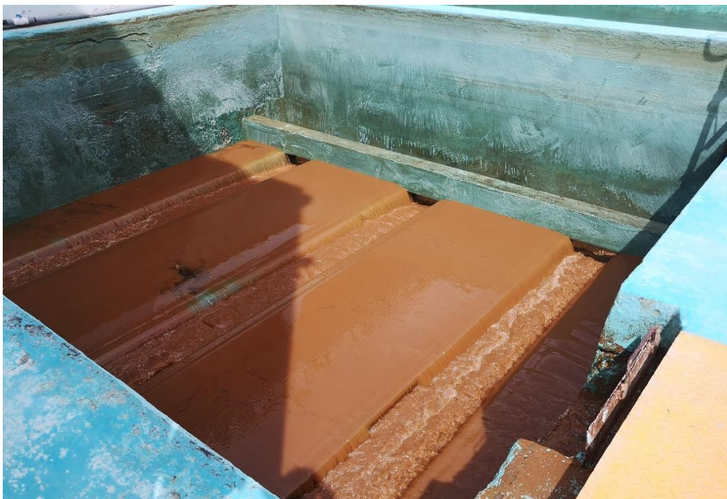
Lavado del Filtro rápido de la Planta de Tratamiento N°01
