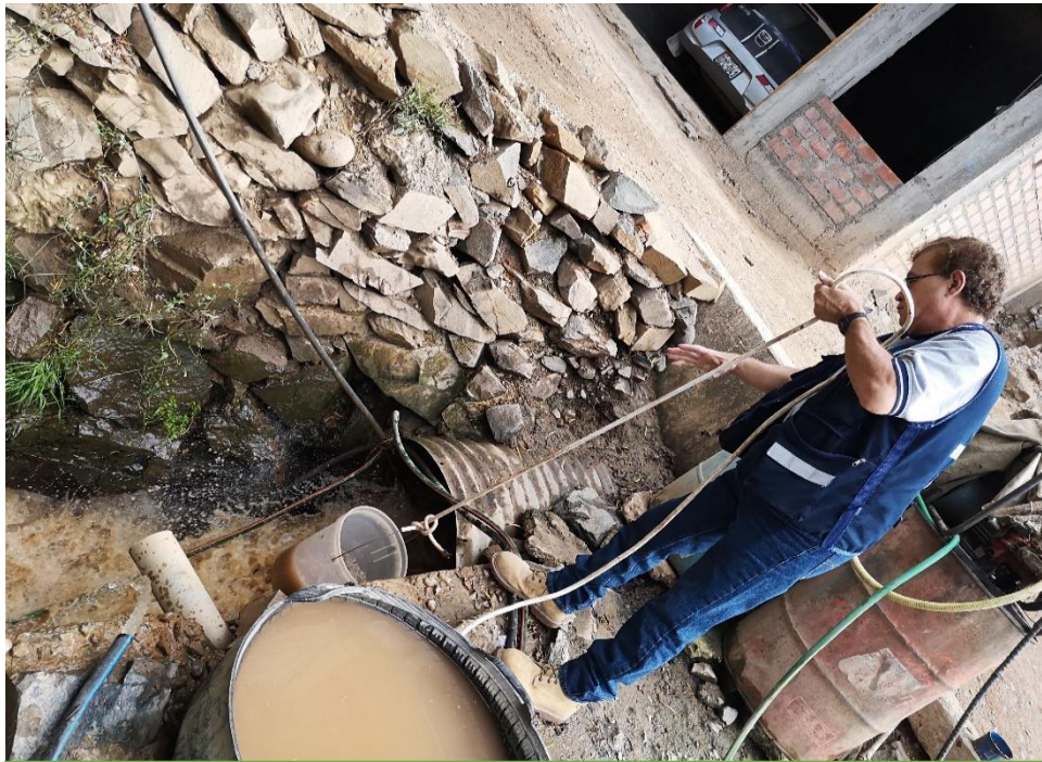
Monitoreo en el punto de vertimiento durante la limpieza del decantador de la Planta Cabritopampa de la EPS Seda Huánuco S.A por el Coordinador de Producción.
