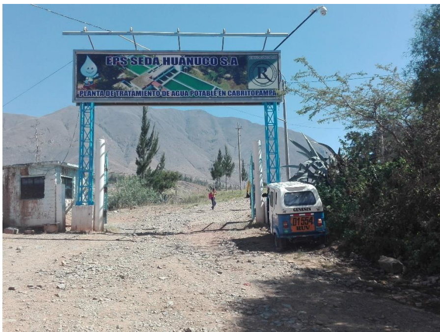
Puerta de ingreso a la Planta de Tratamiento de agua potable Cabritopampa
