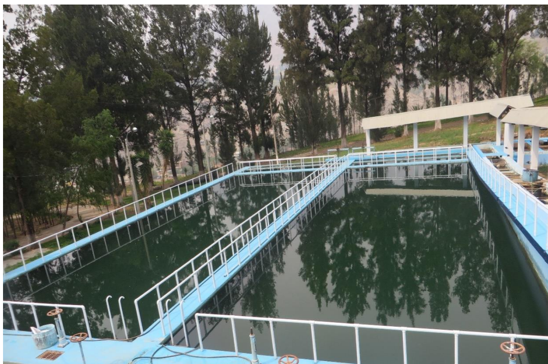
Decantadores de la Planta de Tratamiento N°01
