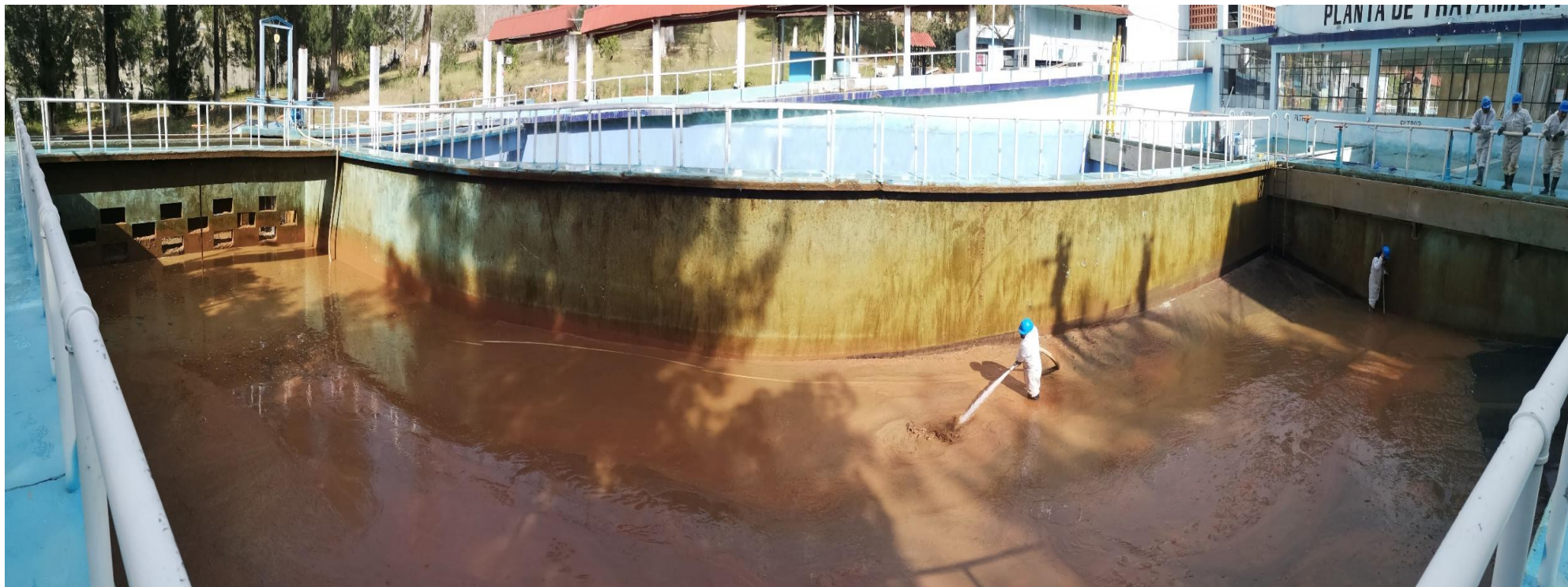
Limpieza de los lodos residuales durante la limpieza del decantador por los Operarios de la EPS Seda Huánuco.
