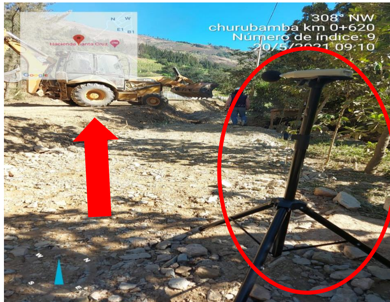
Fotografía 9: realización de monitoreo en puntos donde se realizan actividades de corte y eliminación ,trabajos realizados con maquinaria pesada
