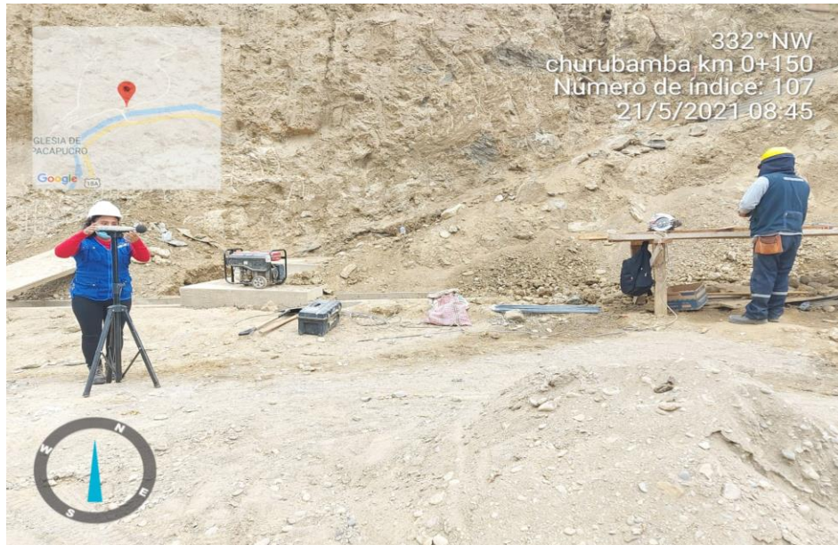
Fotografía 7: realizando el monitoreo de ruido en el km 0+150, la cual se están realizando trabajos de corte de fierros y utilización de generador y compactador eléctrico
