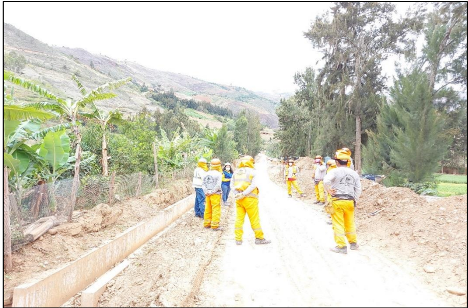
Fotografía 3: Realizando charlas de sobre los impactos sonoros negativos al personal obrero de cuadrilla del área de ferrería
