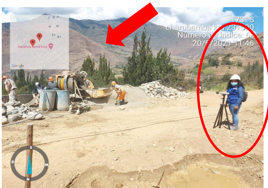
Fotografía 8: realización de monitoreo de ruido – km 23+390 – en las actividades de vaciado de concreto.
