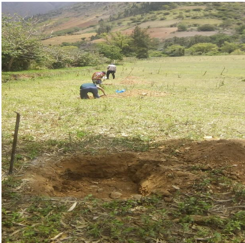
FOTOGRAFIA N° 5 EXCAVACION DE CALICATAS DEL AREA DE ESTUDIO CON PLANTACIONES DE EUCALIPTO
