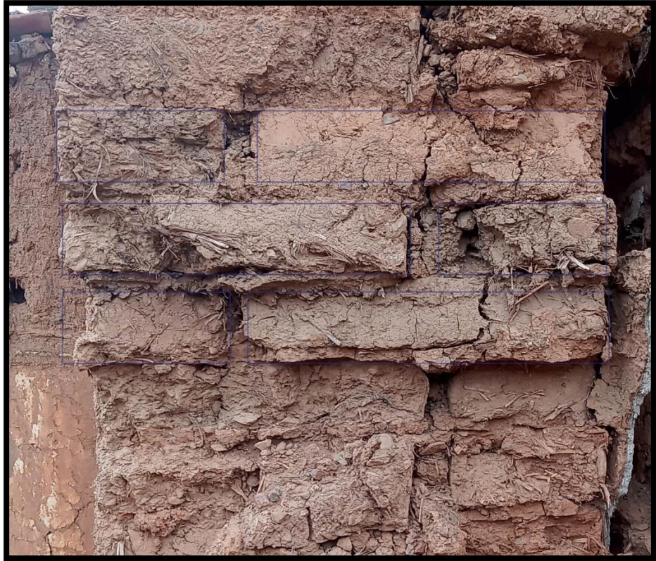
Figura 15 Imagen de la estructura del muro de la hacienda Vichaycoto.
