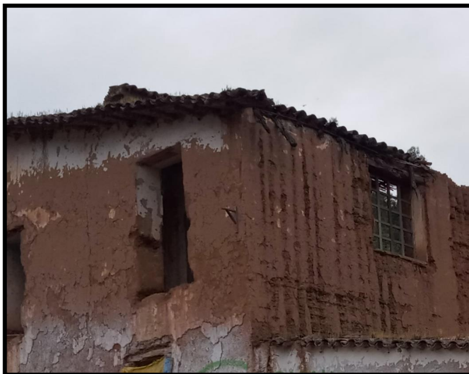
Figura 25 Imagen que evidencia la pérdida de color y revoques.
