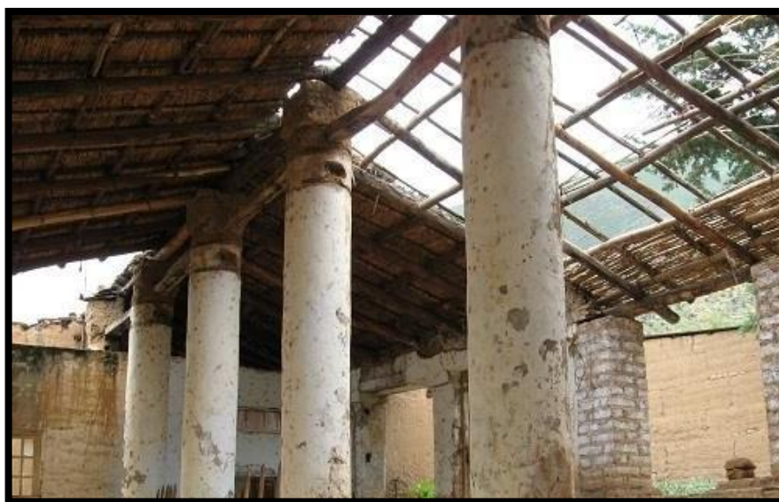
Figura 17 Imagen de la estructura del techo de la hacienda Vichaycoto.
