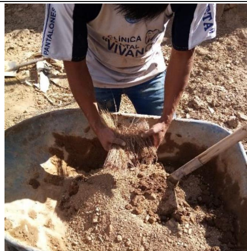
IMAGEN 12 : MESCLADO DE PAJA CON TIERRA
