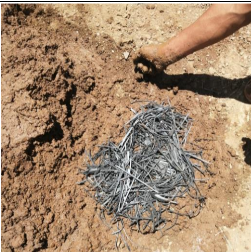
IMAGEN 11: MESCLADO DE FIBRA D ECAUCHO Y TIERRA
