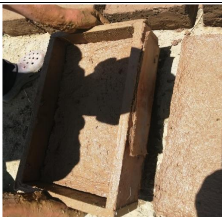
IMAGEN 17 : TECNICA DEL JALADO DE ADOBE
