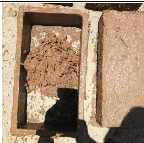
IMAGEN 14 : MOLDEADO DE ADOBES DE CAUCHO
