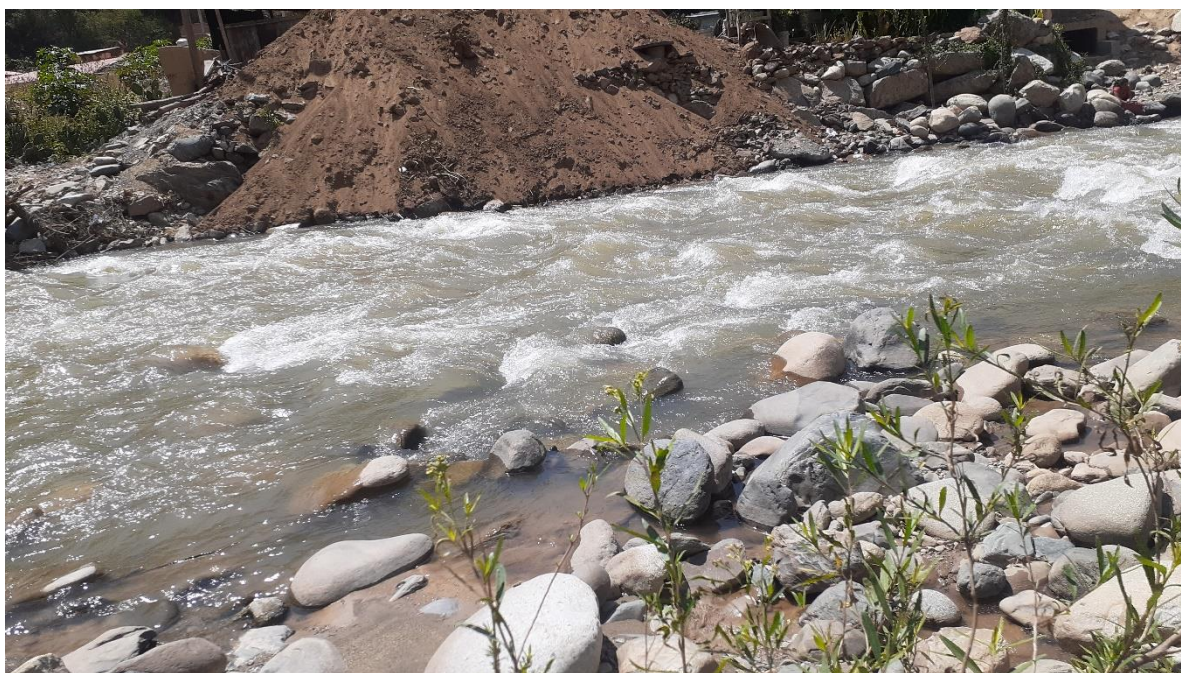
En esta imagen se aprecia como disponen sus materiales excedentes directamete al rio Higueras.
