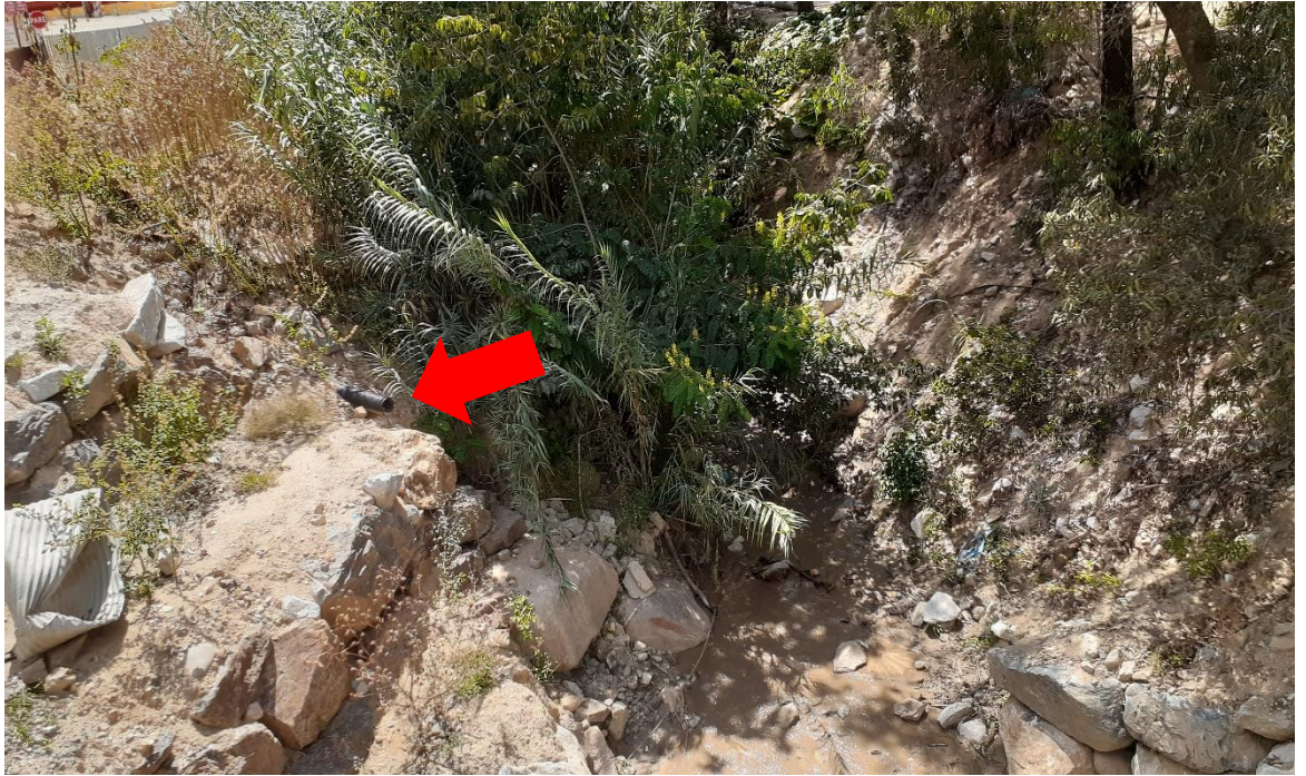
En esta imagen se aprecia que un desagüe desemboca directamente al río Yurayacu la cual termina en el río Higuera
