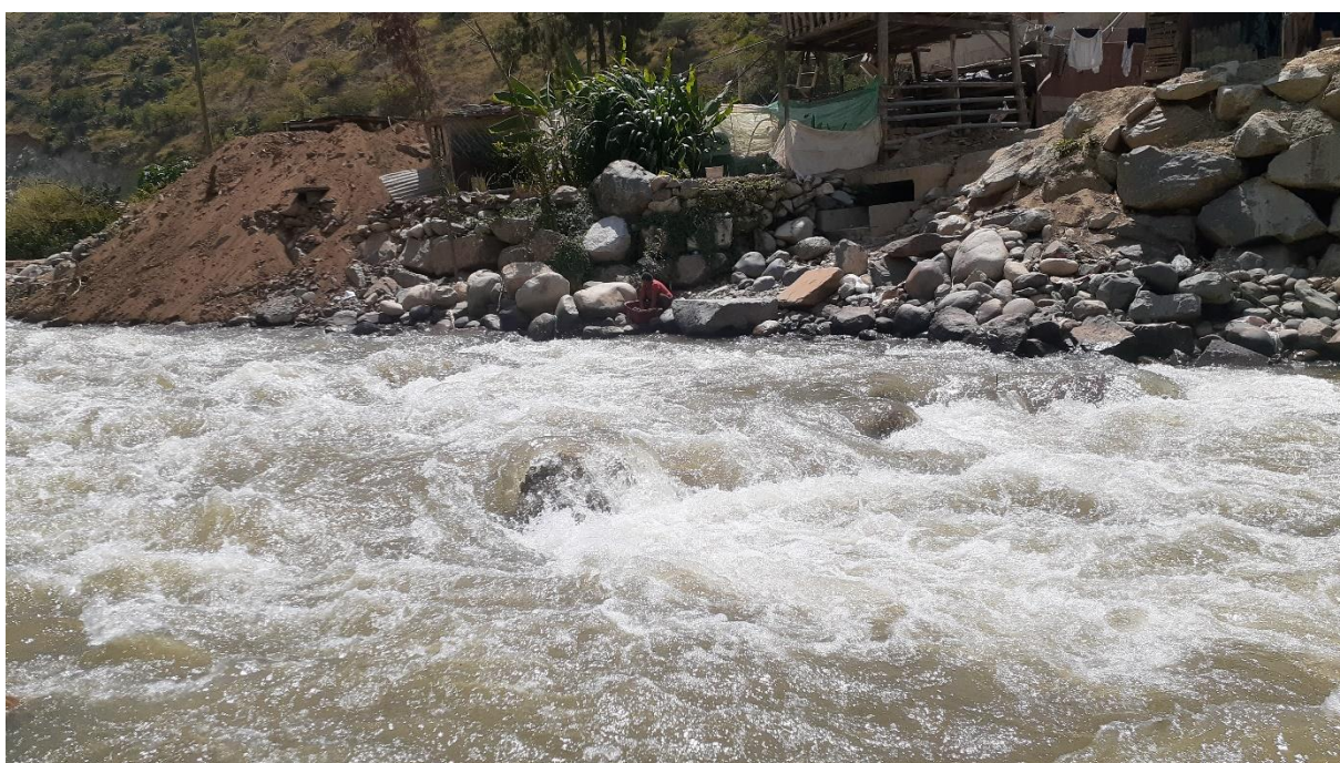
En esta imagen se aprecia la conexión del desagüe directamente al rio, y es donde las personas realizan sus actividades la lavandería.
