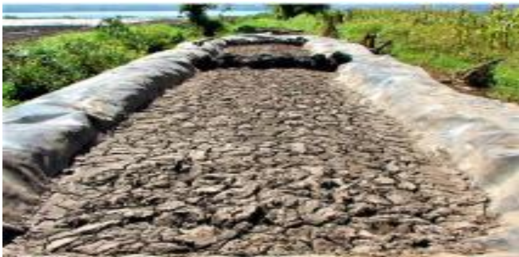
Lecho de secado de lodos
