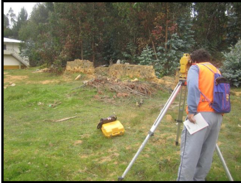
NIVELACION DEL TEODOLITO PARA INICIAR LOS TRABAJOS TOPOGRAFICOS
