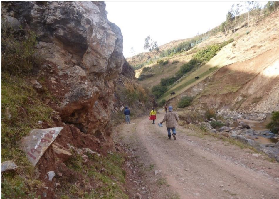
FOTO N°09 - KM 20+000 - DESGASTE DE PLATAFORMA POR CRECIDA DE RIO
