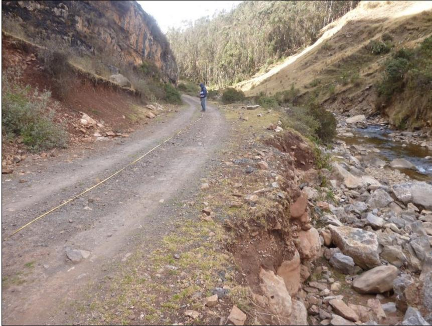
FOTO - KM 18+500 - DESGASTE DE PLATAFORMA POR CRECIDA DE RIO
