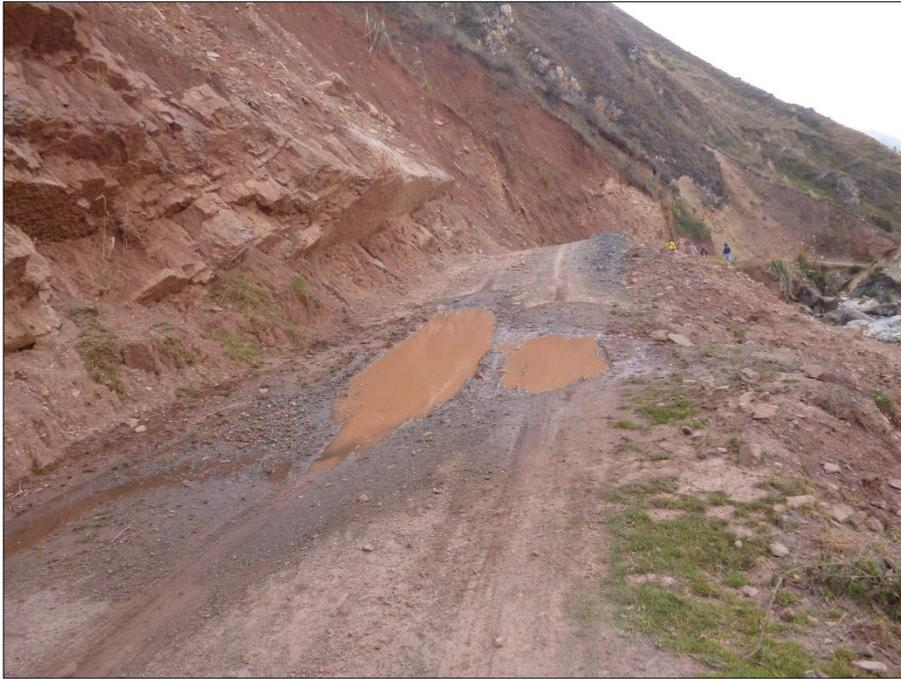
FOTO - KM 19+720 - DESPRENDIMIENTO DE TALUD
