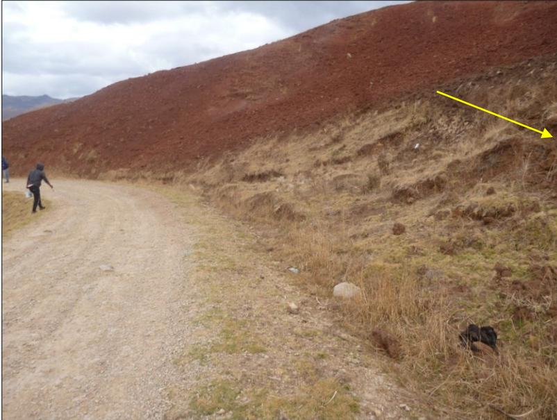
FOTO - KM 7+060 - DESPRENDIMIENTO DE TALUD
