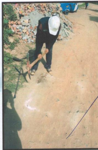
Ejecución de calicatas en la urbanización santa Elena
