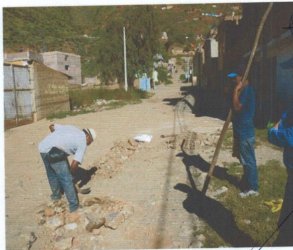
Imagen N° 04. Trabajo de campo para ubicación de buzones existentes
