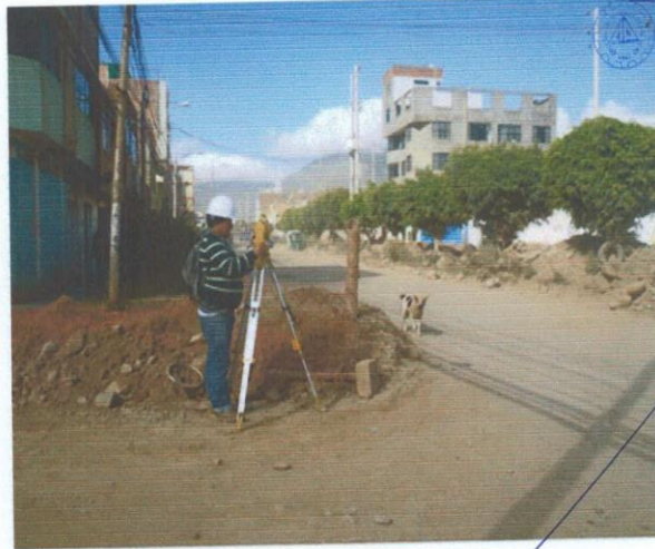
Imagen N° 06. Trabajo de campo en Jr. Bella Durmiente - inicio de tramo
