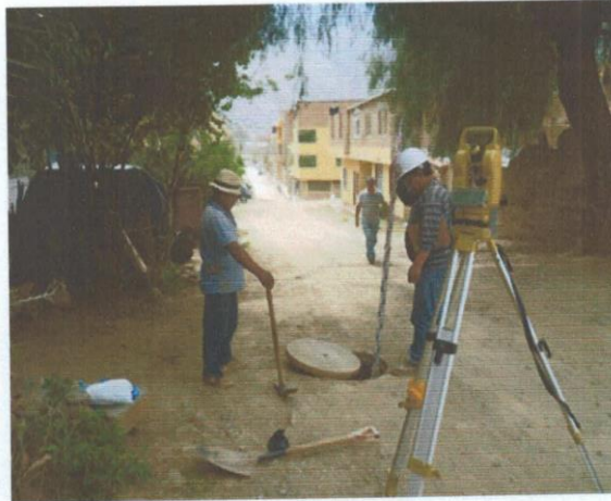
Imagen N° 11. Trabajo de ubicación de buzones existentes en Jr. Haya de la Torre
