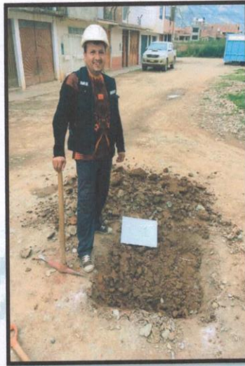
Ejecución de la calicata n°1 en el Calle S/N-05 Urbanización Santa Elena
