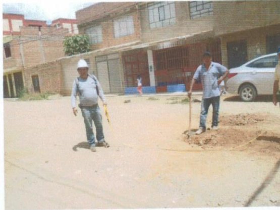
Imagen N° 01. Trabajo de campo para ubicación de buzones existentes
