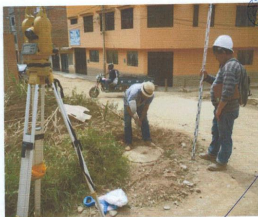
Imagen N° 10. Trabajo de ubicación de buzones existentes en Vía Principal
