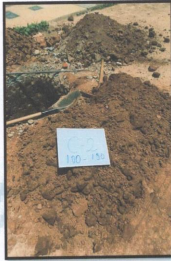
Ejecución de la calicata n°2 en la calle S/N -01 Urbanización Santa Elena.
