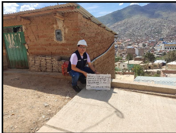
Se observa el tramo final de la pavimentación terminada
