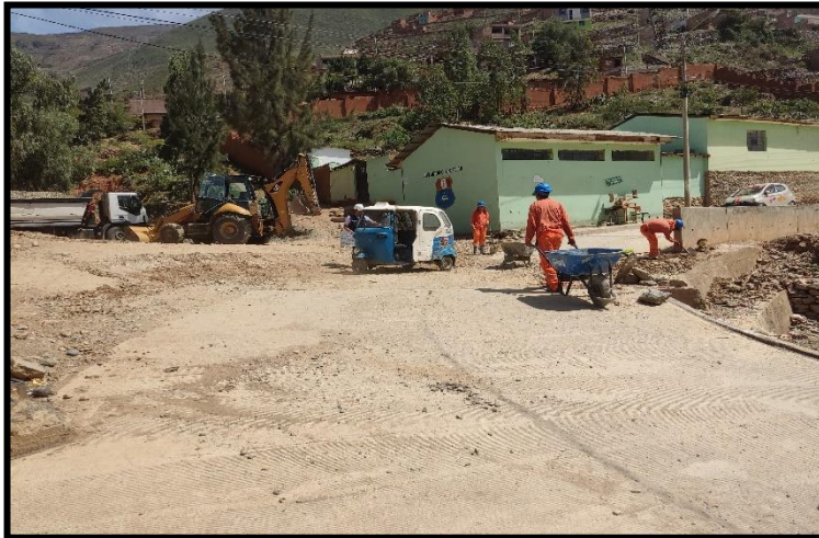
Se observa a los obreros trabajando en obra
