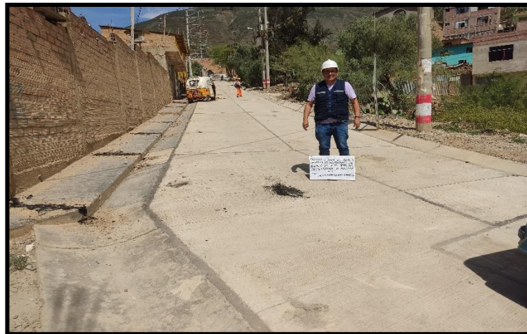
Se observa tramo de la pavimentación terminado
