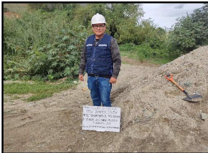
Se observa el agregado para la pavimentación
