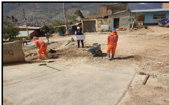
Se observa los trabajos en obra
