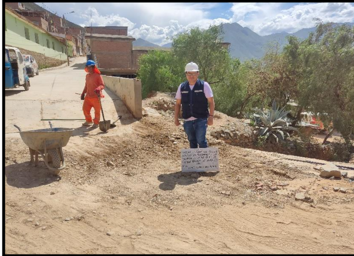
Se observa los trabajos en obra
