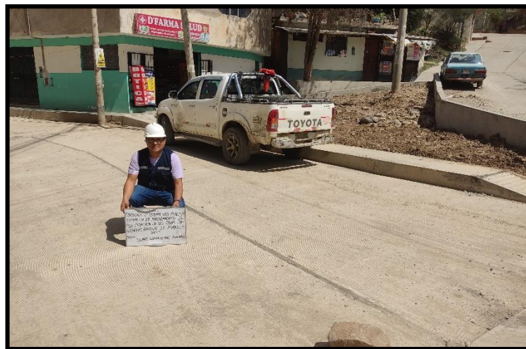
Se observa el inicio del tramo de la pavimentación terminado
