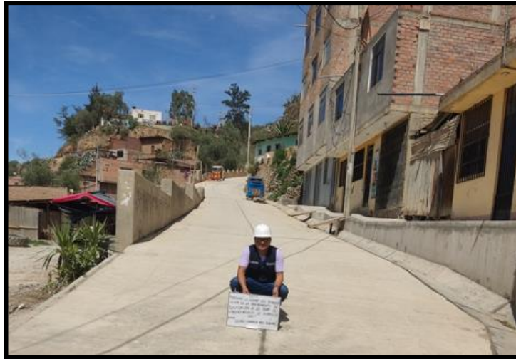
Se observa tramo de la pavimentación terminado
