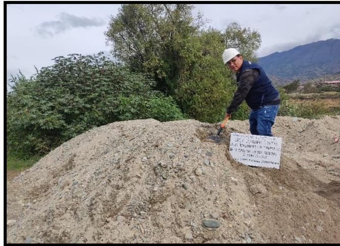
Se observa el agregado para la pavimentación
