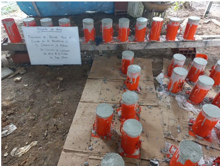
Figura 43 Fabricación de las probetas de concreto
