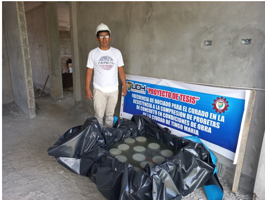
Figura 48 Curado de concreto por inmersión
