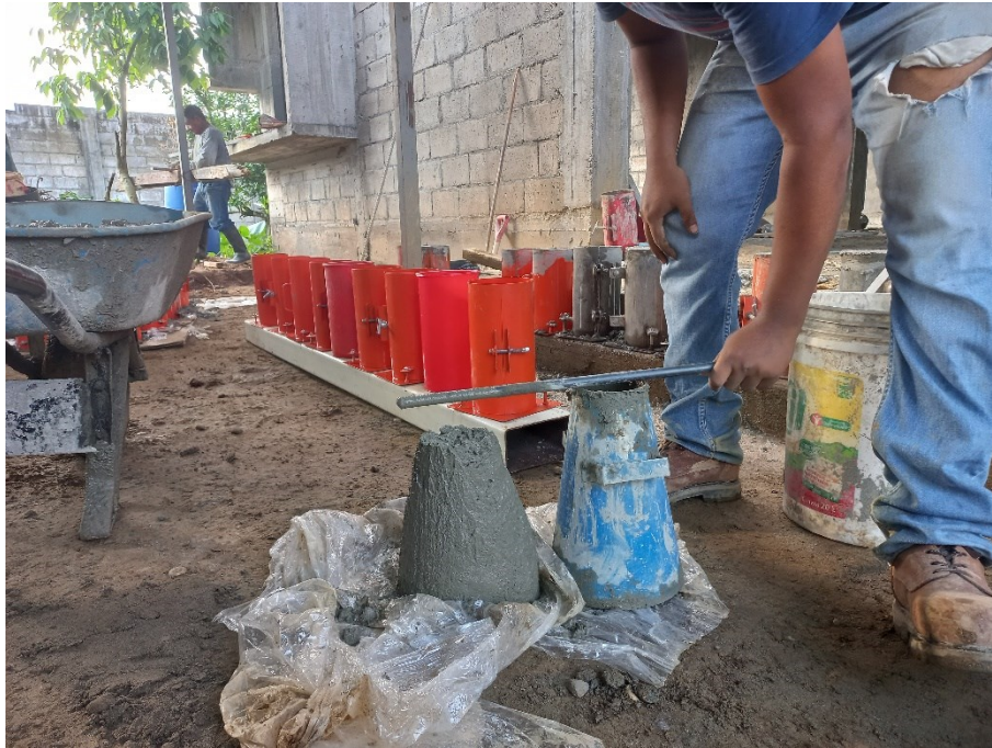
Figura 40 Verificación de asentamiento de concreto
