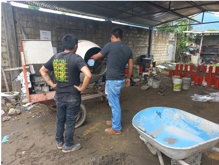
Figura 37 Mezclado de los agregados
