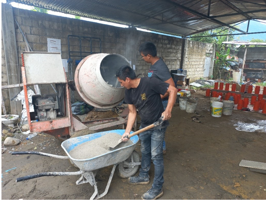
Figura 36 Mezclado de los agregados.
