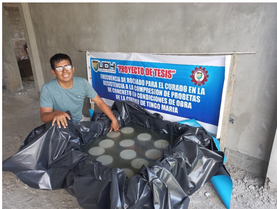
Figura 49 Curado de concreto por inmersión
