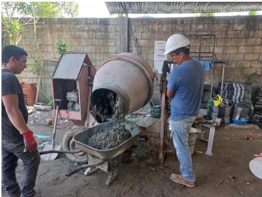
Figura 39 Obtención de la mezcla de concreto
