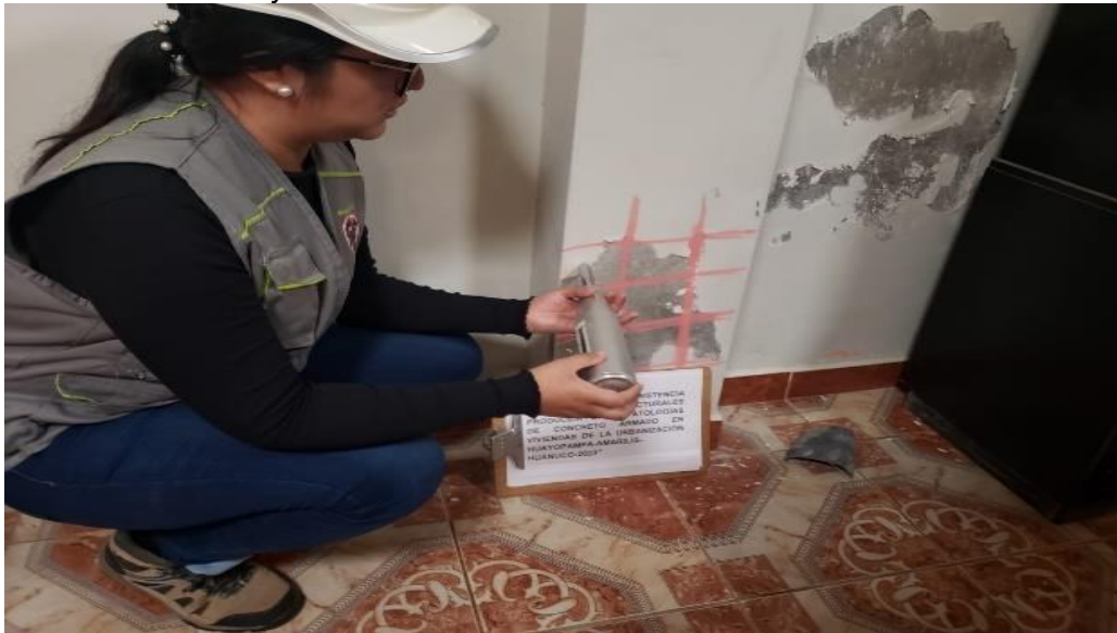
Figura 31 Realización del ensayo de esclerometría E-02
