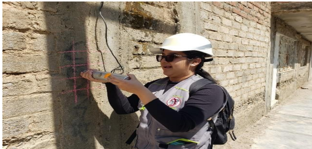
Figura 42 Realización del ensayo de esclerometría E-13
