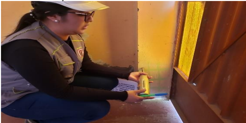
Figura 32 Realización del ensayo de esclerometría E-03
