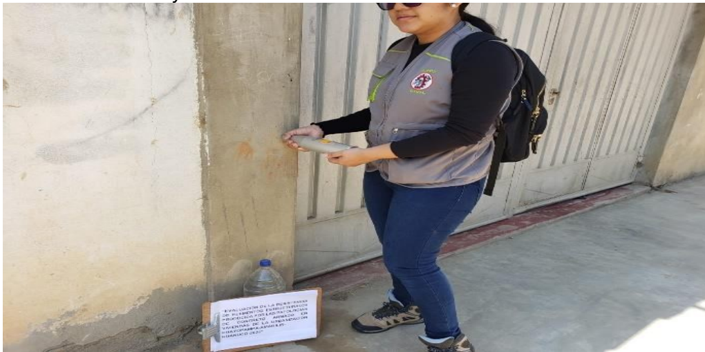
Figura 44 Realización del ensayo de esclerometría E-15
