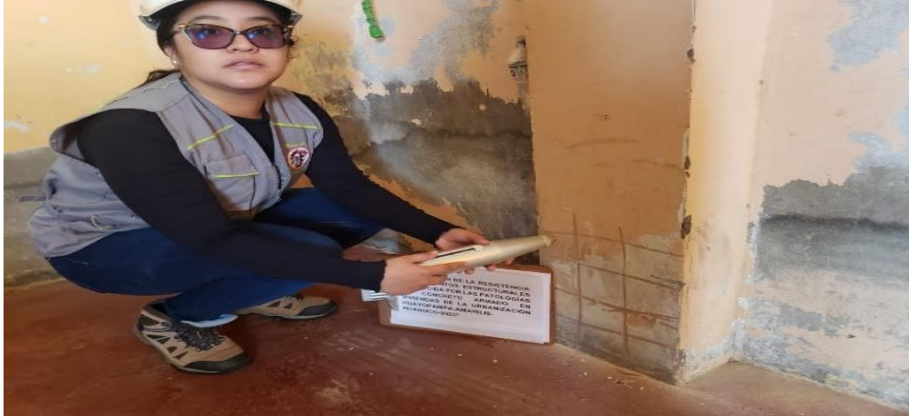
Figura 30 Realización del ensayo de esclerometría E-01
