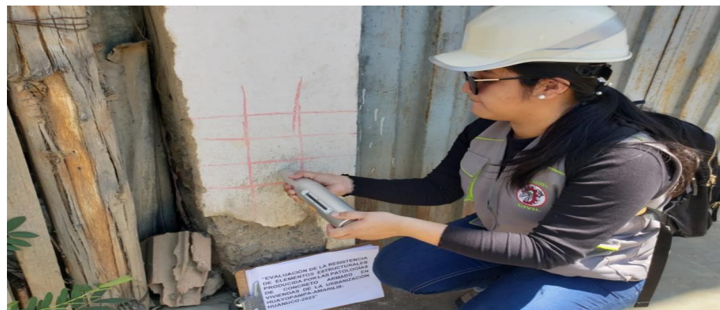
Figura 49 Realización del ensayo de esclerometría E-20
