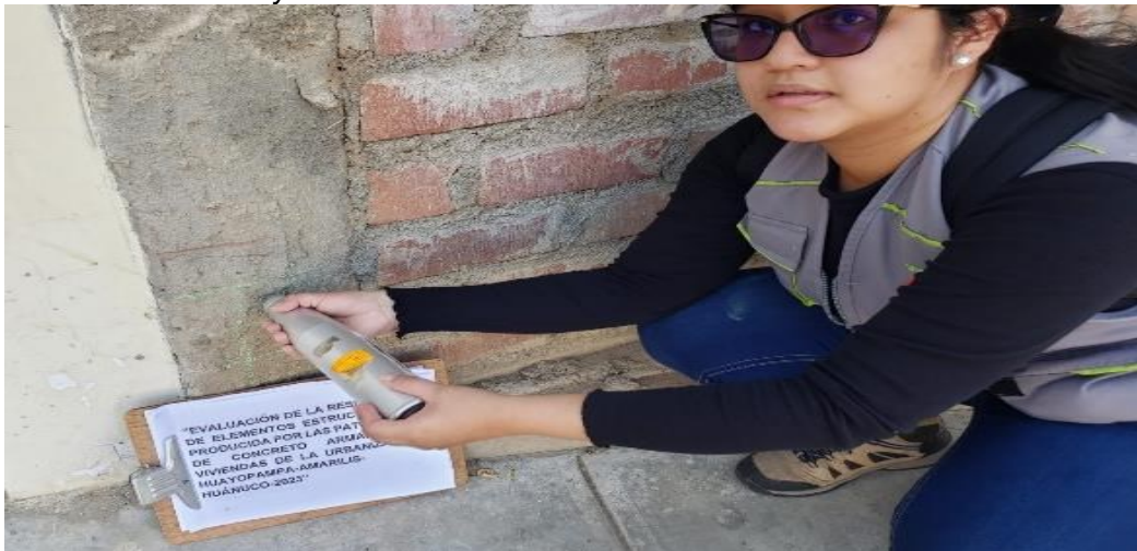
Figura 53 Realización del ensayo de esclerometría E-24
