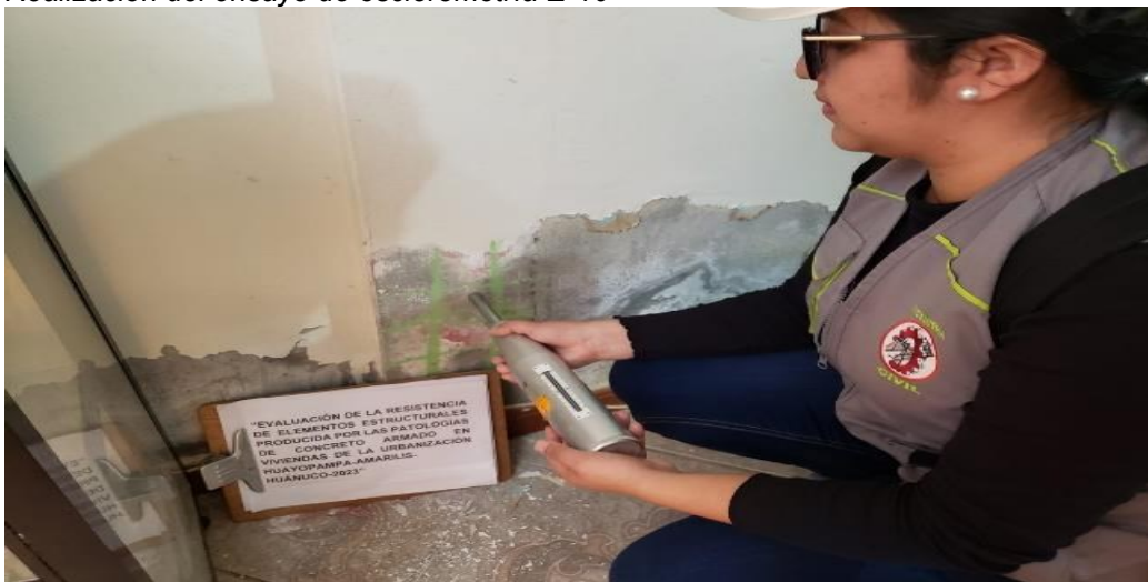
Figura 39 Realización del ensayo de esclerometría E-10
