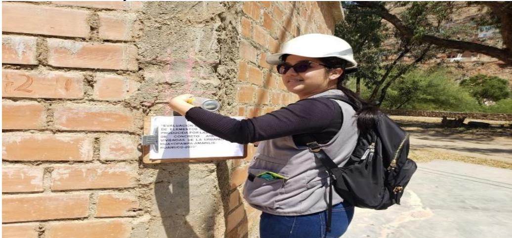
Figura 41 Realización del ensayo de esclerometría E-12
