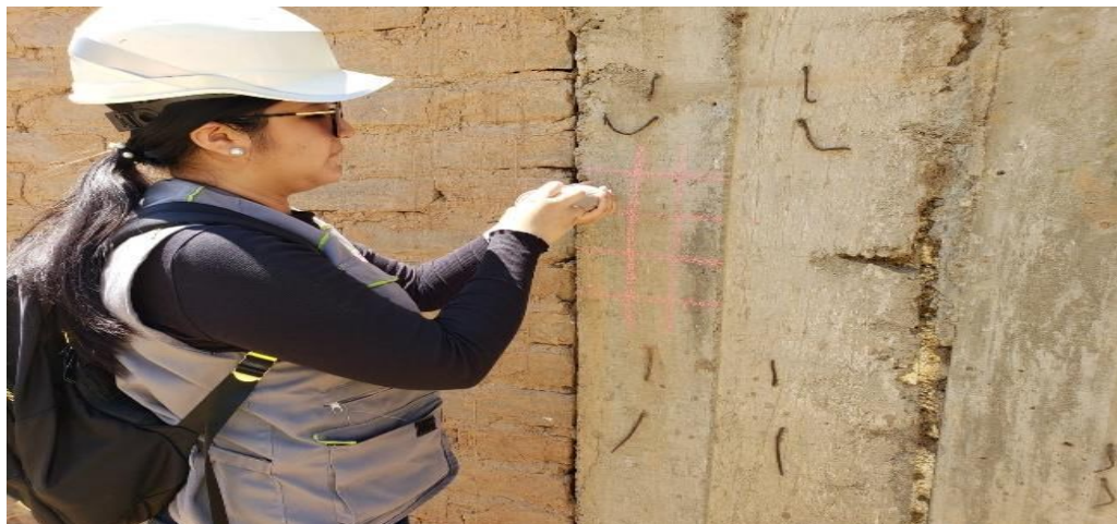
Figura 46 Realización del ensayo de esclerometría E-17
