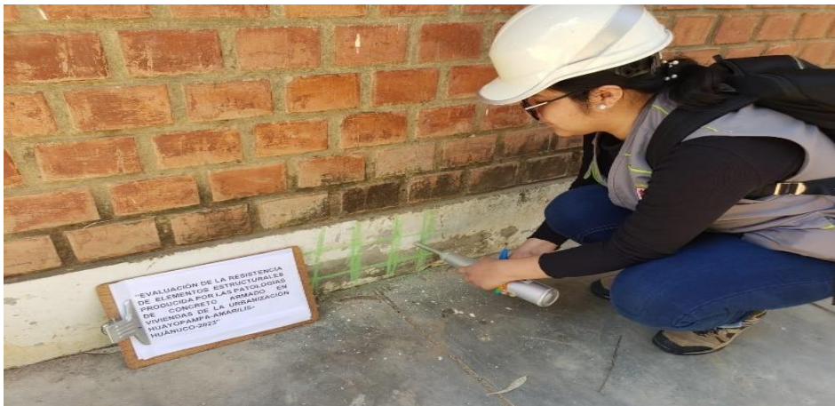
Figura 38 Realización del ensayo de esclerometría E-09
