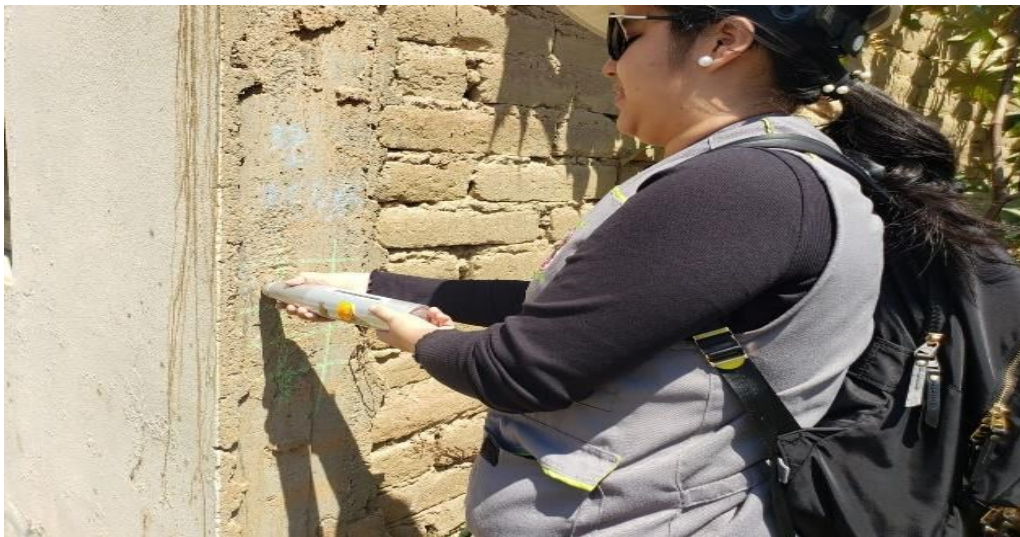
Figura 48 Realización del ensayo de esclerometría E-19
