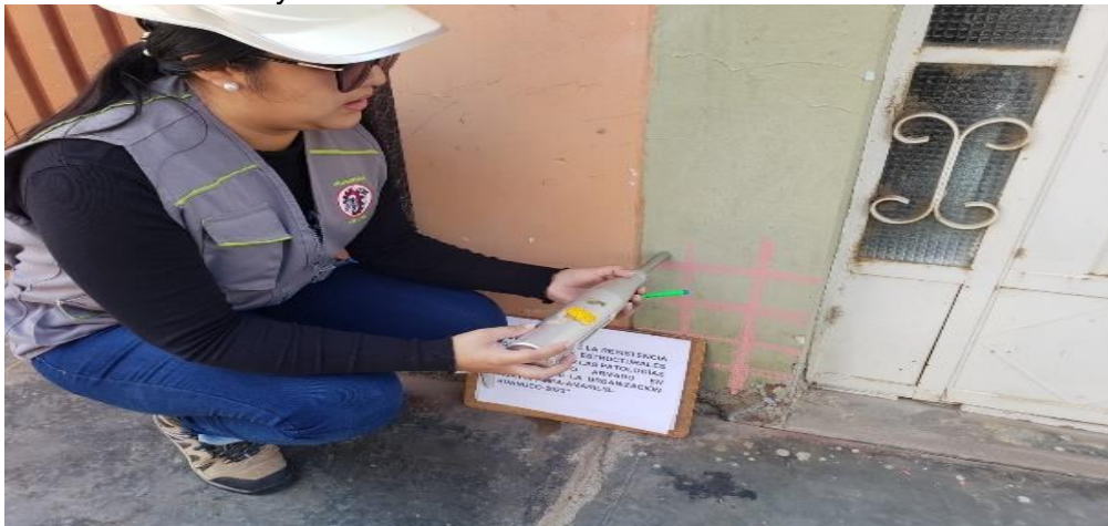
Figura 33 Realización del ensayo de esclerometría E-04
