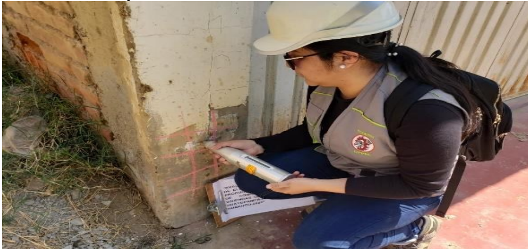
Figura 50 Realización del ensayo de esclerometría E-21
