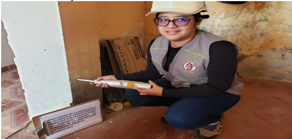
Figura 36 Realización del ensayo de esclerometría E-07
