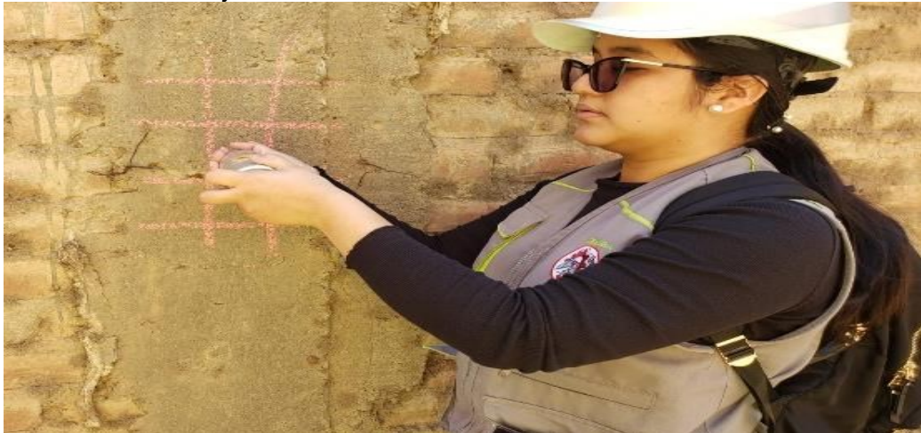
Figura 51 Realización del ensayo de esclerometría E-22
