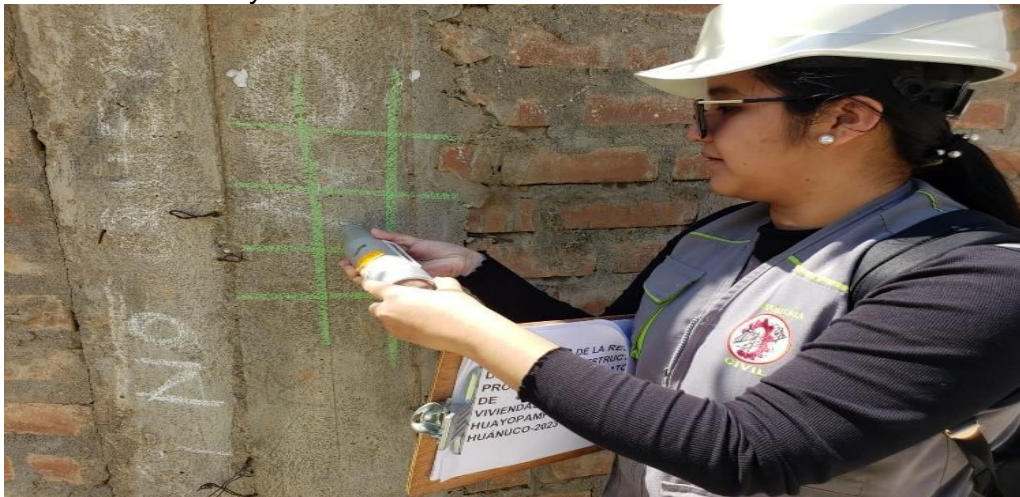
Figura 47 Realización del ensayo de esclerometría E-18
