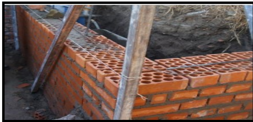
Figura 3 Albañilería armada
