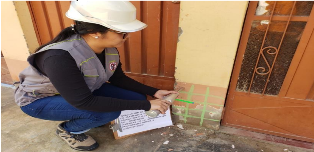
Figura 35 Realización del ensayo de esclerometría E-06
