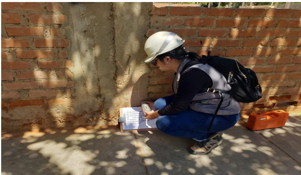
Figura 54 Realización del ensayo de esclerometría E-25
