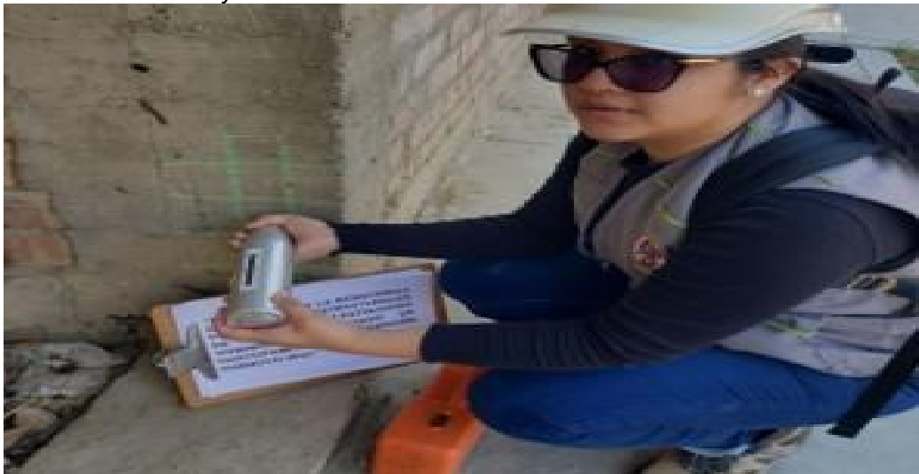
Figura 52 Realización del ensayo de esclerometría E-23
