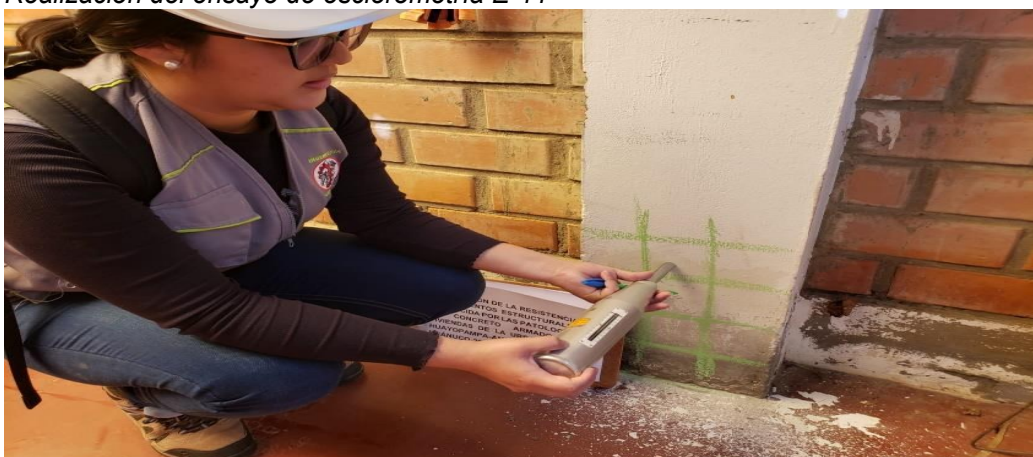
Figura 40 Realización del ensayo de esclerometría E-11
