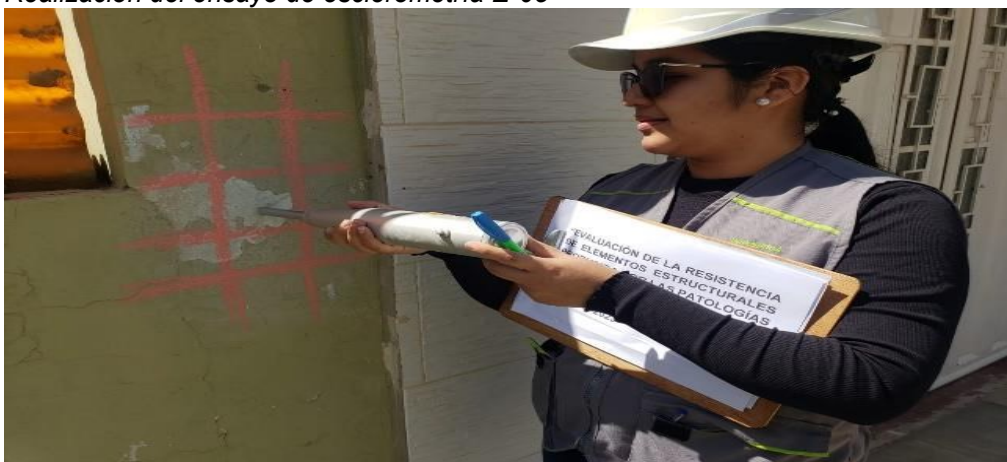
Figura 34 Realización del ensayo de esclerometría E-05
