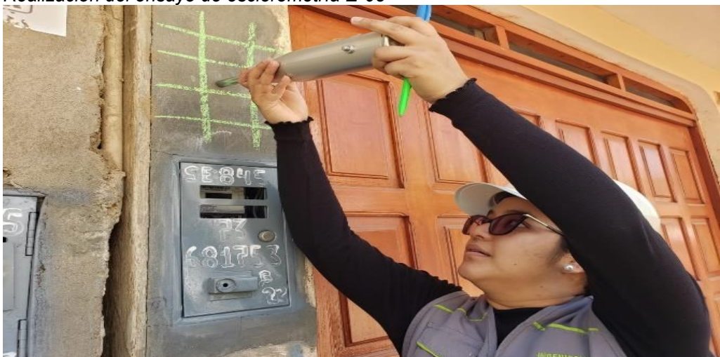
Figura 37 Realización del ensayo de esclerometría E-08
