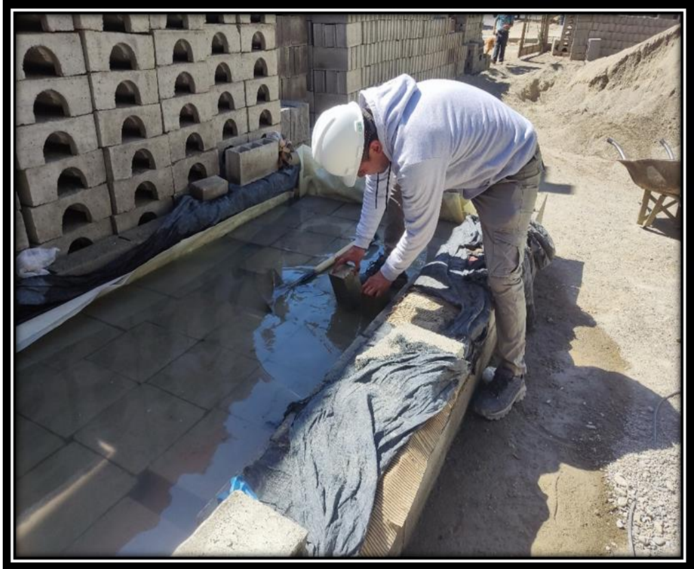
SE OBSERVA EL CURADO DEL ADOQUIN
