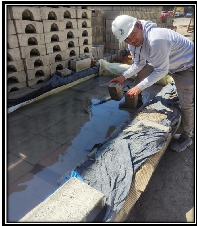
SE OBSERVA EL CURADO DEL ADOQUIN
