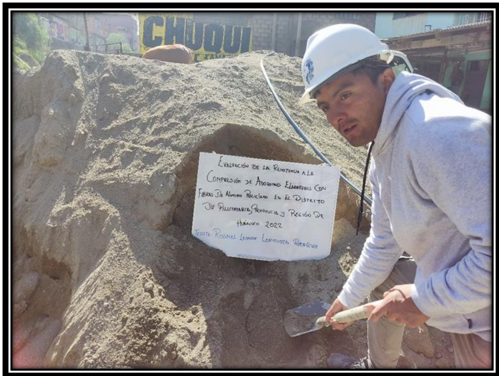
SE OBSERVA EL AGREGADO EXTRAIDO DE LA CANTERA
