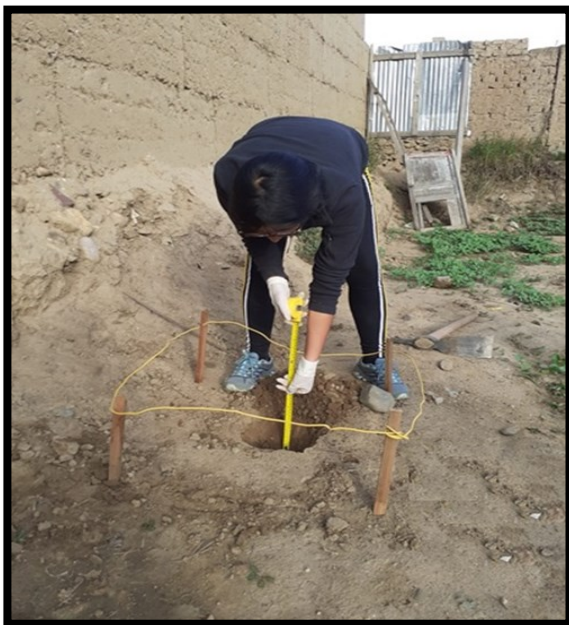
Figura 14 Calicata para la toma de muestra inicial
