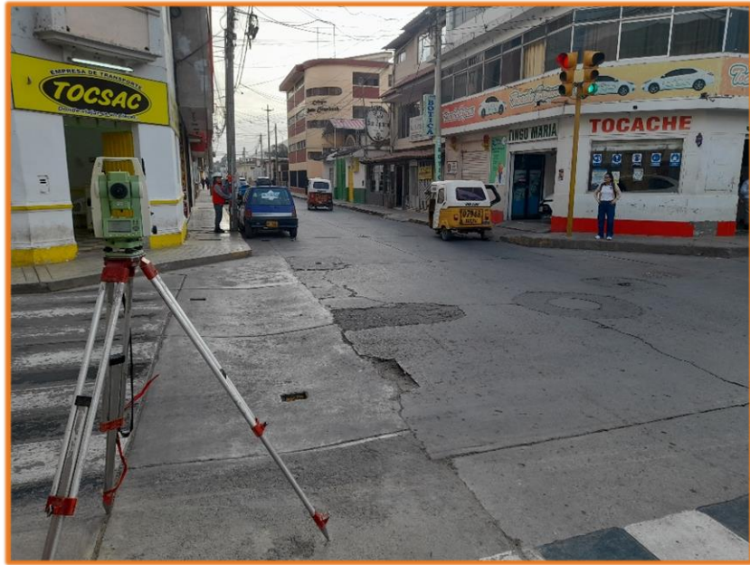
Se observa los trabajos de levantamiento topográfico del Jr. Bolívar.
