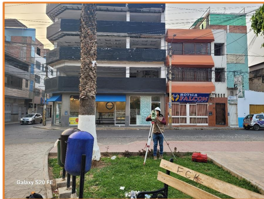
Se observa los trabajos de levantamiento topográfico del Jr. Damaso Beraún.
