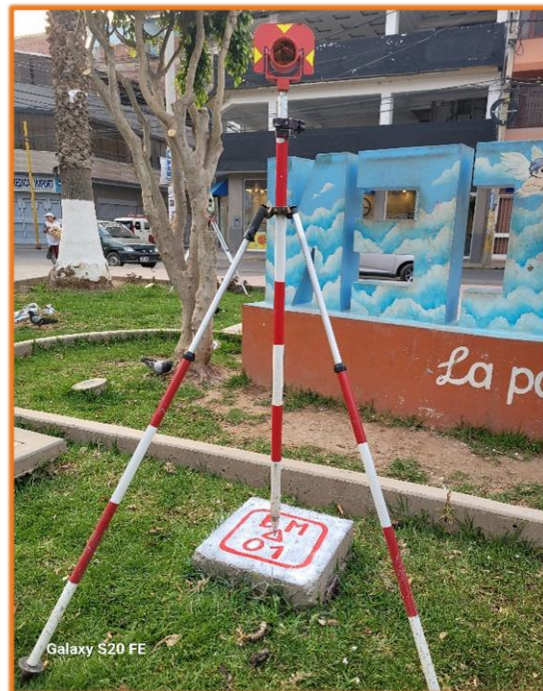
Se observa los trabajos de monumentado, pintado y lectura de los BM's en todas las calles intervenidas.
