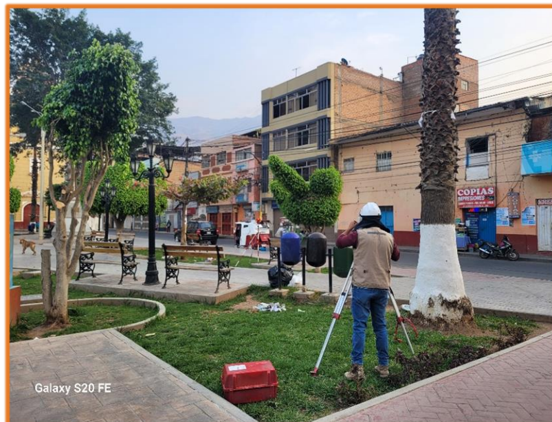
Inicio de los trabajos de levantamiento topográfico con el personal técnico y de apoyo.
