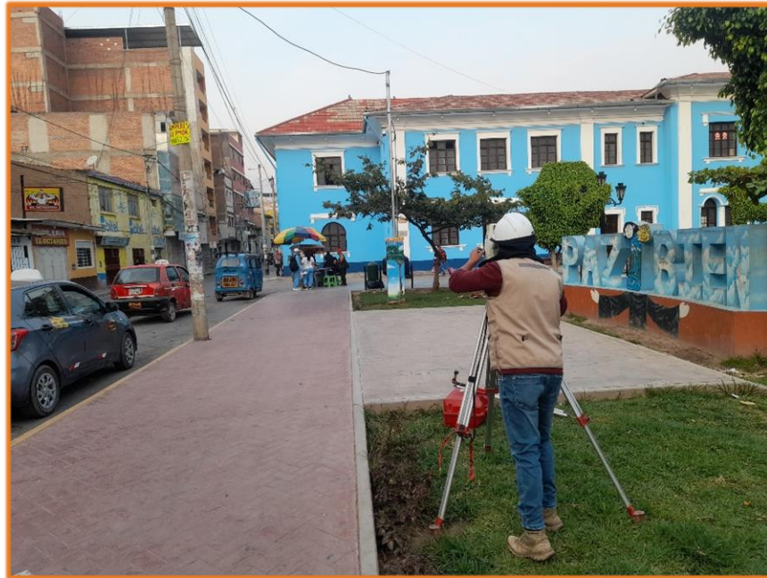
Se observa los trabajos de levantamiento topográfico del Jr. Huallayco.
