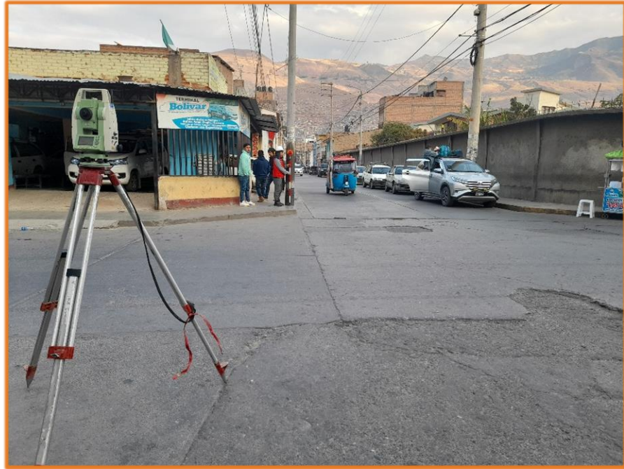
Se observa los trabajos de levantamiento topográfico del Jr. Ayacucho.
