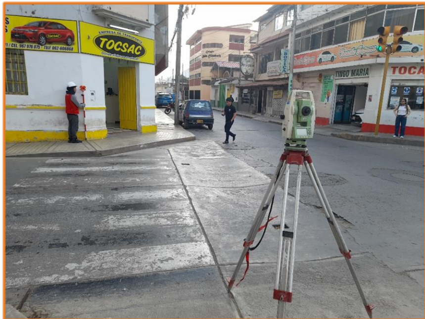
Se observa los trabajos de levantamiento topográfico de las intersecciones del Jr. Bolivar y el Jr. General Prado.
