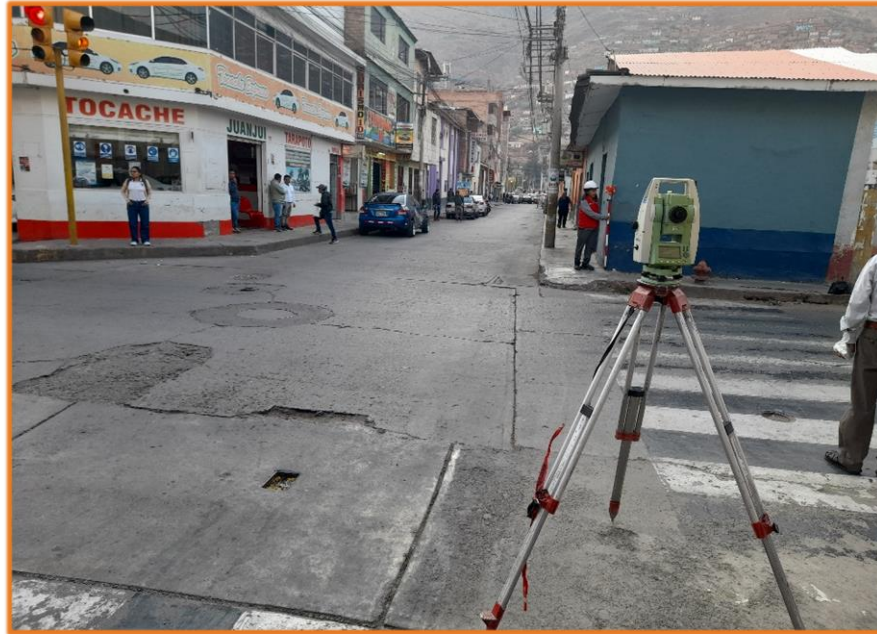
Se observa los trabajos de levantamiento topográfico del Jr. General Prado.
