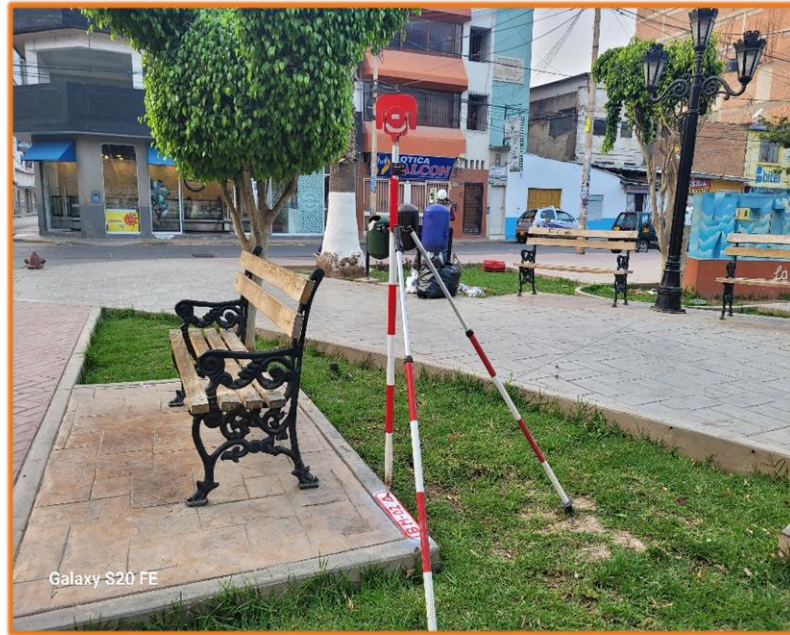
Se observa los trabajos de monumentado, pintado y lectura de los BM's en todas las calles intervenidas.
