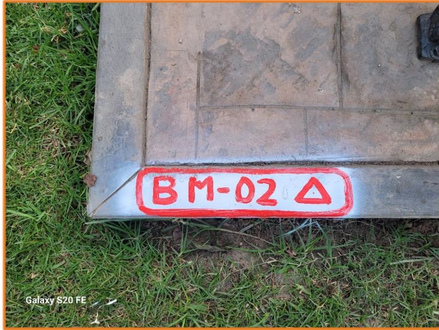
Trabajos del pintado de los BM's.
