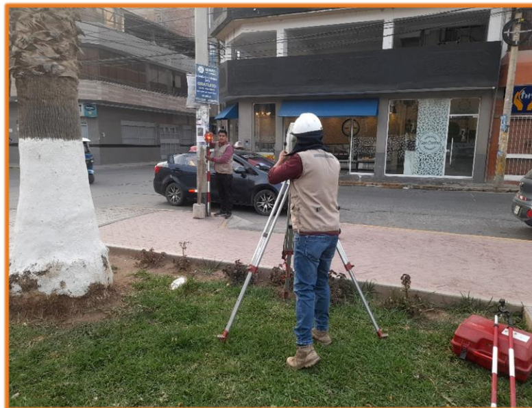
Se observa los trabajos de levantamiento topográfico del Jr. Huallayco.
