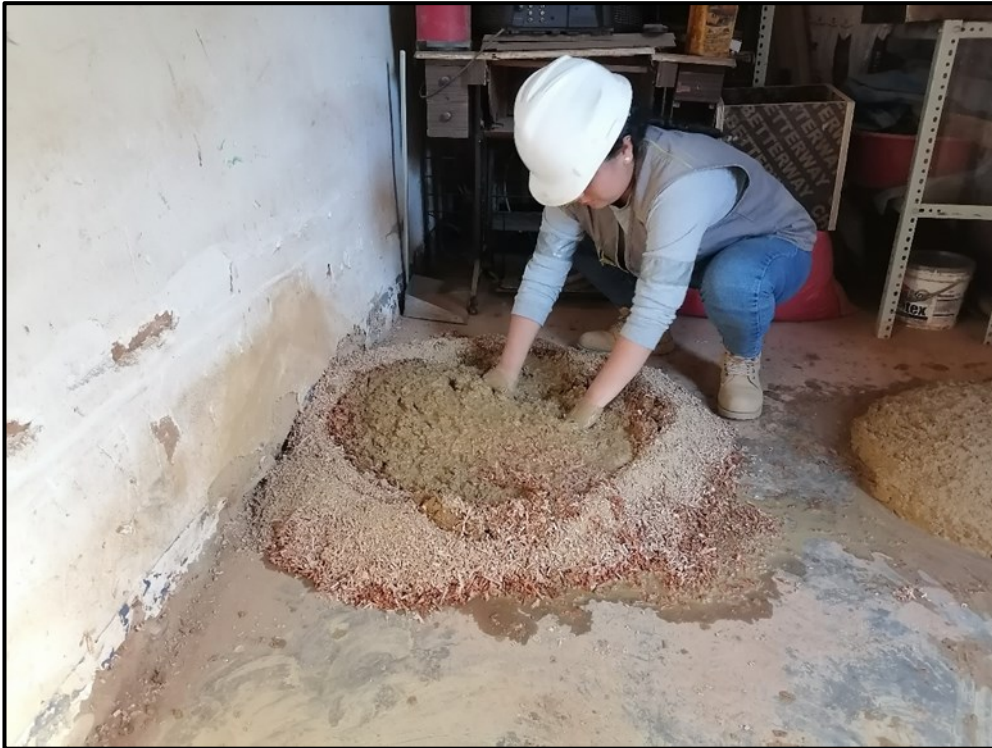
Figura 45 Elaboración del barro del adobe
