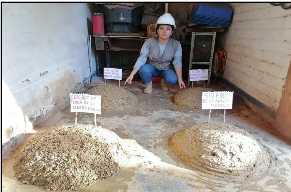
Figura 46 Elaboración del barro del adobe
